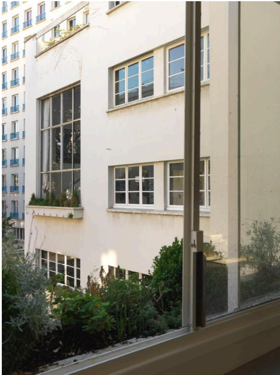
Vue du retour de l'immeuble Mallet-Stevens depuis la verrière de l'appartement-atelier de son concepteur
