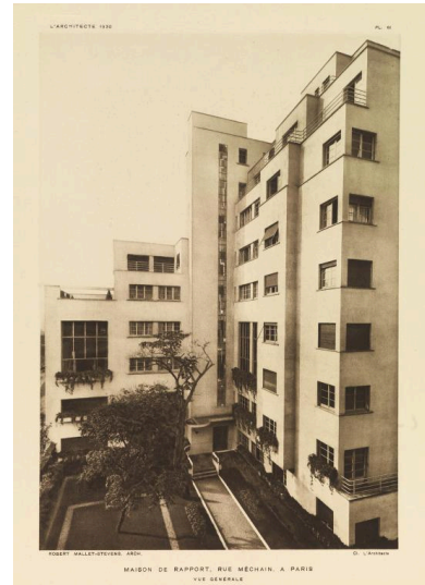
Vue générale de la maison de rapport rue Méchain, reproduite dans L'Architecte, 8e année, n°11, 1930, planche 61 IVR11_20197500088NUC4A
