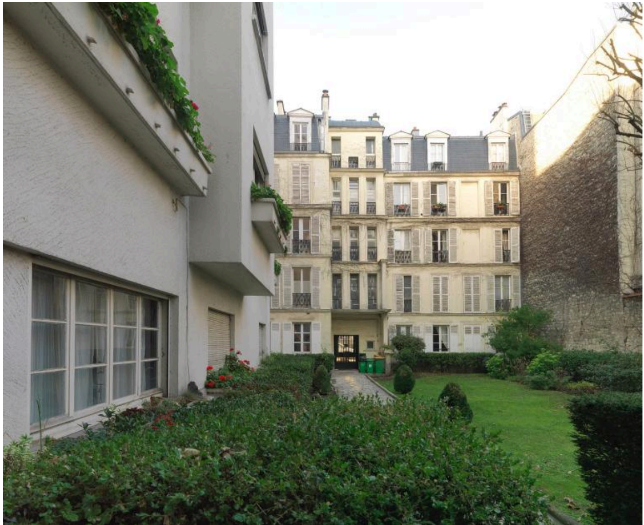
Façade arrière de l'immeuble construit sur rue, vue depuis la cour intérieure
