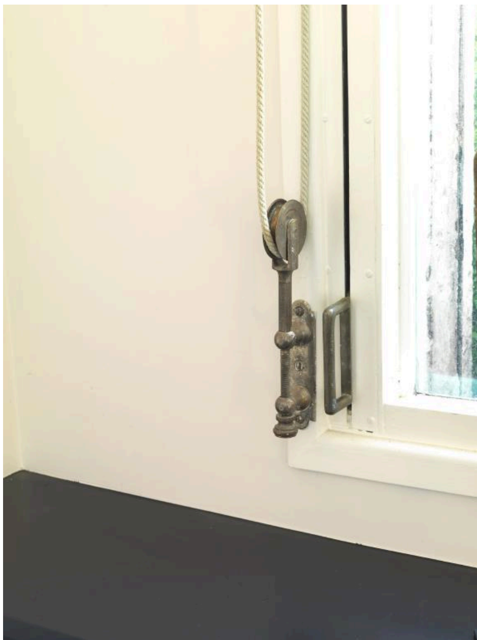
Détail d'une fenêtre de l'atelier de Mallet-Stevens
