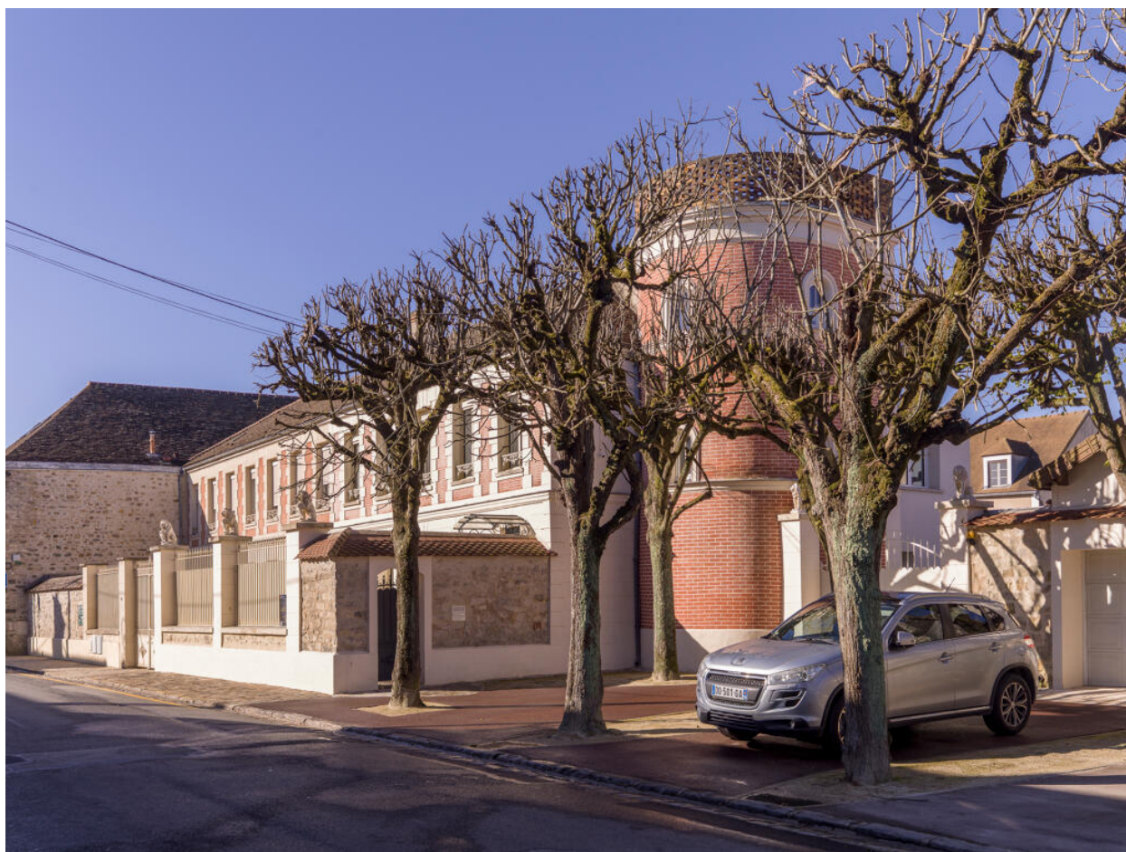
Vue générale du 24 et 26 boulevard du Maréchal Foch depuis le nord-est.
