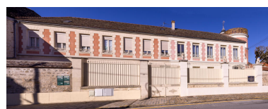
Vue générale du 24 et 26 boulevard du Maréchal Foch depuis le sud-est. Phot. Asseline Stéphane IVR11_20269100089NUC4A
