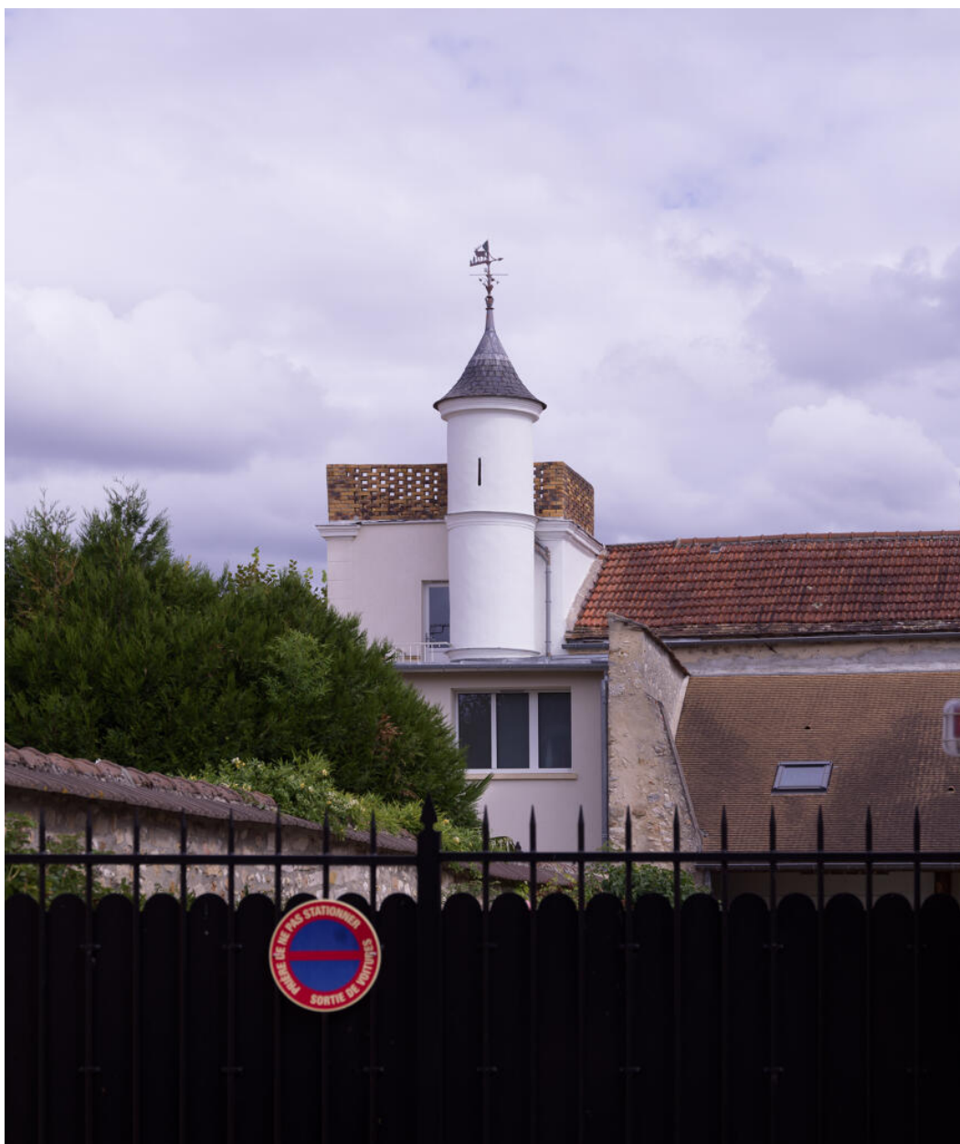
Vue de l'arrière du 24 boulevard Foch depuis la rue Charles Cochin (depuis l'ouest).
