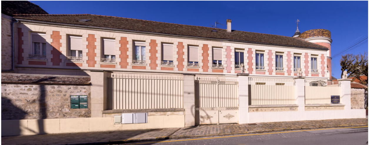
Vue générale du 24 et 26 boulevard du Maréchal Foch depuis le sud-est.
