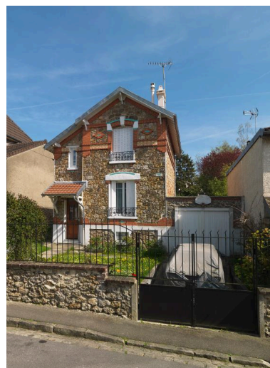
Pavillon 7, rue du Pré-Curé, construit par l'architecte écouennais Albert Bourgeois. Phot. Philippe Ayrault IVR11_20189500115NUC4A
