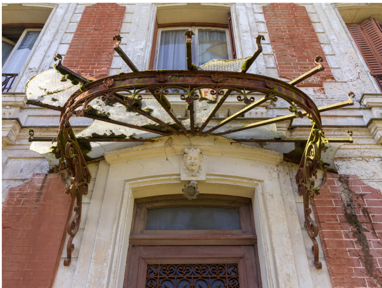
Vue de la marquise.
