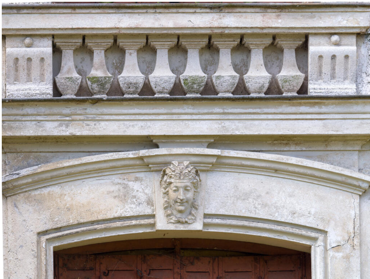
Détail du linteau de la baie ouest du rez-de-chaussée de la façade nord.
