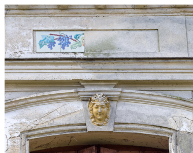
Détail du linteau de la baie ouest de l'étage de la façade nord. Phot. Asseline Stéphane IVR11_20259100675NUC4A
