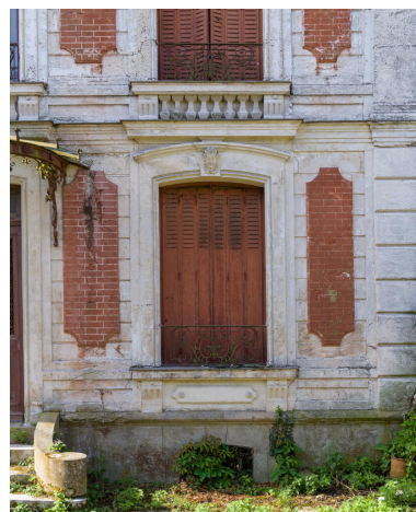
Détail du côté ouest de la façade nord. Phot. Asseline Stéphane IVR11_20259100674NUC4A
