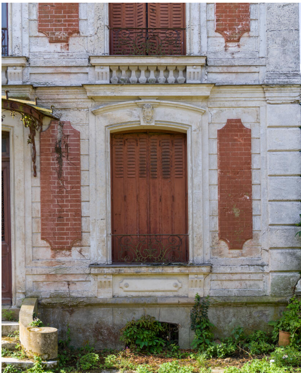
Détail du côté ouest de la façade nord.
