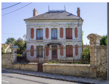
Vue générale du 8 rue de la Chapelle depuis le nord-ouest. Phot. Asseline Stéphane IVR11_20259101047NUC4A
