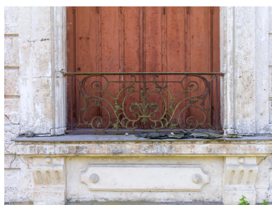
Détail de la partie basse de la baie ouest du rez-de- chaussée de la façade nord. Phot. Asseline Stéphane IVR11_20259100677NUC4A
