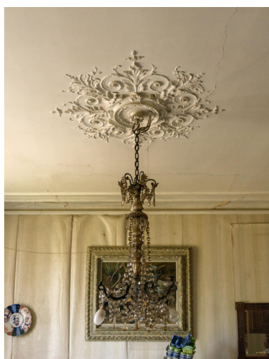
Moulures du plafond d'une pièce du rez-de-chaussée.
