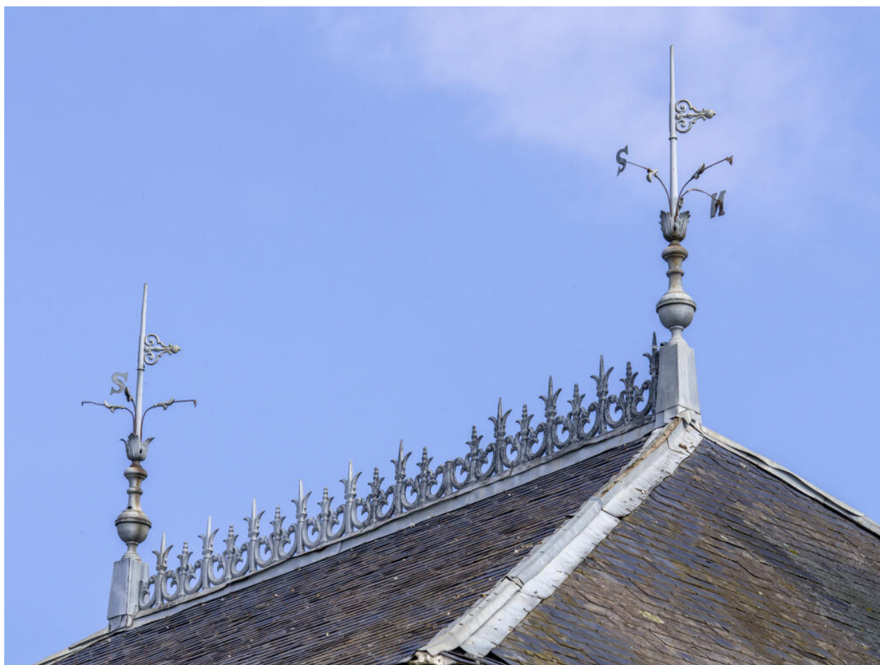
Vue de la crête de toit.
