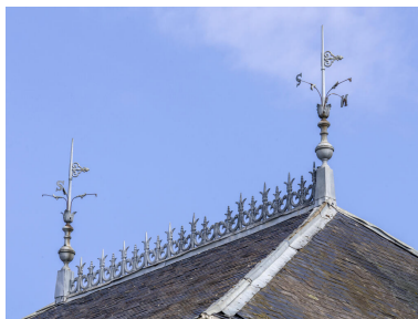
Vue de la crête de toit. Phot. Asseline Stéphane IVR11_20259100670NUC4A
