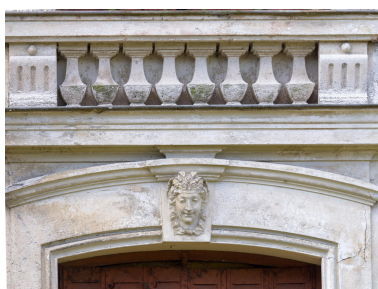
Détail du linteau de la baie ouest du rez-de-chaussée de la façade nord. Phot. Asseline Stéphane IVR11_20259100676NUC4A
