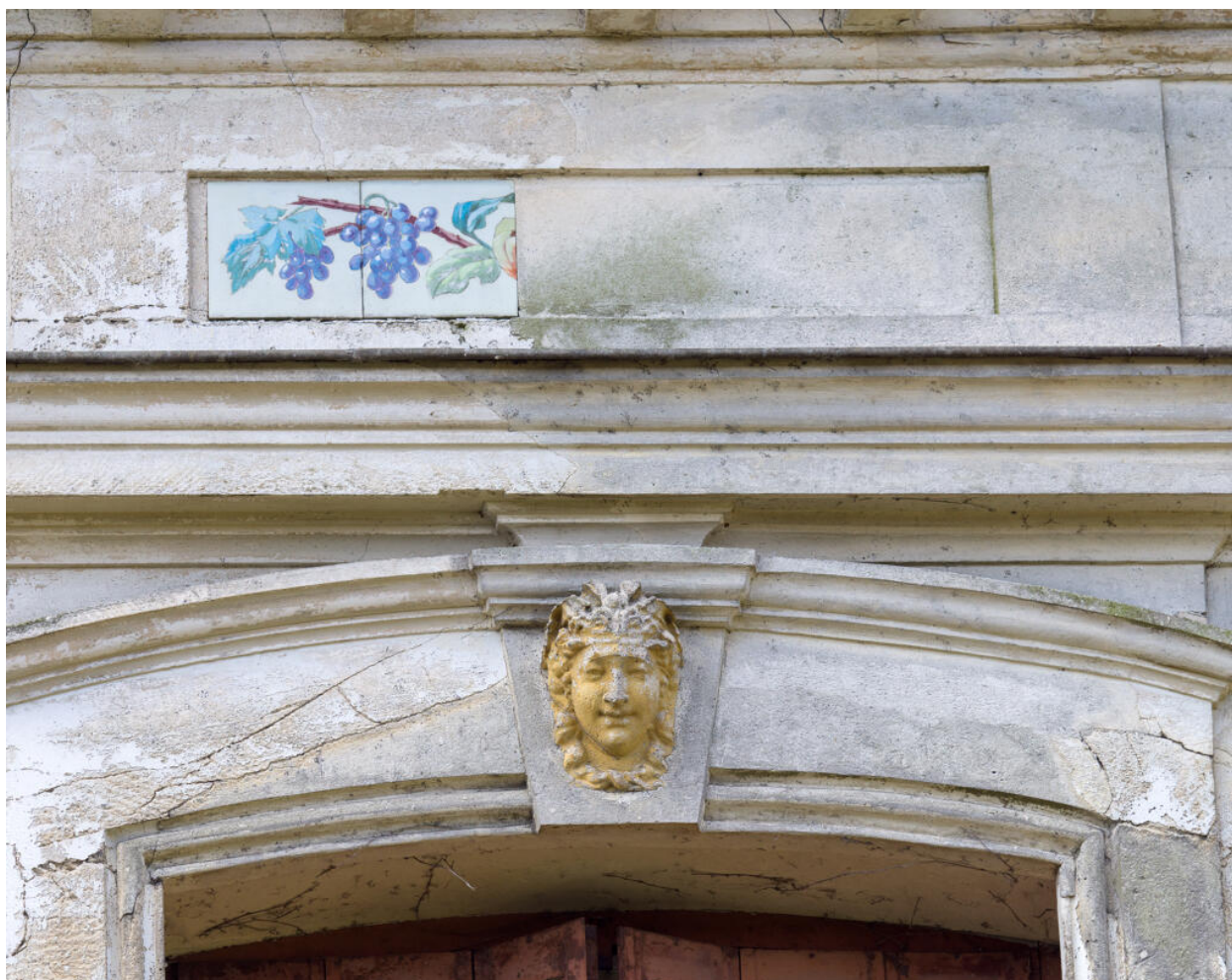
Détail du linteau de la baie ouest de l'étage de la façade nord.
