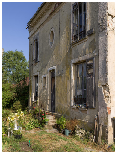
Vue générale de la façade sud depuis le sud-est. Phot. Asseline Stéphane IVR11_20259100679NUC4A
