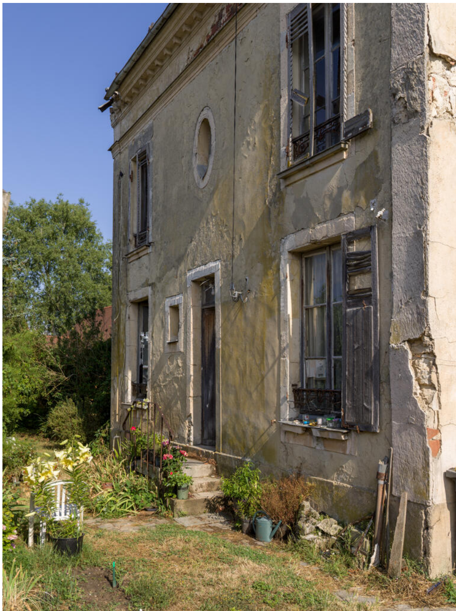
Vue générale de la façade sud depuis le sud-est.
