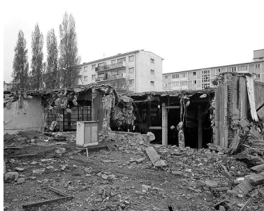
Chaufferie, façade est. Campagne photographique, lors de la destruction du bâtiment en 1976. Phot. Pascal Corbière IVR11_19769300051X
