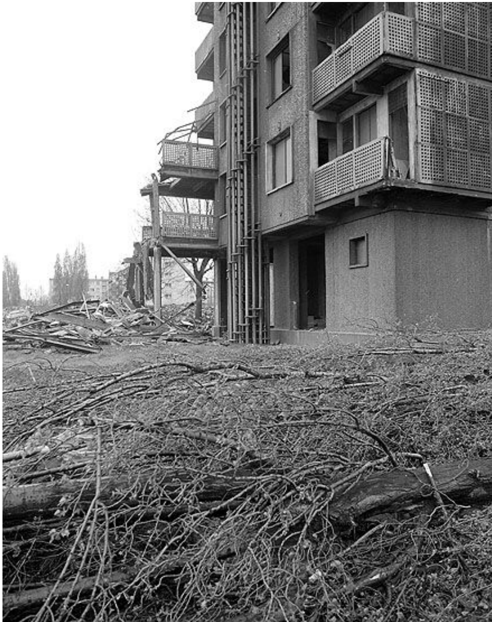
Tour 1 - Façade est, défaut du portique. Campagne photographique, lors de la destruction du bâtiment en 1976.
