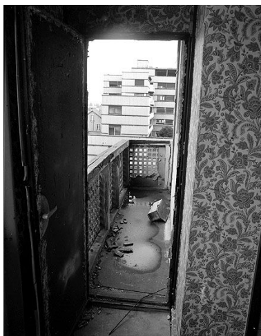
Tour 1 - cage d'ascenseur, vue du 15ème étage. Campagne photographique, lors de la destruction du bâtiment en 1976. Phot. Pascal Corbière IVR11_19769300038X
