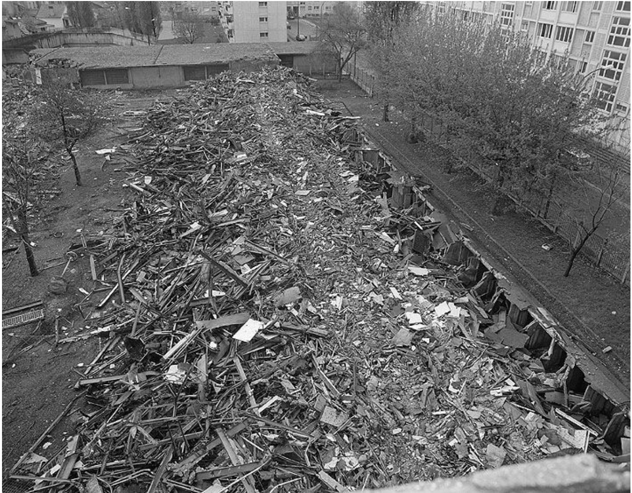
Restes du peigne P1 et des galeries techniques menant de la Tour 1 à la Chaufferie. Campagne photographique, lors de la destruction du bâtiment en 1976.
