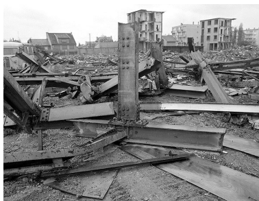
Détail des ossatures métalliques d'une tour. Campagne photographique, lors de la destruction du bâtiment en 1976. Phot. Pascal Corbière IVR11_19769300003X
