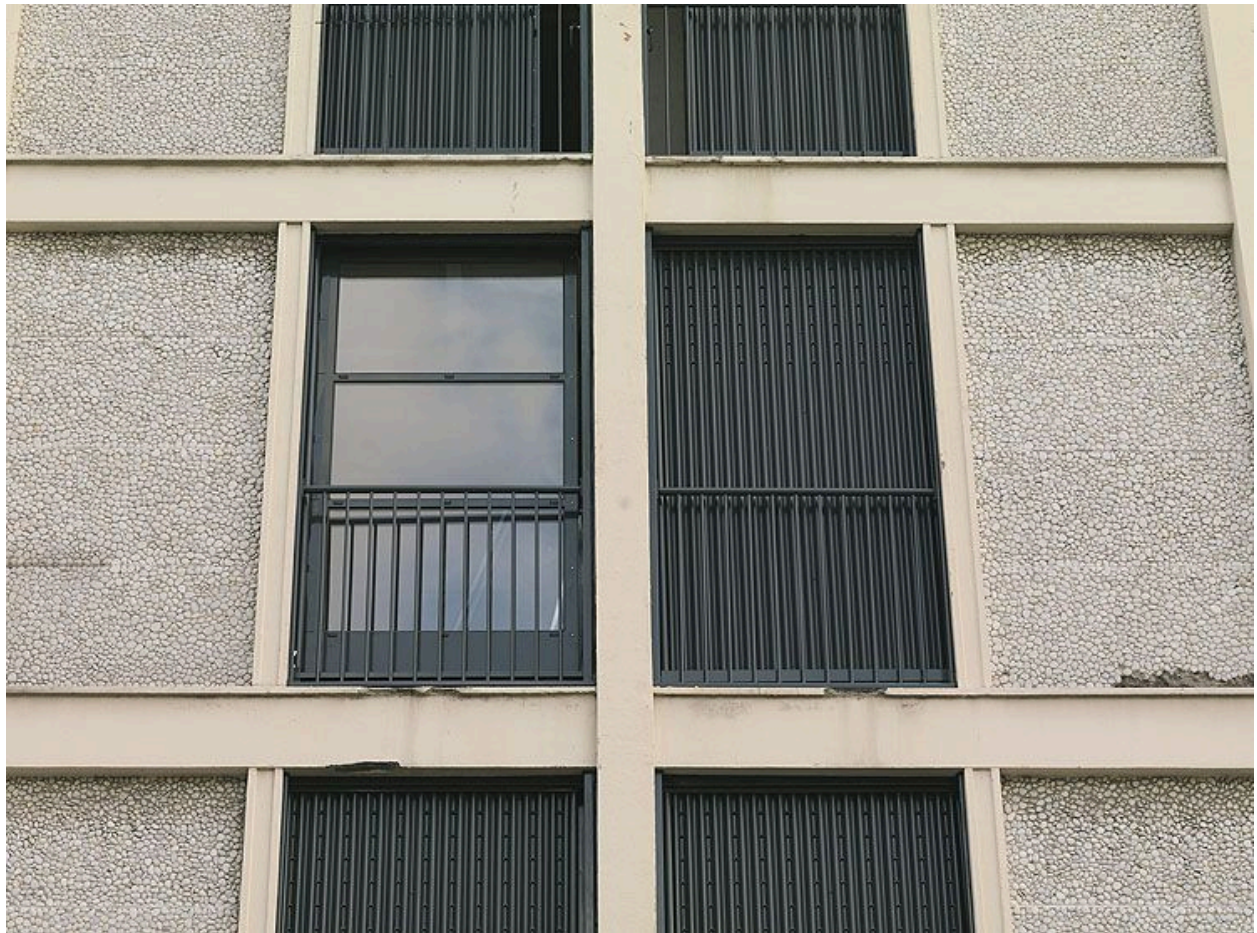
Détail de la façade après travaux.
