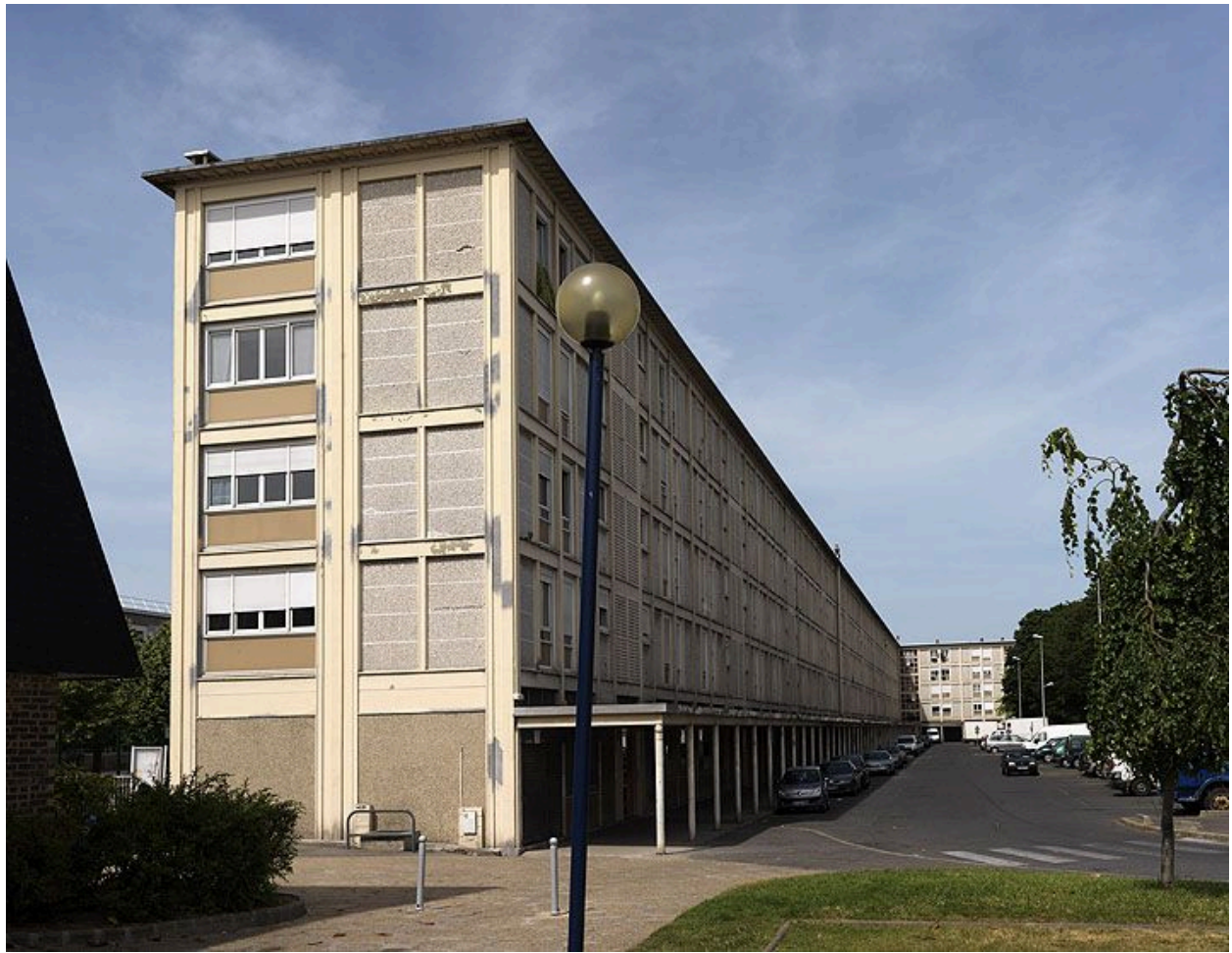
Vue de l'aile dont les huisseries ont été changées en 1999, avant le classement Monument historique du bâtiment.
