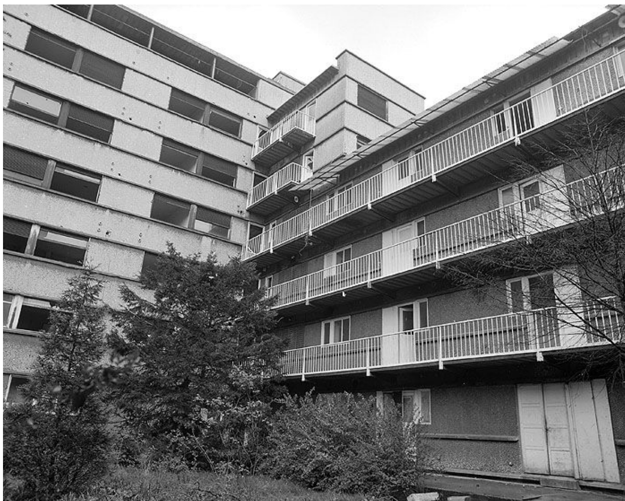
Bâtiment A - Cour ouest, coin nord est. Campagne photographique, lors de la destruction du bâtiment en 1976.
