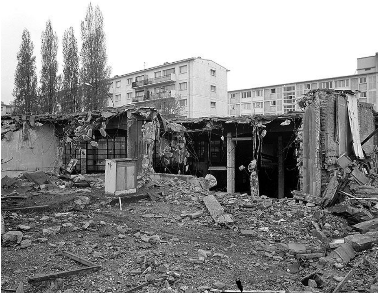
Chaufferie, façade est. Campagne photographique, lors de la destruction du bâtiment en 1976.
