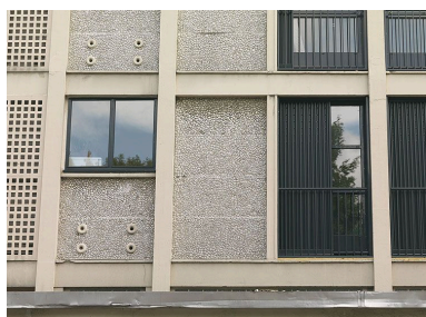
Détail de la façade après travaux. Phot. Jean-Bernard Vialles IVR11_20099300612NUC4A
