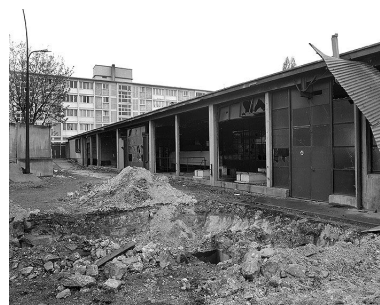
Chaufferie - Façade sud. Campagne photographique, lors de la destruction du bâtiment en 1976. Phot. Pascal Corbière IVR11_19769300064X
