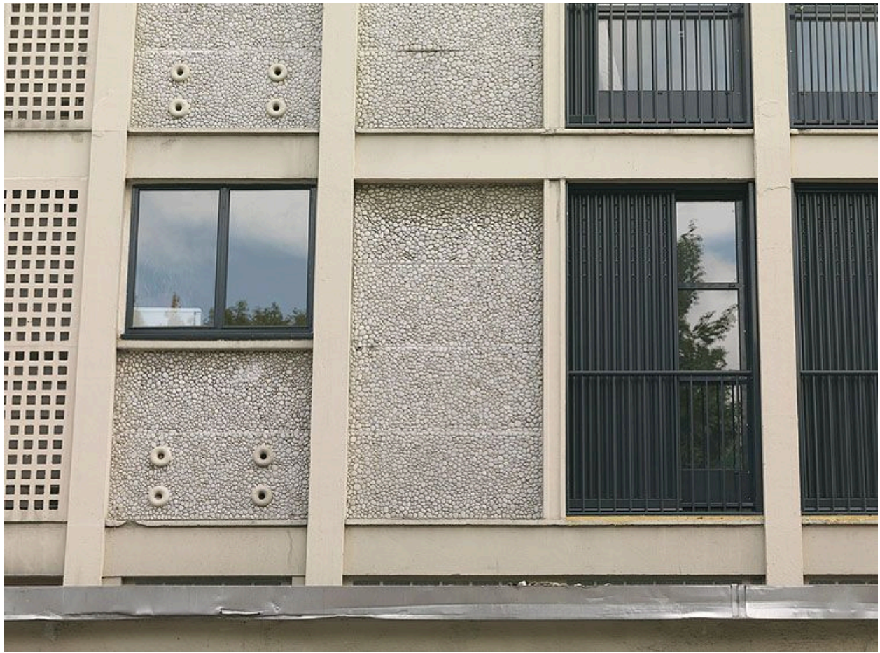
Détail de la façade après travaux.
