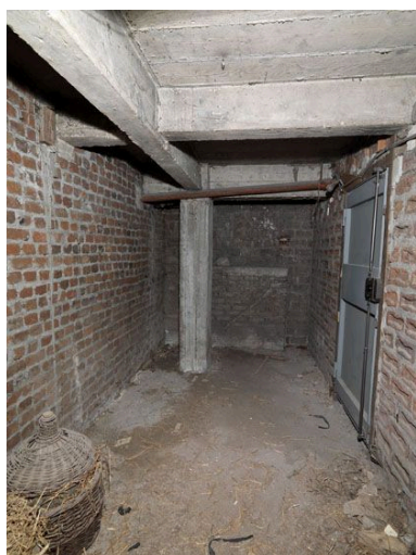
Vue générale la première cave prison. Phot. Jean-Bernard Vialles IVR11_20109300057NUC4A
