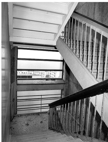
Tour 1, cage d'escalier entre 9ème et 10ème étage. Campagne photographique, lors de la destruction du bâtiment en 1976. Phot. Pascal Corbière IVR11_19769300011X
