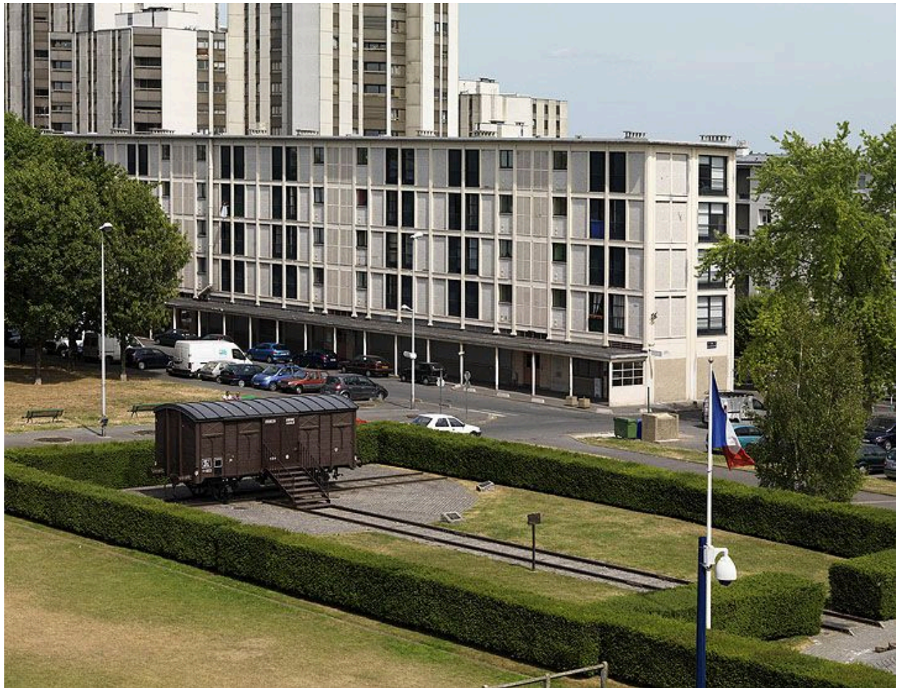
Vue rapprochée depuis le Mémorial de Drancy en chantier.
