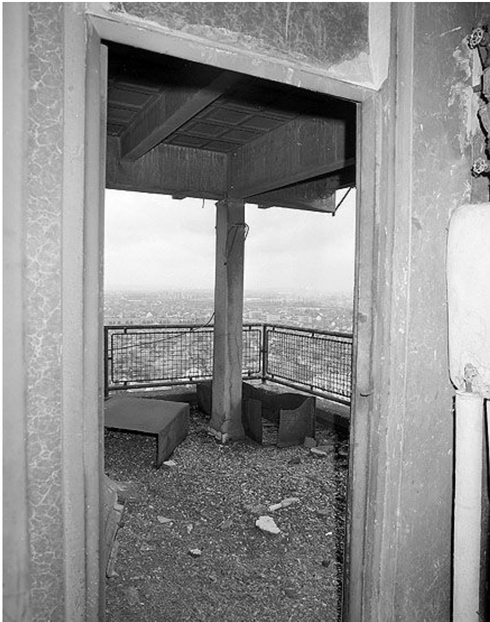
Tour 1, 15ème étage - terrasse, cour nord ouest. Campagne photographique, lors de la destruction du bâtiment en 1976.
