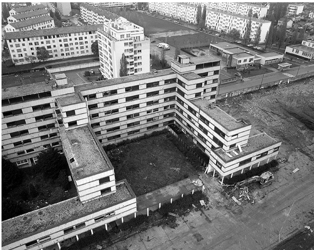
Bâtiment A, Cour est, vue de la Tour 1. Campagne photographique, lors de la destruction du bâtiment en 1976.
