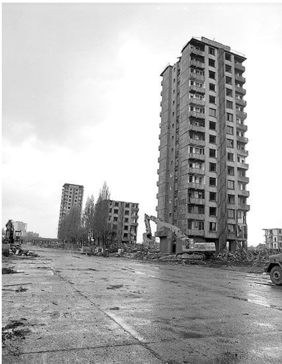
Cour vue générale des tours 2, 3 et 5. Campagne photographique, lors de la destruction du bâtiment en 1976.
