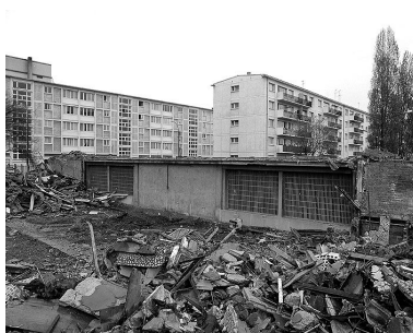
Chaufferie, façade nord. Campagne photographique, lors de la destruction du bâtiment en 1976. Phot. Pascal Corbière IVR11_19769300028X
