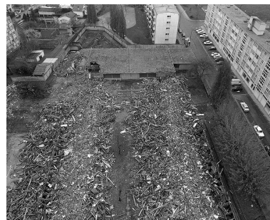
Au fond la chaufferie, les deux tas de débris parallèles sont les restes des peignes P1 et P2. Vue de la tour T1. Campagne photographique, lors de la destruction du bâtiment en 1976. Phot. Pascal Corbière IVR11_19769300015X
