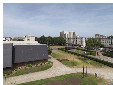
Vue générale depuis le Mémorial de Drancy en cours de chantier. Phot. Jean-Bernard Vialles IVR11_20119300080NUC4A
