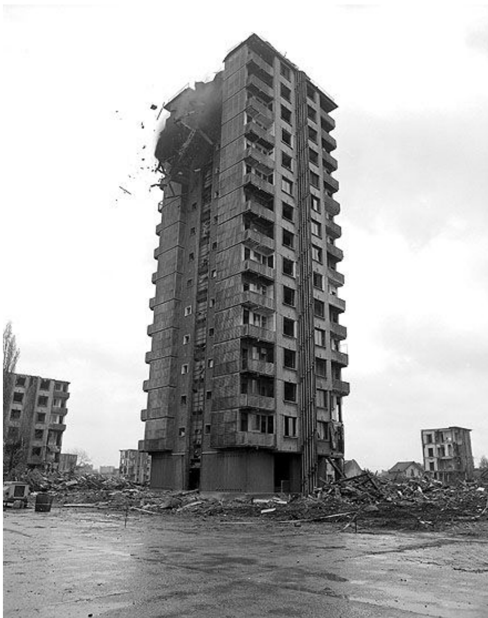
Tour 2 - Chute de l'étage supérieur. Campagne photographique, lors de la destruction du bâtiment en 1976.
