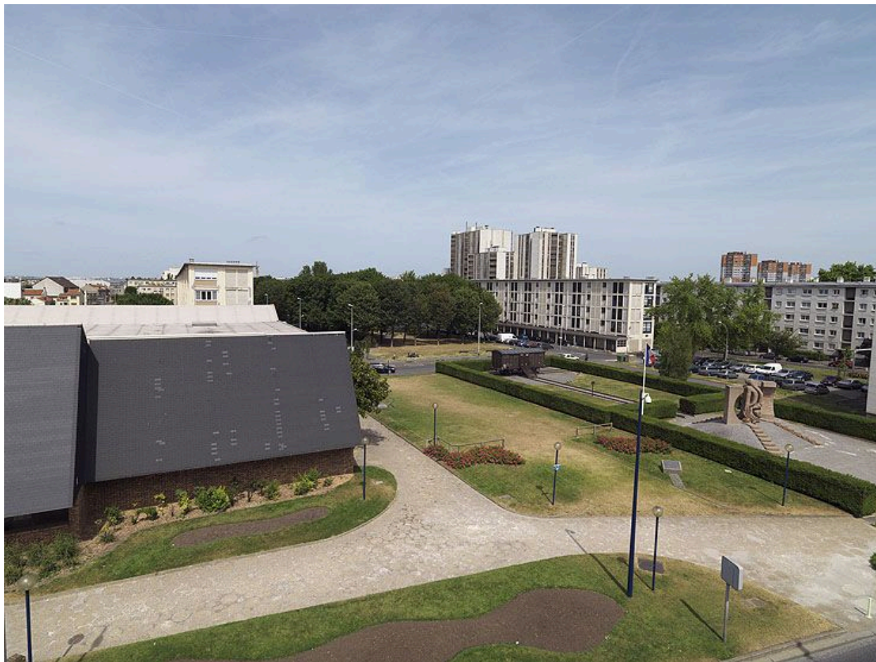
Vue générale depuis le Mémorial de Drancy en cours de chantier.
