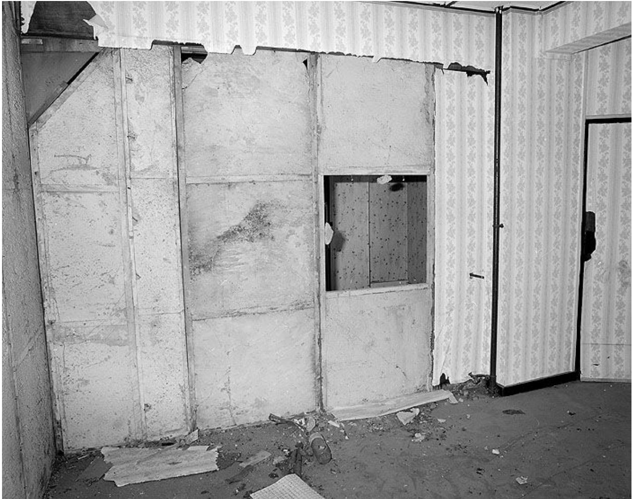
Tour 5 - 3ème étage, façade ouest. Construction d'un mur intérieur. Campagne photographique, lors de la destruction du bâtiment en 1976.
