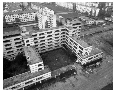
Bâtiment A, Cour est, vue de la Tour 1. Campagne photographique, lors de la destruction du bâtiment en 1976.
