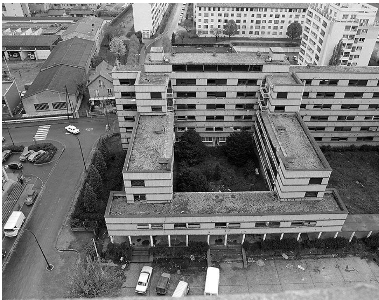
Bâtiment A. Partie ouest. Vue de la Tour 1. Campagne photographique, lors de la destruction du bâtiment en 1976.
