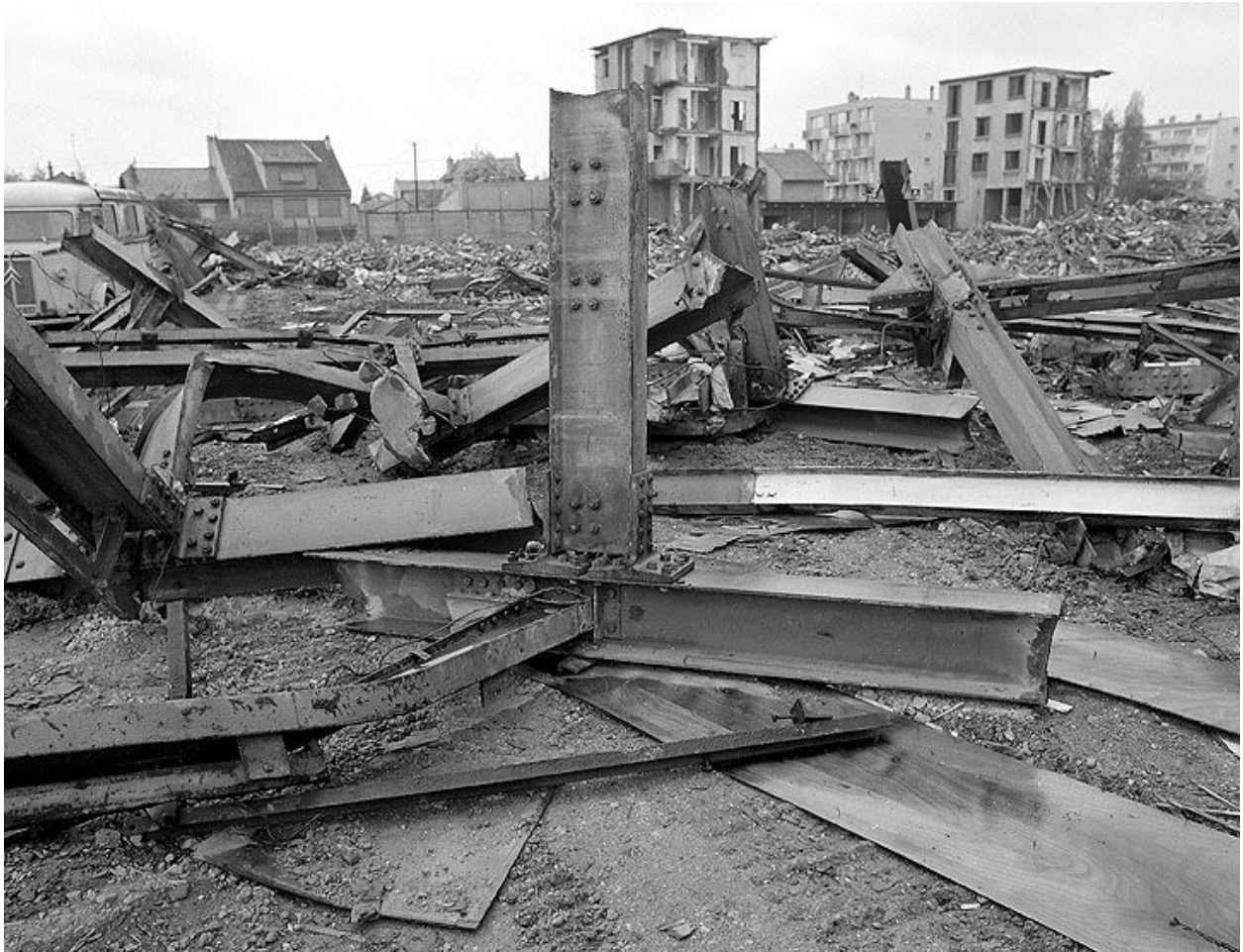
Détail des ossatures métalliques d'une tour. Campagne photographique, lors de la destruction du bâtiment en 1976.
