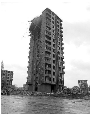
Tour 2 - Chute de l'étage supérieur. Campagne photographique, lors de la destruction du bâtiment en 1976. Phot. Pascal Corbière IVR11_19769300041X
