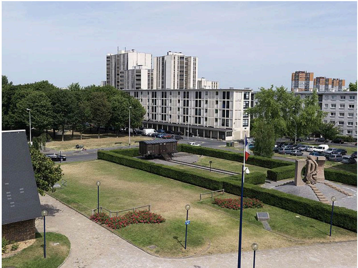
Vue rapprochée depuis le Mémorial de Drancy en chantier.
