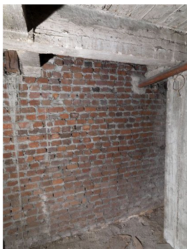
Mur de la première cave prison. Phot. Jean-Bernard Vialles IVR11_20109300059NUC4A
