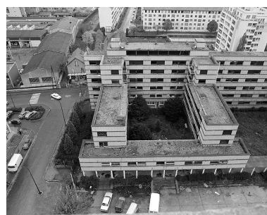
Bâtiment A. Partie ouest. Vue de la Tour 1. Campagne photographique, lors de la destruction du bâtiment en 1976. Phot. Pascal Corbière IVR11_19769300034X
