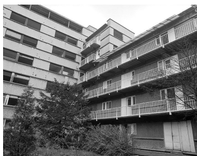
Bâtiment A - Cour ouest, coin nord est. Campagne photographique, lors de la destruction du bâtiment en 1976. Phot. Pascal Corbière IVR11_19769300044X
