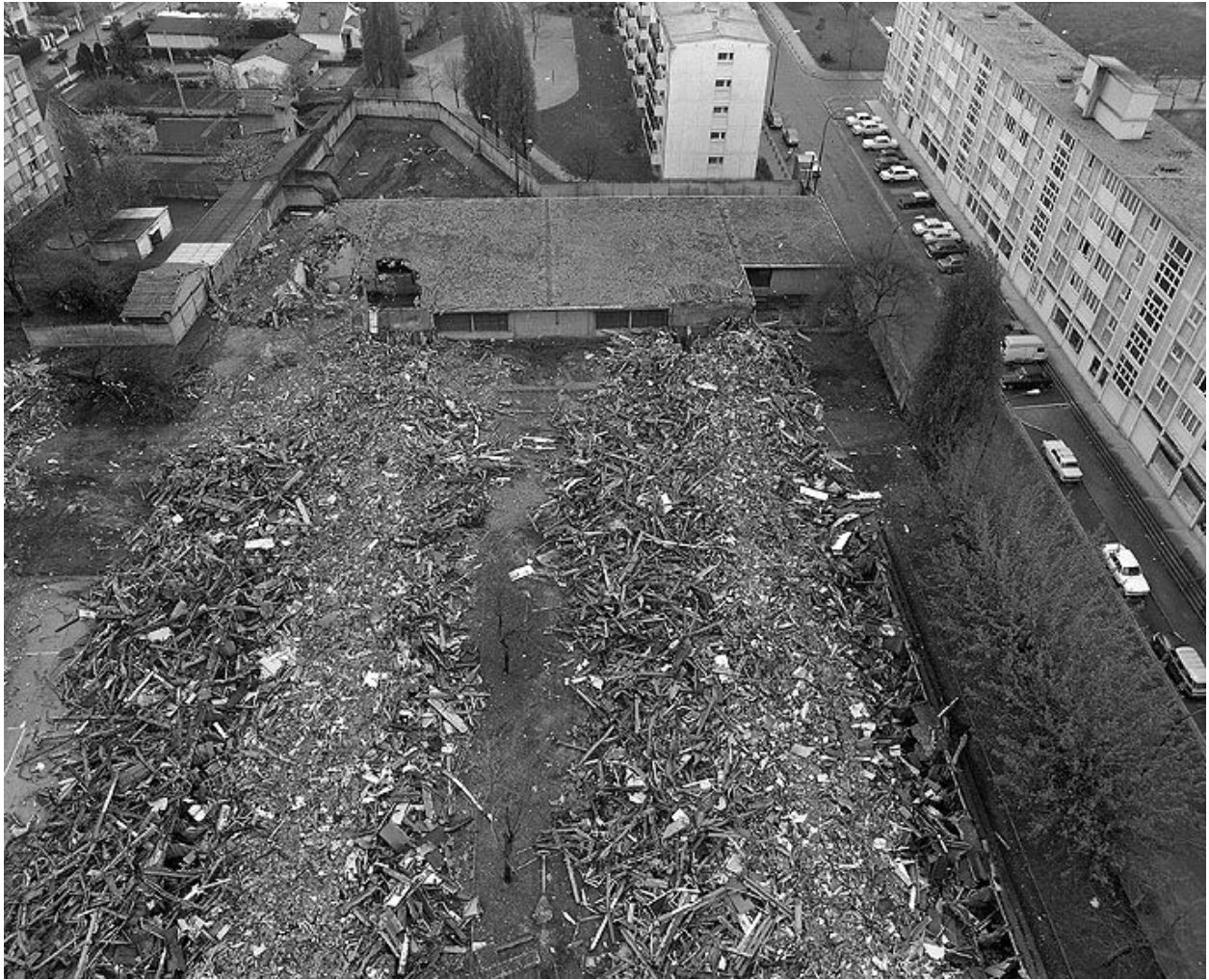
Au fond la chaufferie, les deux tas de débris parallèles sont les restes des peignes P1 et P2. Vue de la tour T1. Campagne photographique, lors de la destruction du bâtiment en 1976.
