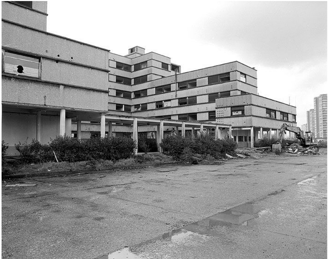
Bâtiment A - Façade sud sur cour (cour est). Campagne photographique, lors de la destruction du bâtiment en 1976.
