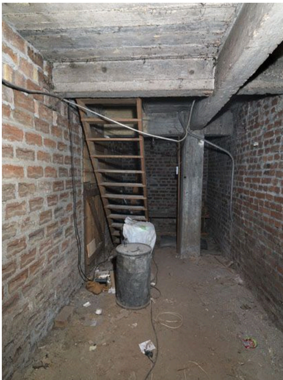
Vue générale de la première cave prison.
