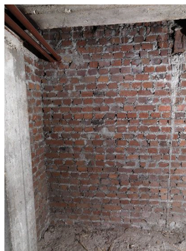
Mur de la première cave prison. Phot. Jean-Bernard Vialles IVR11_20109300058NUC4A
