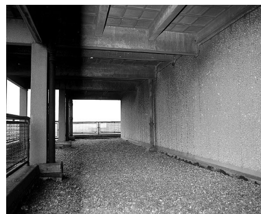
Tour 1. Terrasse 15ème étage. Campagne photographique, lors de la destruction du bâtiment en 1976. Phot. Pascal Corbière IVR11_19769300016X
