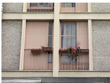
Détail de la façade avant travaux, avec les huisseries de J. Prouvé encore en place. Phot. Jean-Bernard Vialles IVR11_20099300613NUC4A
