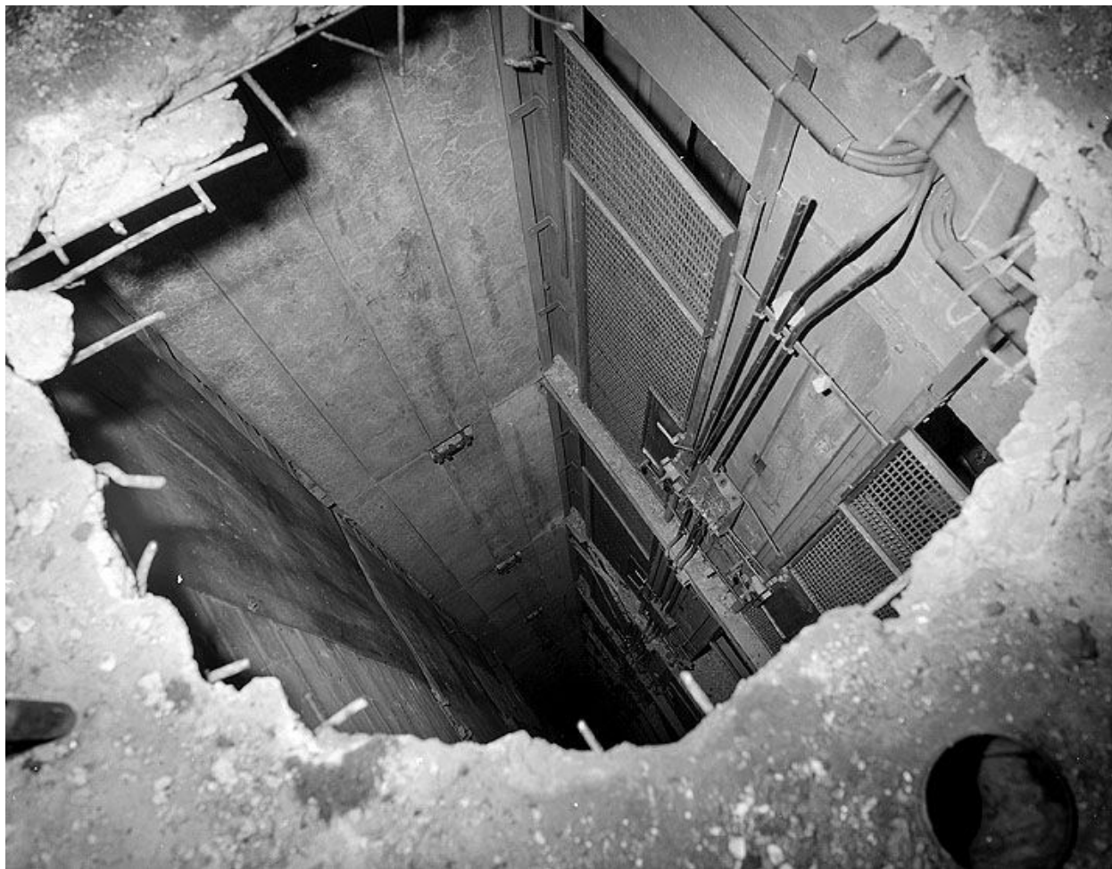
Tour 1 - cage d'ascenseur, vue du 15ème étage. Campagne photographique, lors de la destruction du bâtiment en 1976.
