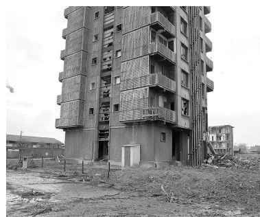
Tour 5, angle nord-ouest. Campagne photographique, lors de la destruction du bâtiment en 1976. Phot. Pascal Corbière IVR11_19769300007X
