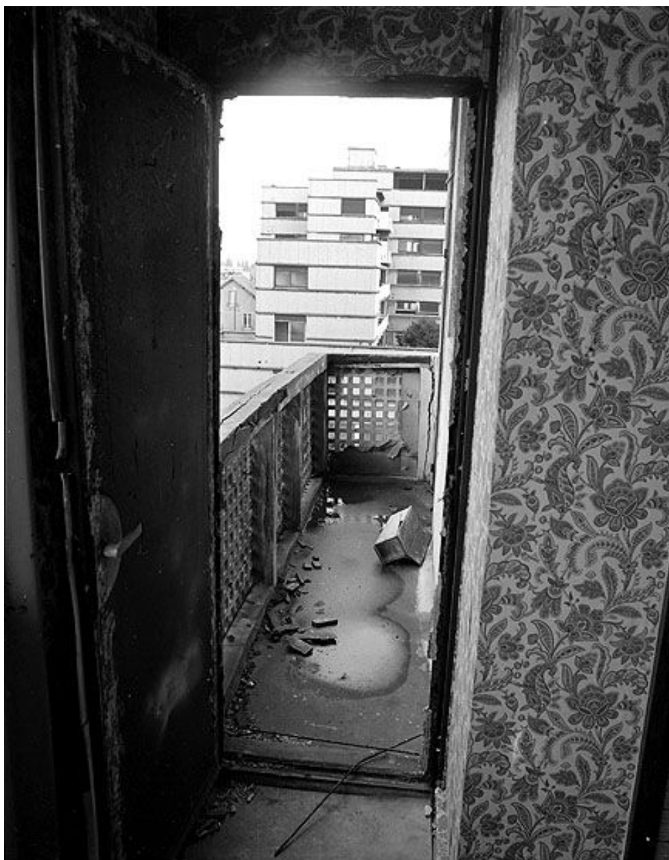
Tour1, façade est, balcon cuisine. Campagne photographique, lors de la destruction du bâtiment en 1976.
