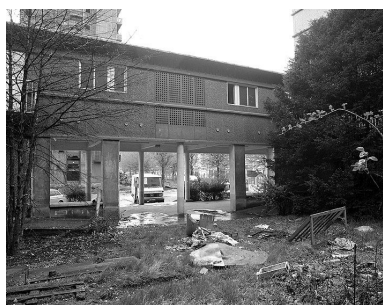
Bâtiment A - Cour ouest, façade nord du portique sur cette cour. Campagne photographique, lors de la destruction du bâtiment en 1976. Phot. Pascal Corbière IVR11_19769300045X
