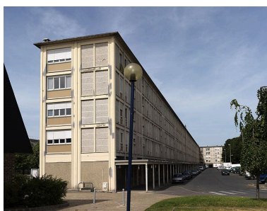
Vue de l'aile dont les huisseries ont été changées en 1999, avant le classement Monument historique du bâtiment. Phot. Jean-Bernard Vialles IVR11_20119300084NUC4A
