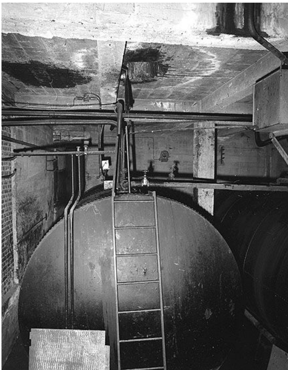
Chaufferie, cuve et plafond. Campagne photographique, lors de la destruction du bâtiment en 1976.
