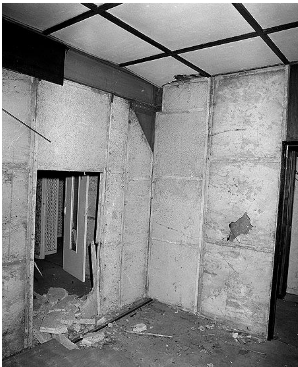
Tour 5 - 3ème étage - Appartement, technique de construction. Campagne photographique, lors de la destruction du bâtiment en 1976.
