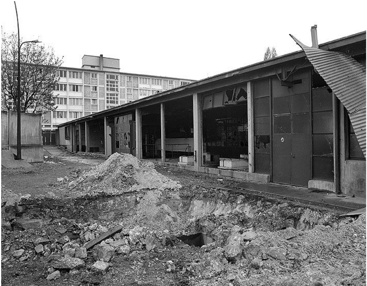
Chaufferie - Façade sud. Campagne photographique, lors de la destruction du bâtiment en 1976.
