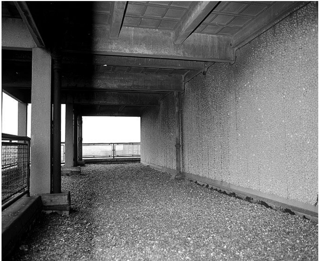
Tour 1. Terrasse 15ème étage. Campagne photographique, lors de la destruction du bâtiment en 1976.
