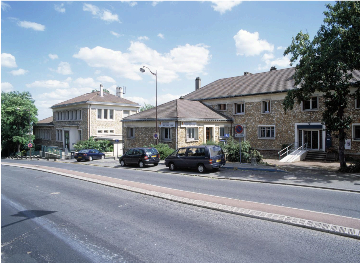
Vue d'ensemble du bâtiment qui abrite la perception et le Centre médico-psychopédagogique Tony-Lainé (ancienne caisse d'épargne) et de la Caisse primaire d'assurance maladie.
