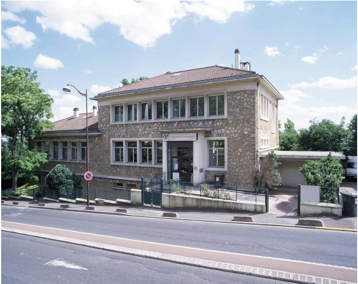
Vue d'ensemble du bâtiment situé au n° 3 : la Caisse primaire d'assurance maladie.
