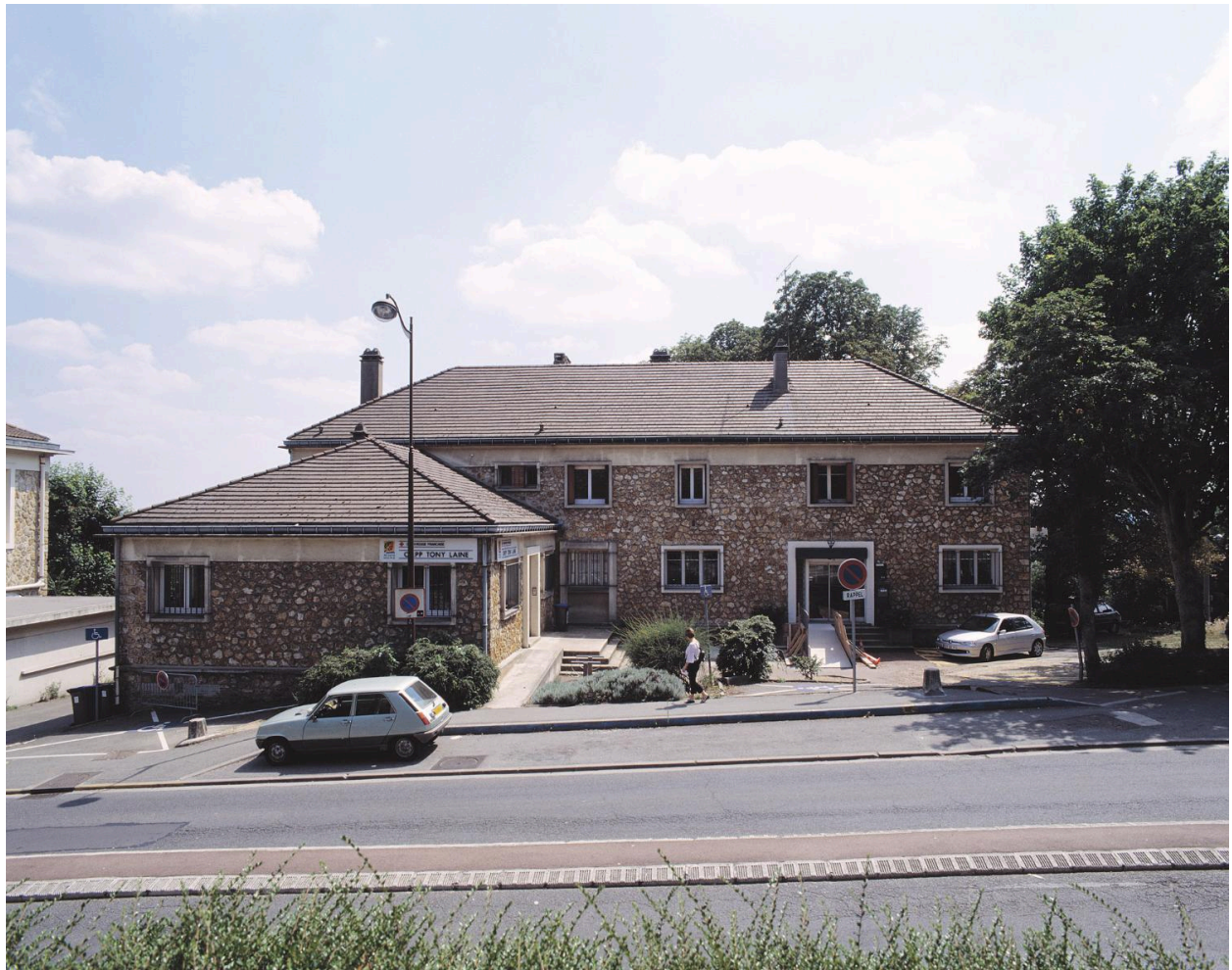
Vue d'ensemble du bâtiment qui abrite la perception et le Centre médico-psychopédagogique Tony-Lainé (ancienne caisse d'épargne).
