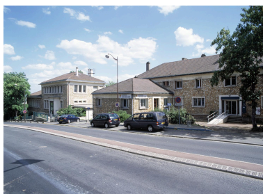
Vue d'ensemble du bâtiment qui abrite la perception et le Centre médico-psychopédagogique Tony-Lainé (ancienne caisse d'épargne) et de la Caisse primaire d'assurance maladie. Phot. Philippe Ayrault IVR11_20049100482XA
