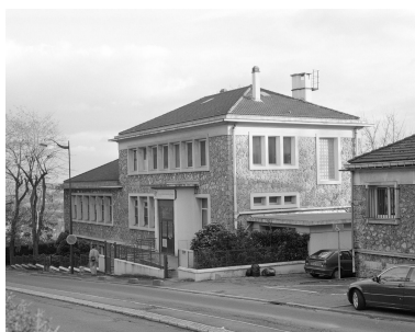
Vue d'ensemble du bâtiment de la Caisse primaire d'assurance maladie situé 3, avenue Aristide-Briand. Phot. Philippe Ayrault IVR11_20019100806X
