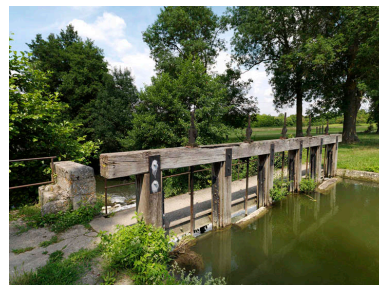
Vanne de barrage au bord de l'étang de Ravanne. Phot. Philippe Ayrault IVR11_20147700368NUC4A
