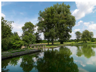
Vanne de barrage au bord de l'étang de Ravanne. Phot. Philippe Ayrault IVR11_20147700366NUC4A
