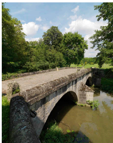
Le vieux pont enjambant l'Orvanne. Phot. Philippe Ayrault IVR11_20147700377NUC4A
