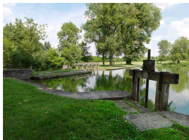
Vanne au bord de l'étang de Ravanne. Phot. Philippe Ayrault IVR11_20147700365NUC4A
