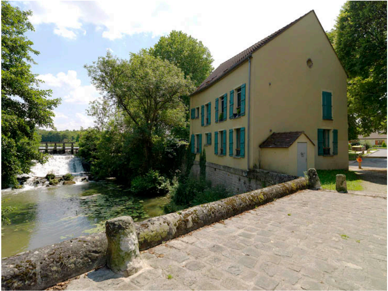
La cascade de la vanne de barrage de l'étang et d'un bâtiment vus du vieux pont enjambant l'Orvanne.
