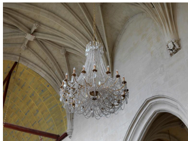
Vue du lustre d'église suspendu dans le chœur. Phot. Jean-Bernard Vialles IVR11_20169500037NUC4A
