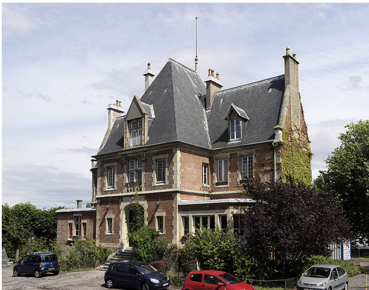
Vue d'ensemble de la façade d'entrée.
