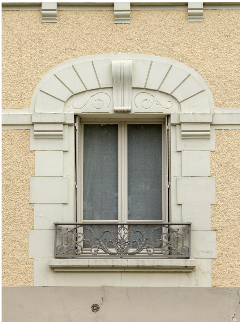
Détail de la façade sur rue.
