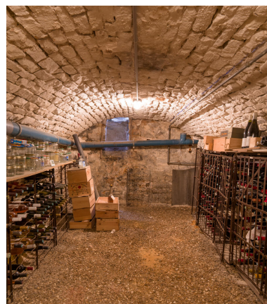
La cave, vue depuis le nord. Phot. Asseline Stéphane IVR11_20259100281NUC4A
