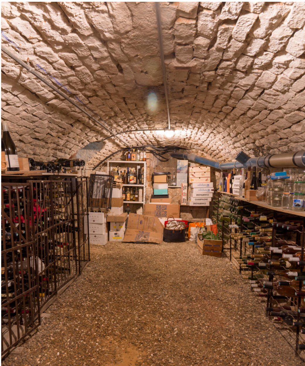
La cave, vue depuis le sud.
