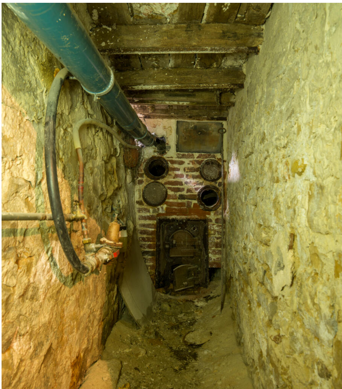
Réduit jouxtant la cave et bordant la rue, vue depuis l'est.
