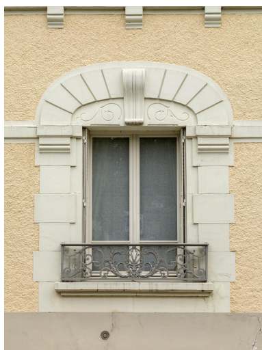
Détail de la façade sur rue. Phot. Asseline Stéphane IVR11_20259100278NUC4A
