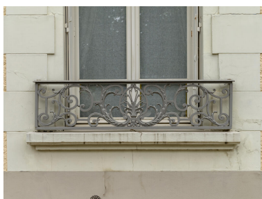
Garde-corps d'une baie de la façade sur rue. Phot. Asseline Stéphane IVR11_20259100279NUC4A
