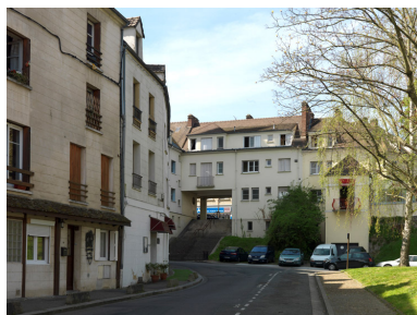
La place Simond : confrontation de la vieille ville et de la Reconstruction. Phot. Laurent Kruszyk IVR11_20157800223NUC4A
