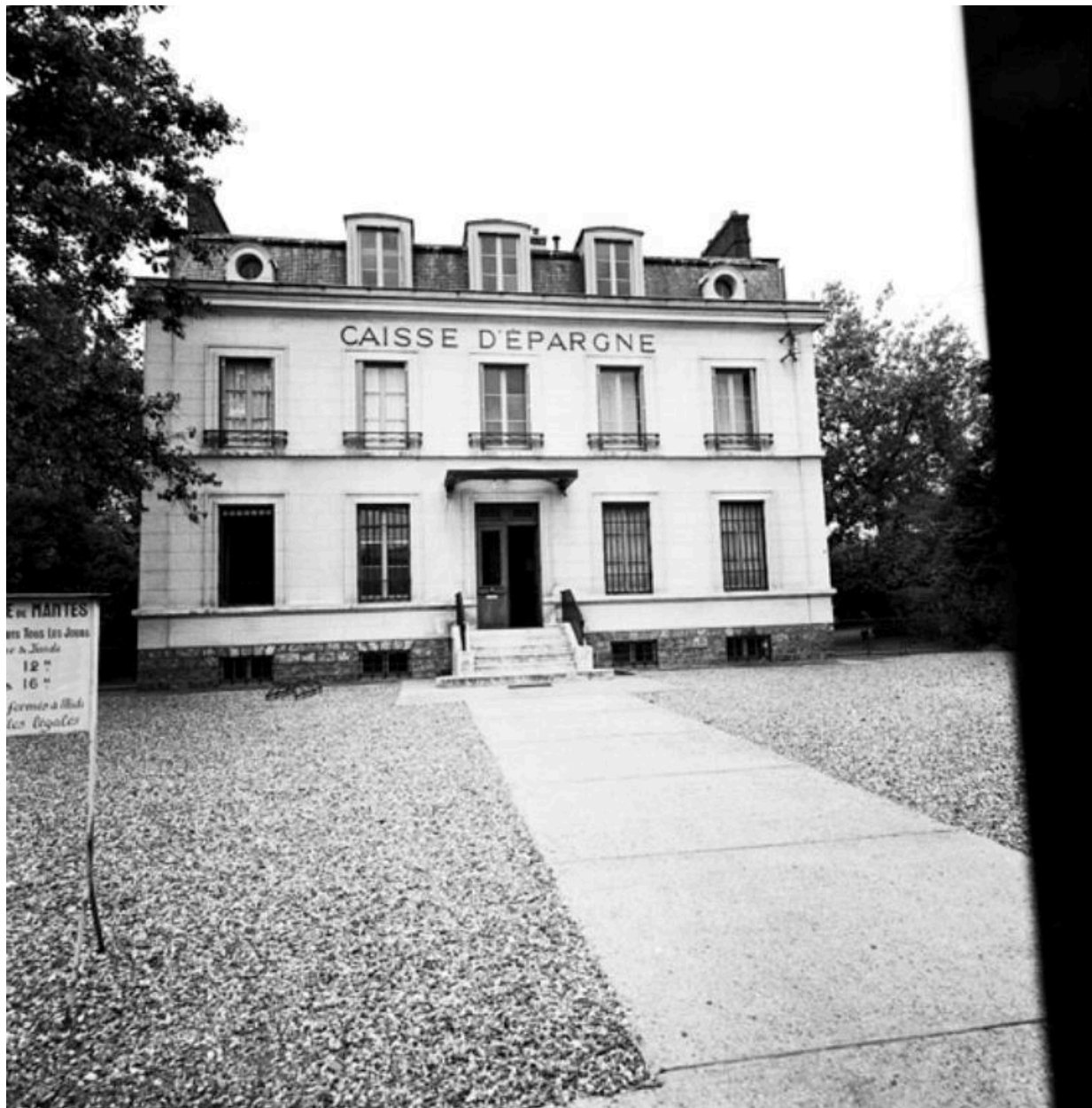
L'ancien bâtiment de la Caisse d'Epargne. (Fonds Bertin).
