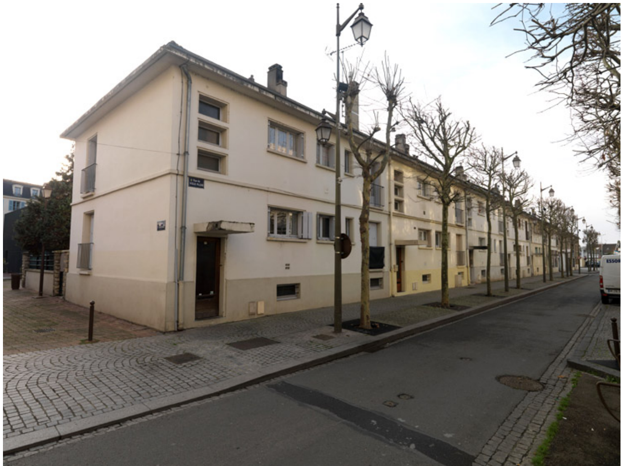
Maisons des années 50, rue du Vieux Pilon.
