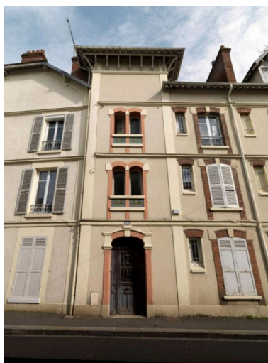
31, rue des Pélerins, ancien hôtel du Sapeur Pompier, entrée. Phot. Laurent Kruszyk IVR11_20167800393NUC4A
