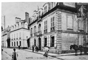
La chambre des notaires, rue Gambetta. Carte postale. Phot. CREDOP, Phot. Laurent Kruszyk IVR11_20157800100X
