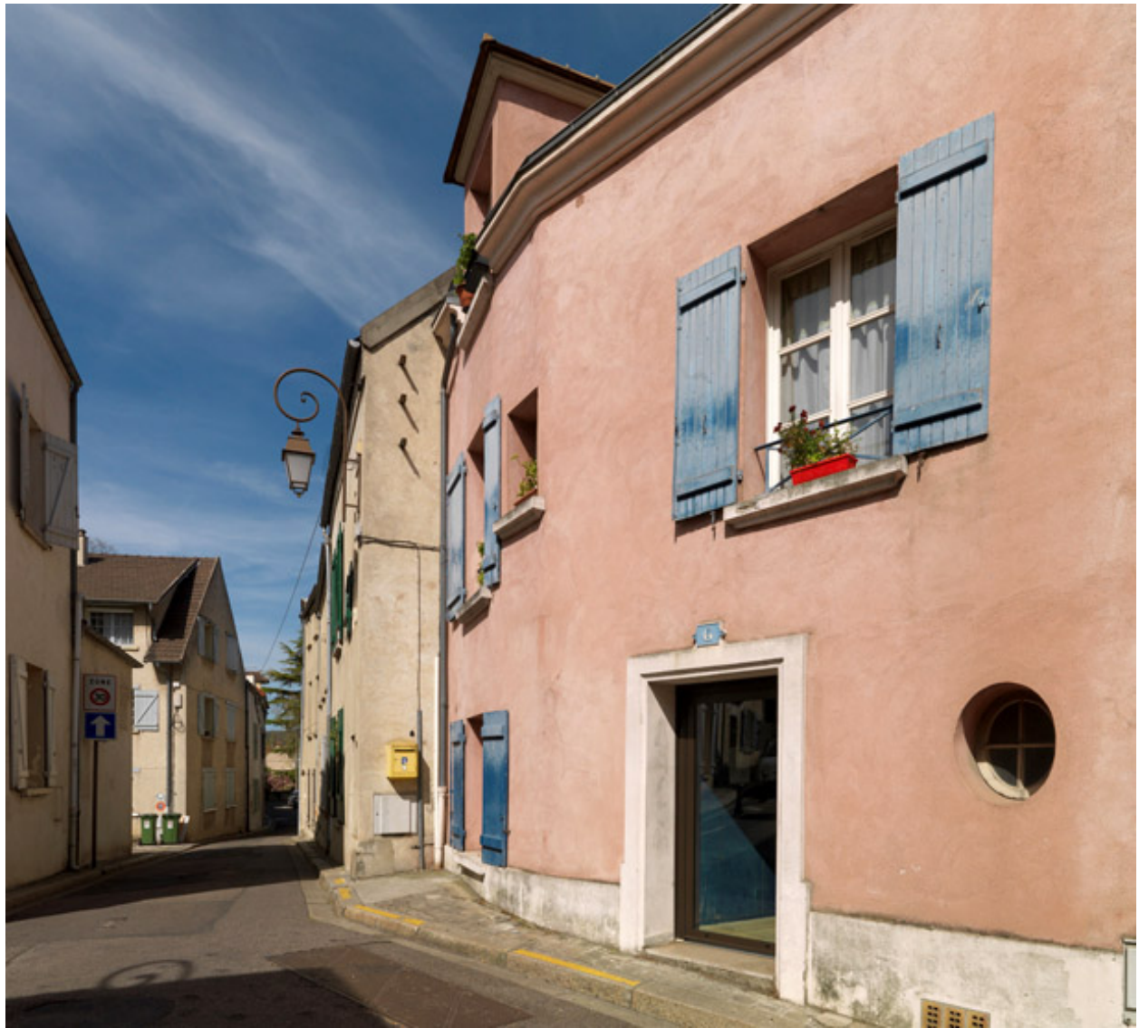
Maisons très transformées rue des Tanneries.
