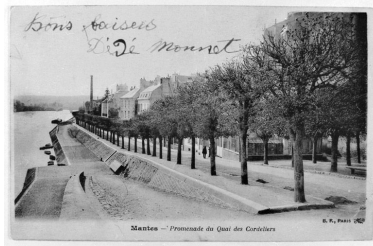
Vue du quai des Cordeliers. Carte postale. Phot. CREDOP, Phot. Laurent Kruszyk IVR11_20157800047X
