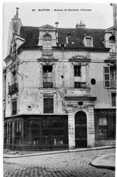
La maison dite de Gabrielle d'estrées (détruite). Carte postale. Phot. CREDOP, Phot. Laurent Kruszyk IVR11_20157800070X
