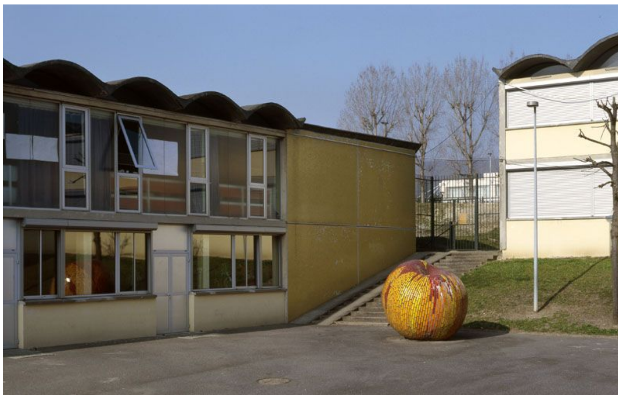
Vue rapprochée de la cour de récréation où est installée la Pomme.
