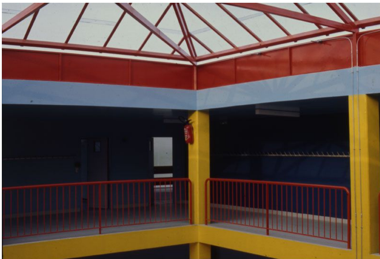
Vue intérieure d'une circulation autour du patio et de la verrière le couvrant. Photographie, circa 1976. (Cité de l'architecture et du patrimoine, Archives d'architecture du XXe siècle).
