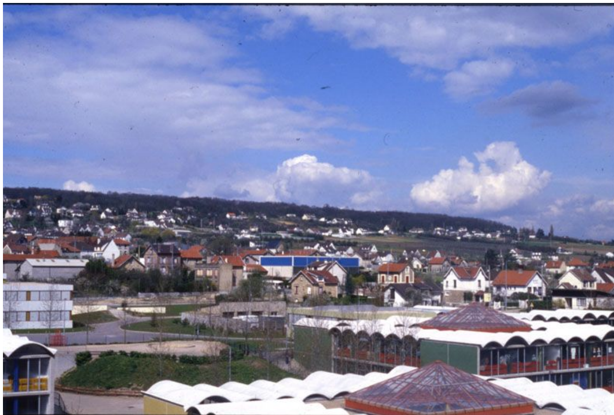
Au premier plan, les toits des écoles avec en détail les verrières des patios, au second plan, le village de Chanteloup. Photographie, circa 1976. (Cité de l'architecture et du patrimoine, Archives d'architecture du XXe siècle).
