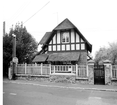
Vue d'ensemble depuis la rue de l'ancienne maison de gardien de la villa située au 106 ; elle forme aujourd'hui une autre propriété. Phot. Philippe Ayrault IVR11_20029101421X
