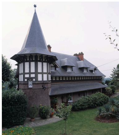
Vue d'ensemble. Phot. Philippe Ayrault IVR11_20029101403XA
