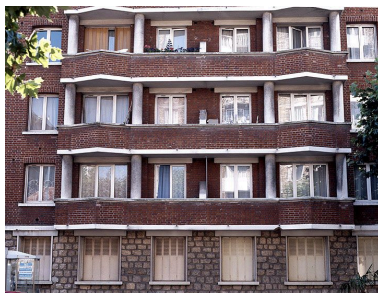
Détail de l'élévation sur la rue Théodore-Honoré. Phot. Stéphane Asseline IVR11_20049400391XA
