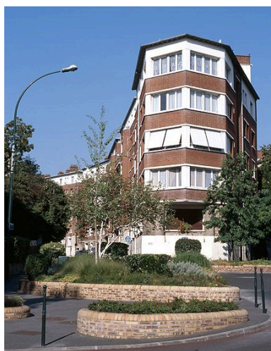
Elévation à l'angle de la rue Anquetil et de la rue Théodore-Honoré. Phot. Stéphane Asseline IVR11_20049400393XA
