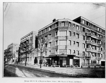
Vue générale à l'angle du boulevard de Strasbourg et de la rue des Epivants. Tiré de : La construction moderne, 49e année, 1933-1934, vol.1. ( IVR11_19849401140XB
