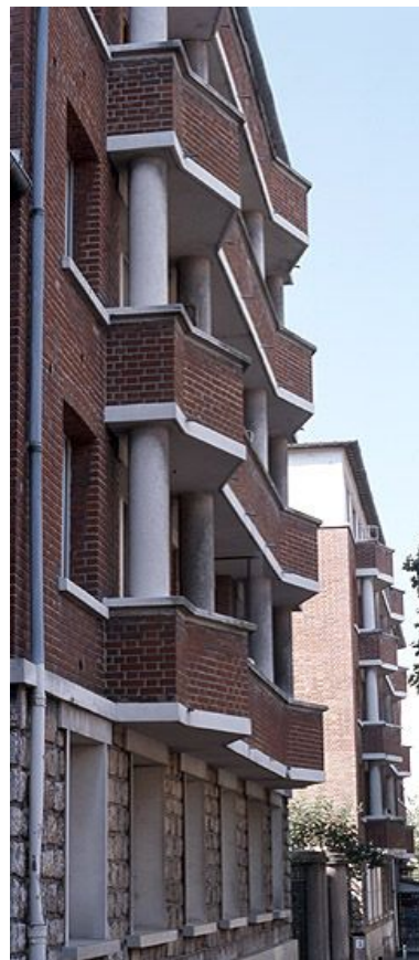
Détail de l'élévation sur la rue Théodore-Honoré. Phot. Stéphane Asseline IVR11_20049400392XA
