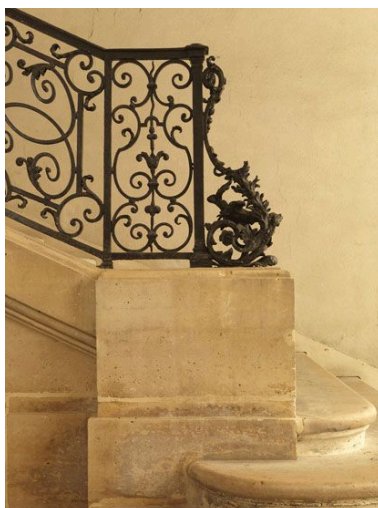
Vue de la console de départ. Phot. Laurent Kruszyk IVR11_20097501444NUC4A
