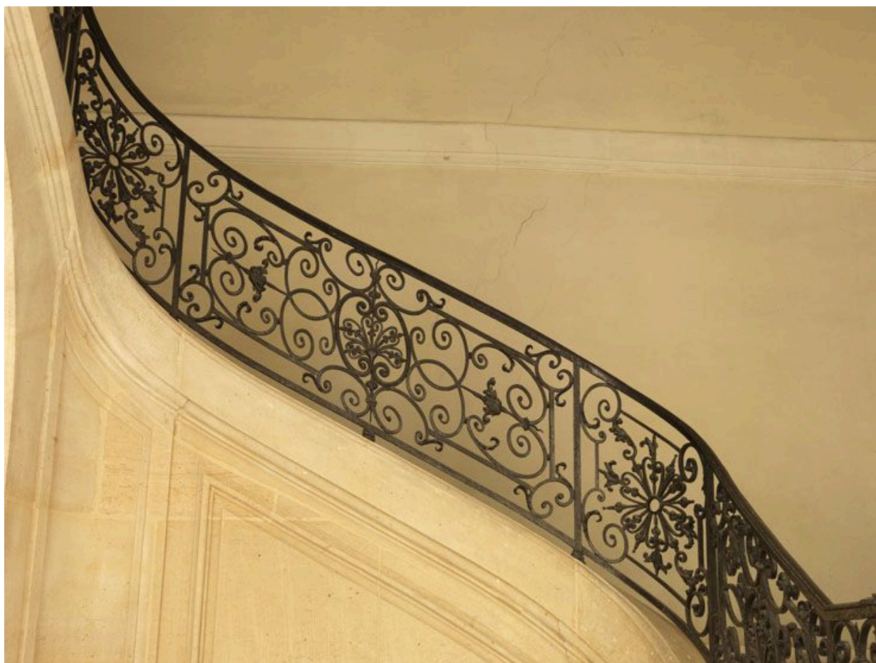
Vue d'un panneau rampant.
