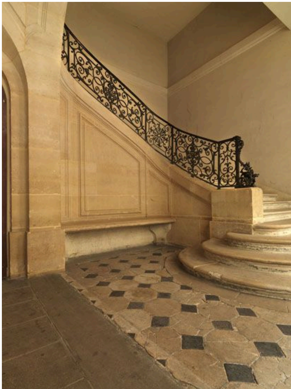
Vue du départ de l'escalier.
