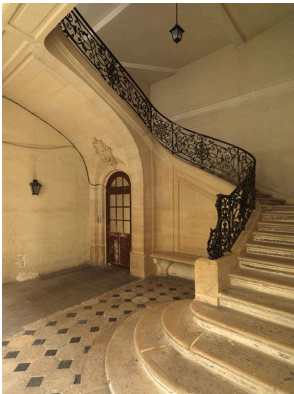
Vue d'ensemble de l'escalier.
