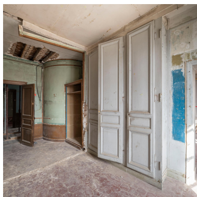
Premier étage, une chambre. Sur la gauche on aperçoit le palier. Phot. Philippe Ayrault IVR11_20239300558NUC4A
