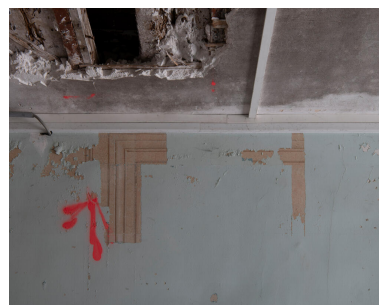
Premier étage. Sondage ayant mis au jour un encadrement de porte en trompe-l'oeil (non daté). Phot. Philippe Ayrault IVR11_20239300561NUC4A
