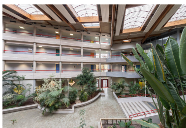
L'atrium. La charpente en bois lamellé-collé qui le recouvre supporte des lanterneaux géométriques qui diffusent une douce lumière naturelle. Phot. Laurent Kruszyk IVR11_20199300470NUC4A
