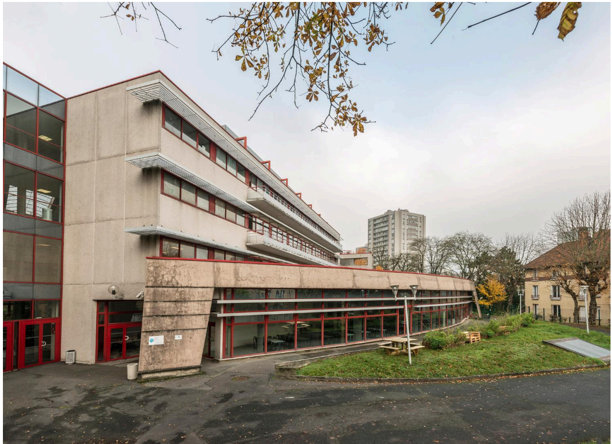
Vue générale sur le réfectoire.
