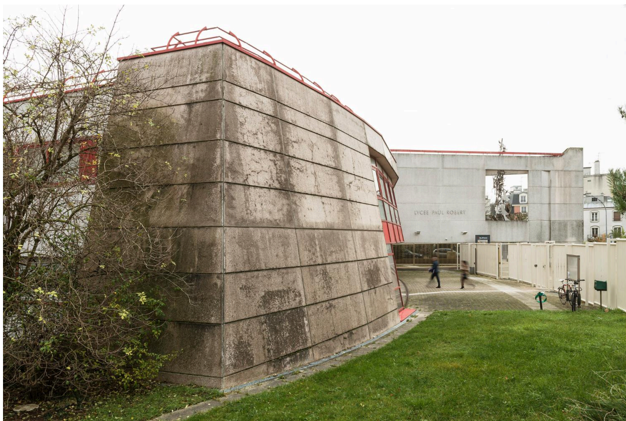
Vue sur l'entrée du lycée, avec la façade traitée en pointe.
