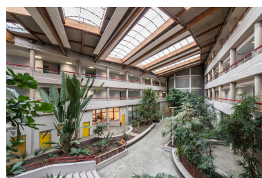
L'atrium. La lumière naturelle, abondante à l'intérieur, comme pour pallier le peu d'espaces extérieurs, est diffusée par de multiples sources et dispositifs : pavés de verre, lanterneaux, cours anglaises. Phot. Laurent Kruszyk IVR11_20199300482NUC4A
