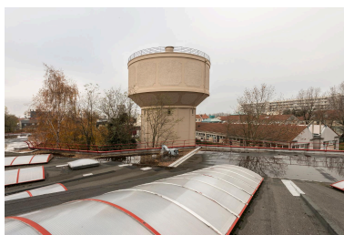
Depuis le toit de l'établissement, vue sur les lanterneaux qui éclairent l'atrium. Au fond, le château d'eau mitoyen du lycée. Phot. Laurent Kruszyk IVR11_20199300499NUC4A
