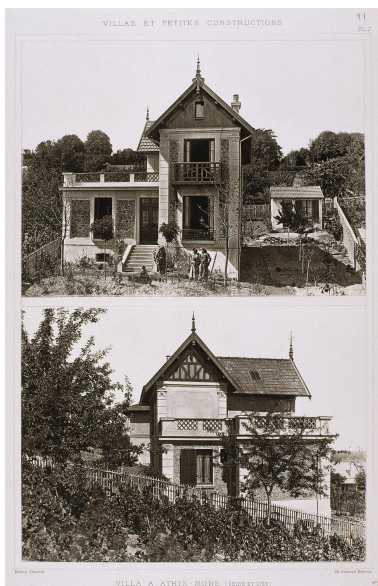
Villa construite par l'architecte L.-P. Marquet : 2 vues d'ensemble. IVR11_20039101236XA
