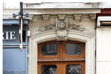
Vue du motif sculpté au dessus de la porte. Phot. Laurent Kruszyk IVR11_20157500623NUC4A
