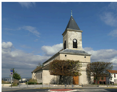
Vue de la façade principale. Phot. Jean-Bernard Vialles IVR11_20119300284NUC4A
