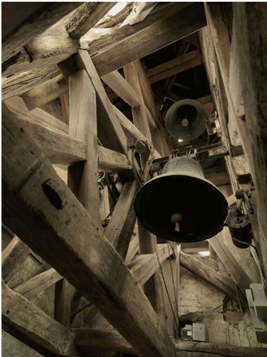
Vue intérieure du clocher de l'église.
