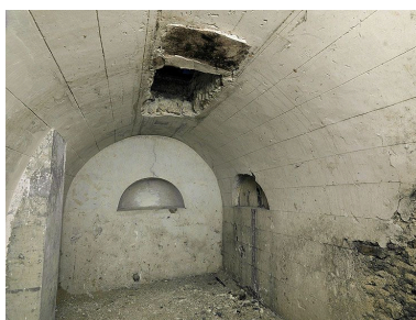
Vue intérieure de la crypte située sous la chapelle orientale de l'église. Phot. Jean-Bernard Vialles IVR11_20109300013NUC4A
