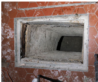
Entrée de la crypte de la nef. Phot. Jean-Bernard Vialles IVR11_20109300016NUC4A
