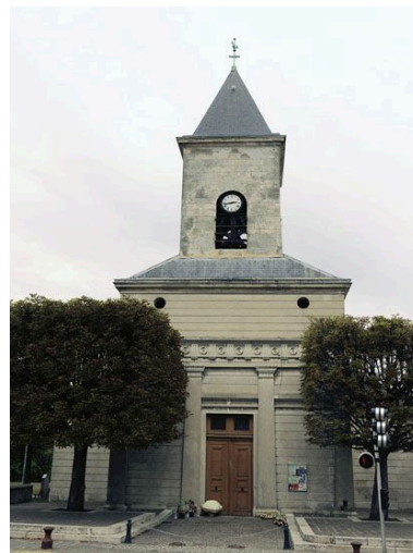
Vue rapprochée de la façade principale. Phot. Jean-Bernard Vialles IVR11_20089300249NUC4A
