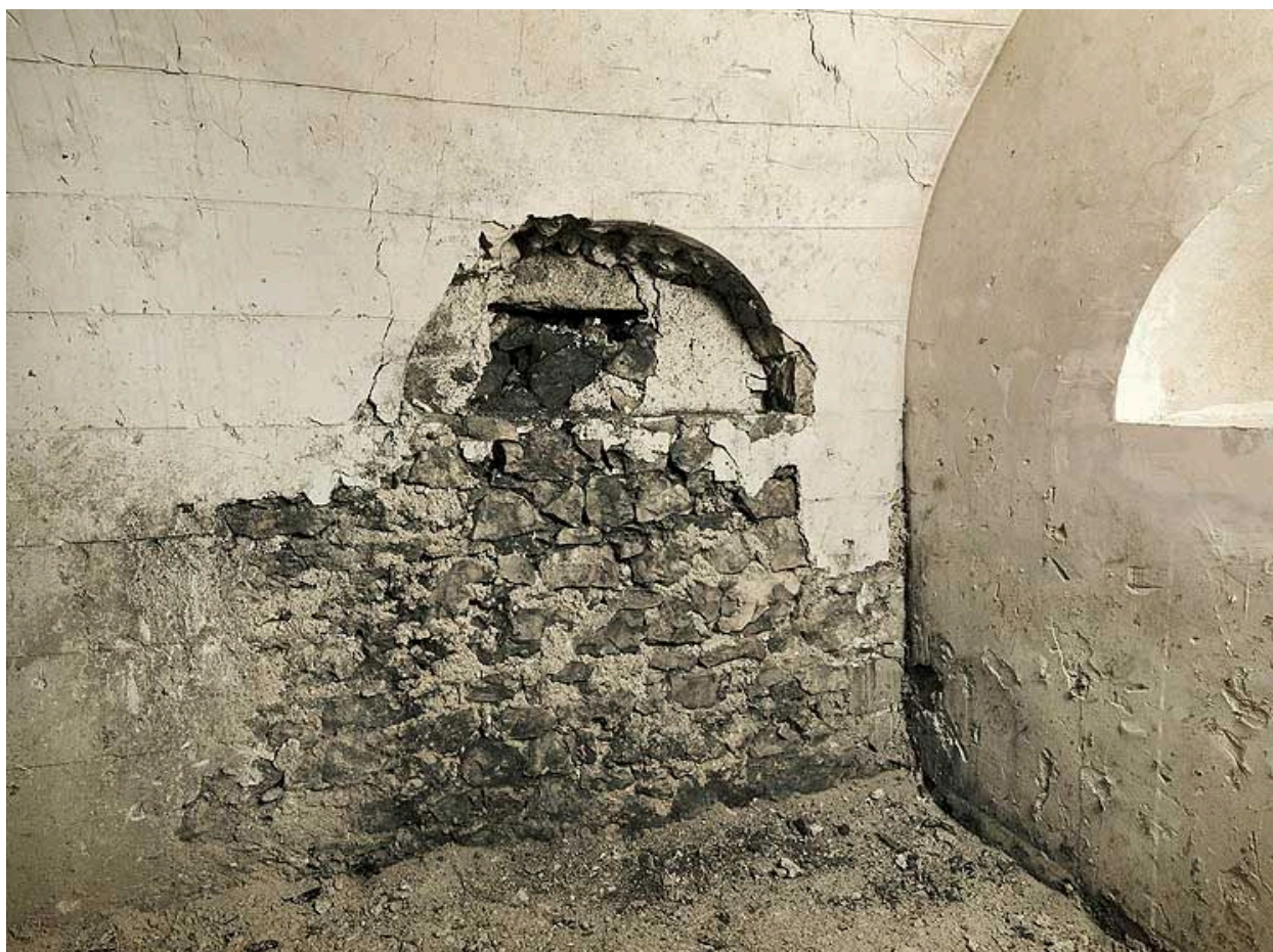
Appareillage du mur de la crypte.
