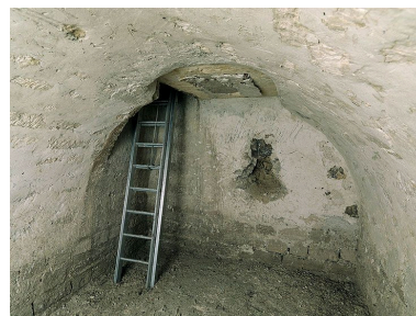
Vue de l'entrée de la crypte donnant dans la nef. Phot. Jean-Bernard Vialles IVR11_20109300018NUC4A
