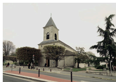
Vue générale. Phot. Jean-Bernard Vialles IVR11_20089300251NUC4A
