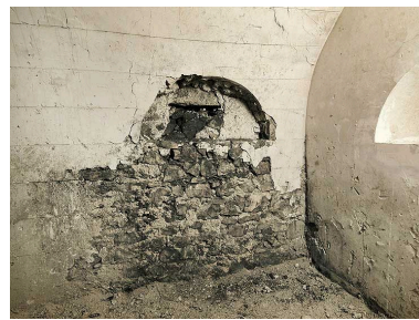
Appareillage du mur de la crypte. Phot. Jean-Bernard Vialles IVR11_20109300015NUC4A
