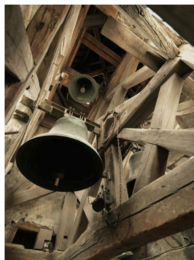
Vue intérieure du clocher. Phot. Jean-Bernard Vialles IVR11_20089300247NUC4A
