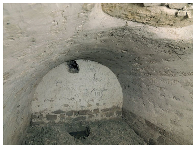
Vue d'ensemble de la crypte. Phot. Jean-Bernard Vialles IVR11_20109300017NUC4A
