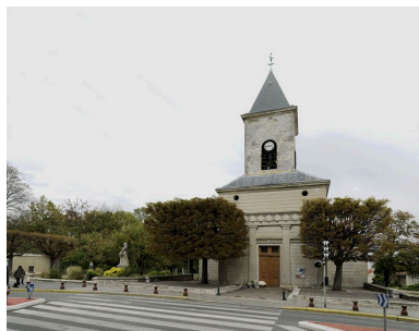
Vue de la façade principale. Phot. Jean-Bernard Vialles IVR11_20089300250NUC4A
