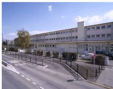
Façade sur la rue Frédéric Joliot-Curie. Phot. Philippe Ayrault IVR11_20079101305XA
