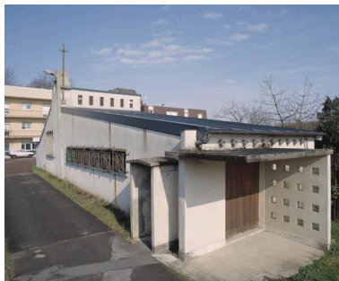
Vue d'ensemble. Phot. Philippe Ayrault IVR11_20029100376XA
