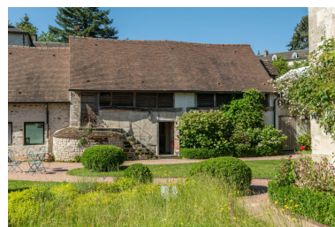
Partie ouest du bâtiment en L abritant le Musée de l'outil, depuis le nord. Phot. Kruszyk Laurent IVR11_20249500095NUC4A
