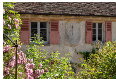
Détail de la façade sud de l'ancien presbytère. Phot. Kruszyk Laurent IVR11_20249500092NUC4A
