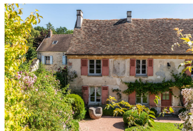
Vue de la façade sud de l'ancien presbytère. Phot. Kruszyk Laurent IVR11_20249500091NUC4A
