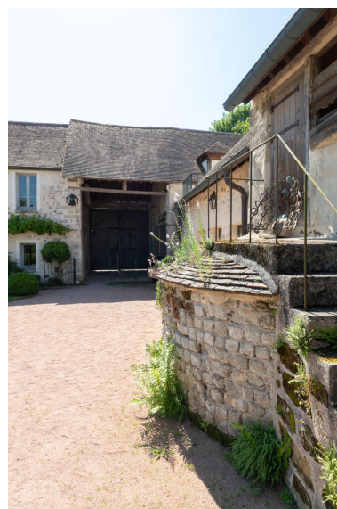
Vue de la porte charretière depuis l'extrémité ouest de la cour. Phot. Kruszyk Laurent IVR11_20249500097NUC4A
