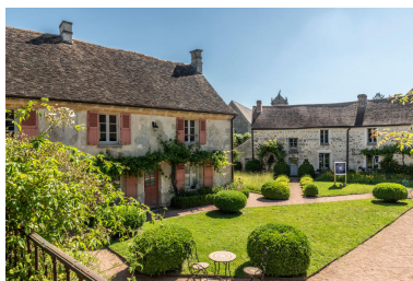
Vue générale depuis le sud-ouest. Phot. Kruszyk Laurent IVR11_20249500094NUC4A
