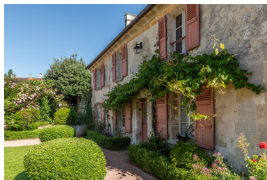
Vue de la façade sud de l'ancien presbytère, depuis le sud-est. Phot. Kruszyk Laurent IVR11_20249500090NUC4A
