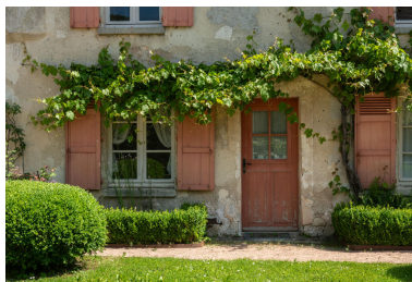
Détail de la façade sud de l'ancien presbytère. Phot. Kruszyk Laurent IVR11_20249500093NUC4A
