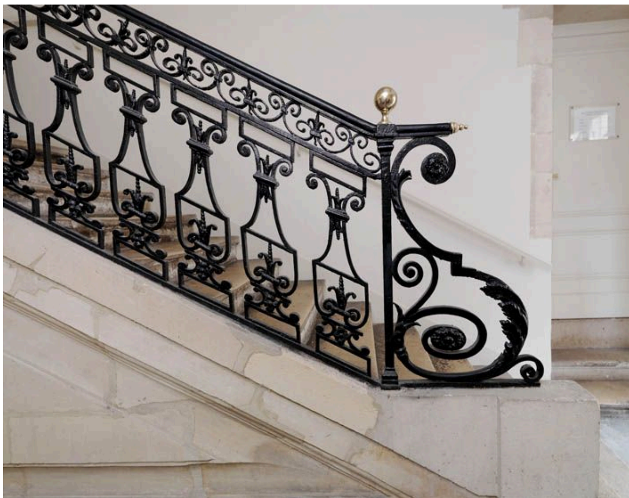
La console de départ et les balustres de la première volée.
