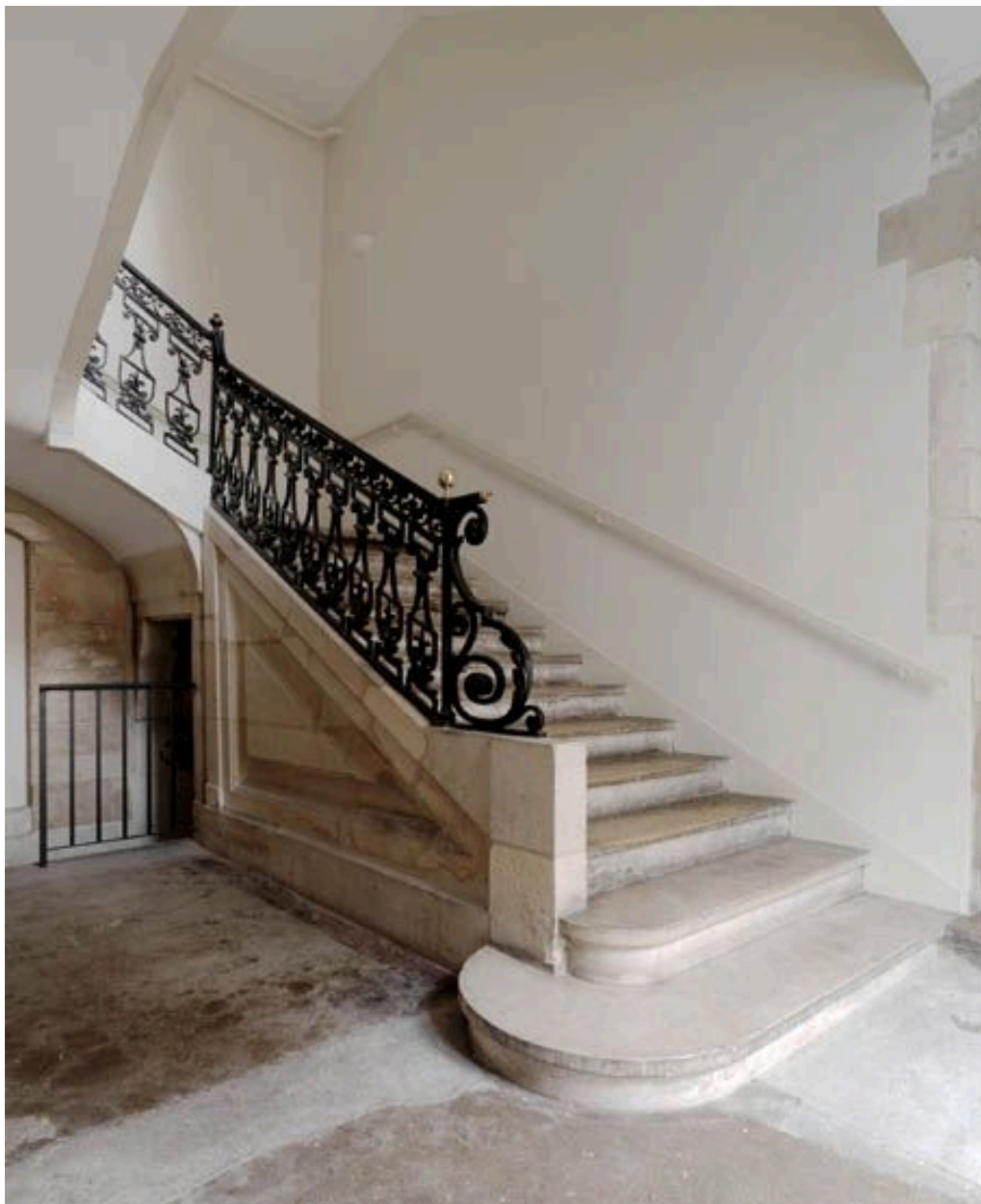
Vue d'ensemble du départ de l'escalier.
