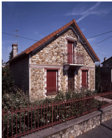
Vue d'ensemble. Phot. Philippe Ayrault IVR11_20049100516XA
