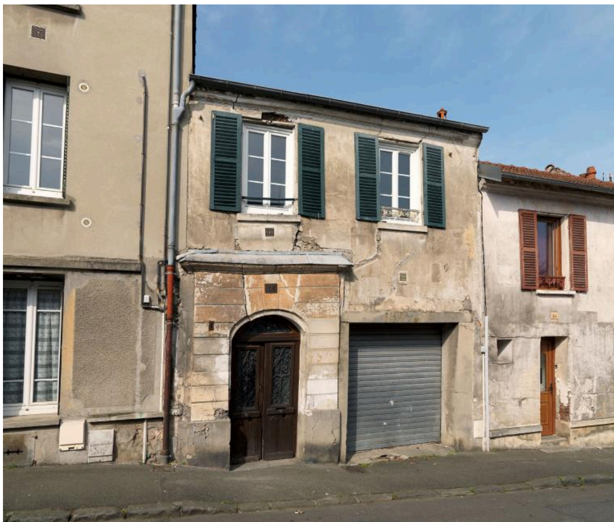
Maison 16, rue Auguste-Schenck : la façade est remaniée mais conserve une élégante entrée avec arc en anse de panier.
