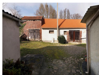
Dépendances (grange, écurie) situées en arrière de la cour commune, 27 rue du Maréchal-Leclerc. Phot. Jean-Bernard Vialles IVR11_20179500005NUC4A
