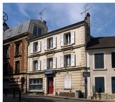
Maison de bourg, 35 rue Paul-Lorillon, avec son enduit en plâtre imitant la pierre de taille. Phot. Jean-Bernard Vialles IVR11_20169500116NUC4A
