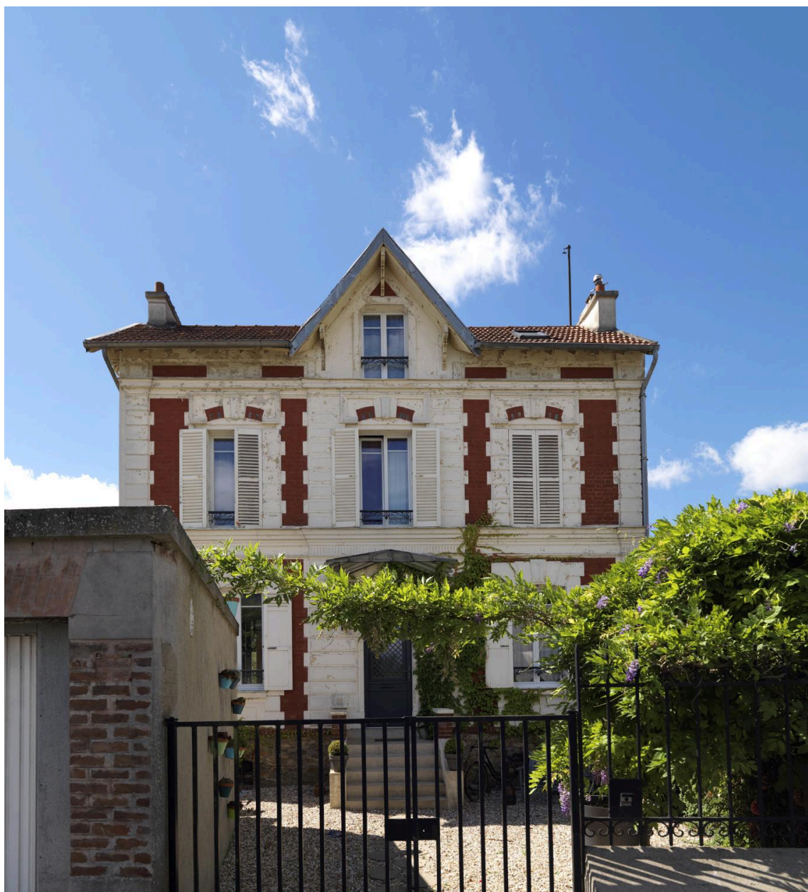
Maison 5, avenue de la République : vue de face.
