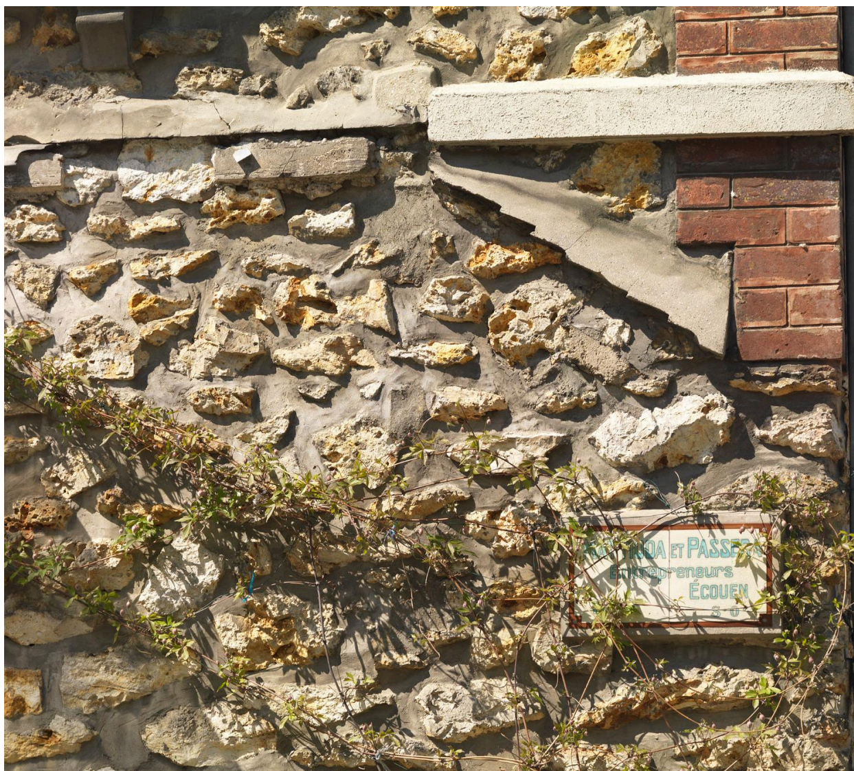
Pavillon 10 rue Christine, construit en 1908 : détail de la plaque en céramique des entrepreneurs.
