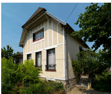
Pavillon construit par l'entreprise Netter dans les années 1930, 9 rue Victor-Hugo (lotissement de Bois-Bleu).
