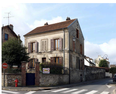
Maison 19 rue Colette-Rousset (à l'angle de la rue de la République), avec son décor sur l'enduit au plâtre, présentant notamment des fenêtres feintes sur les deux façades. Phot. Jean-Bernard Vialles IVR11_20179500024NUC4A
