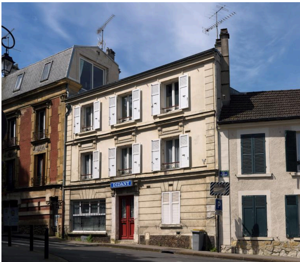
Maison de bourg, 35 rue Paul-Lorillon, avec son enduit en plâtre imitant la pierre de taille.
