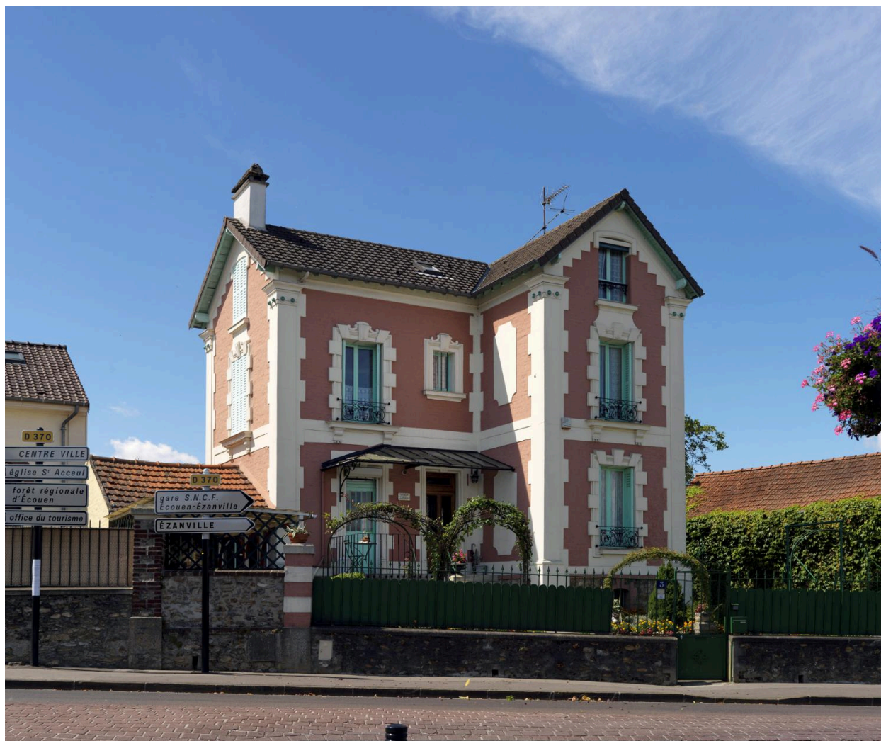
Maison 3, rue de la Libération.
