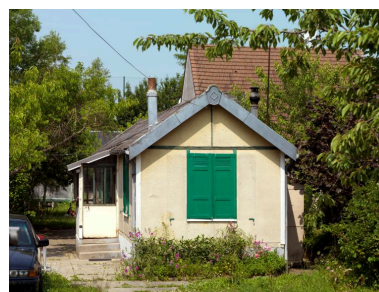
"Cabanon" de l'entre-deux-guerres, 85 avenue du Maréchal-Foch.
