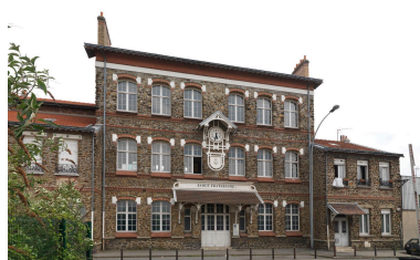
Vue de la façade rue de la Fraternité. Phot. Laurent Kruszyk IVR11_20109300046NUC4A
