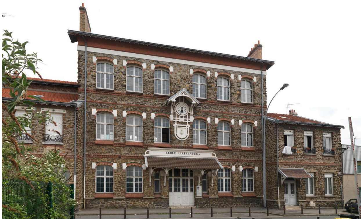
Vue de la façade rue de la Fraternité.
