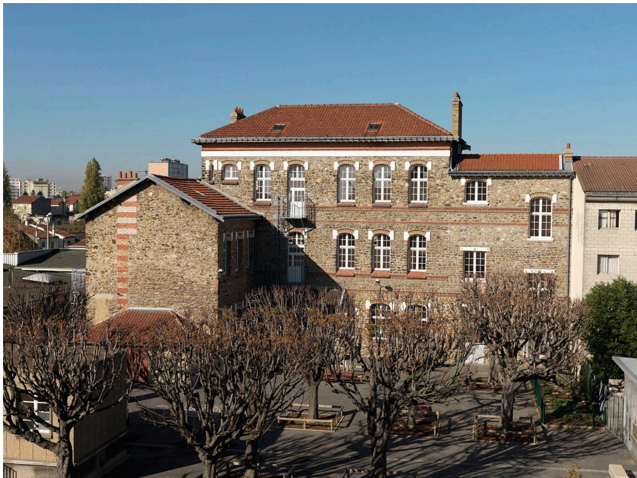
Vue de la façade sur la cour de récréation.
