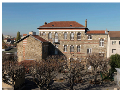
Vue de la façade sur la cour de récréation. Phot. Jean-Bernard Vialles IVR11_20089300350NUC4A
