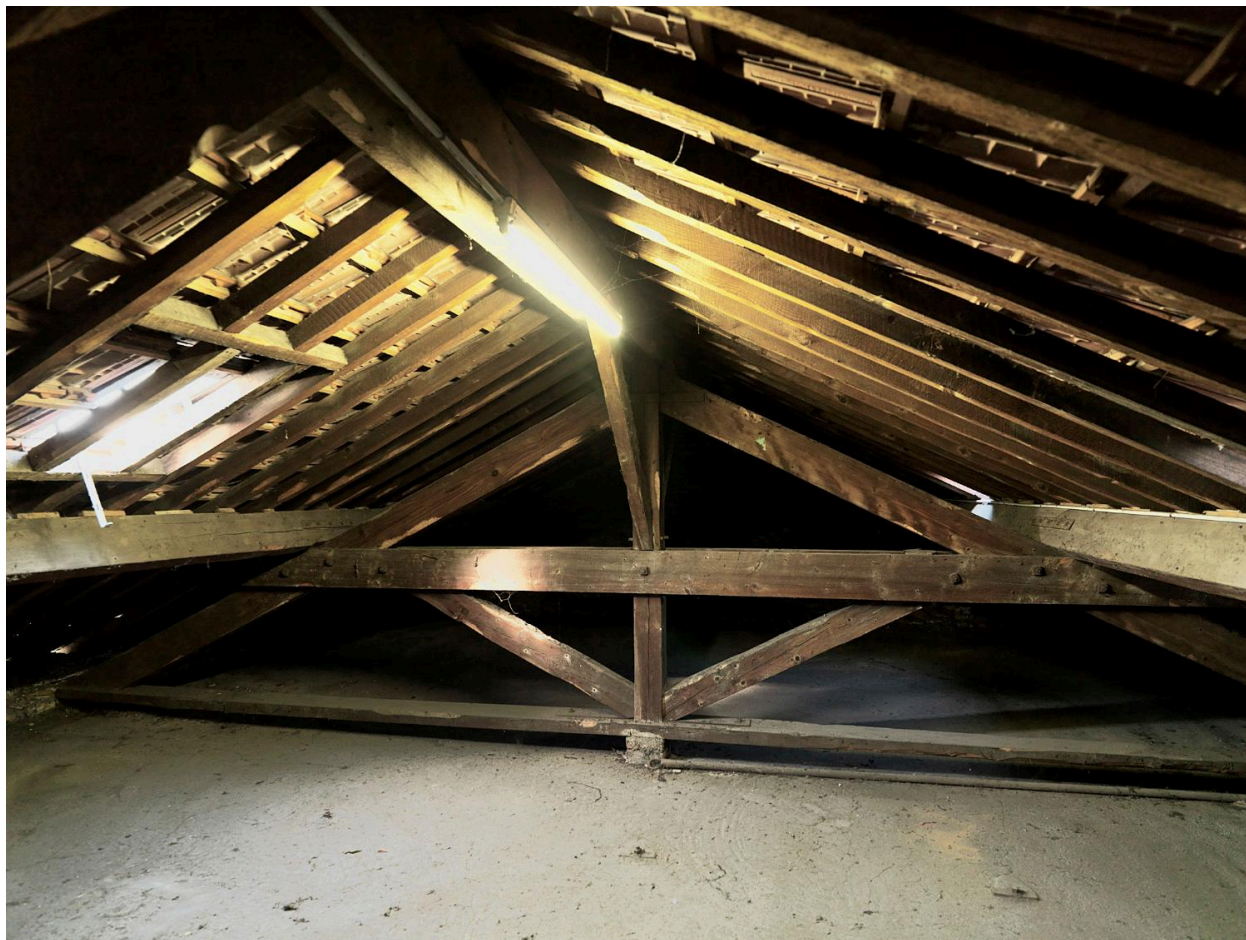
Vue de la charpenste des pavillons d'angle
