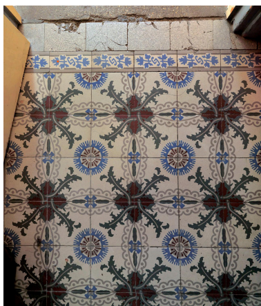
Vue des carreaux de ciment, détail de pavement. Phot. Jean-Bernard Vialles IVR11_20089300356NUC4A
