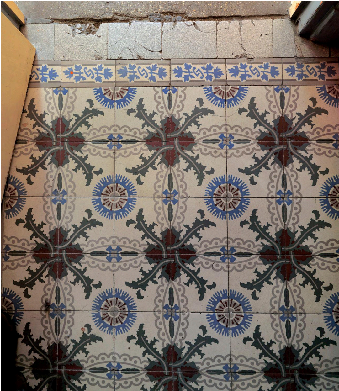
Vue des carreaux de ciment, détail de pavement.
