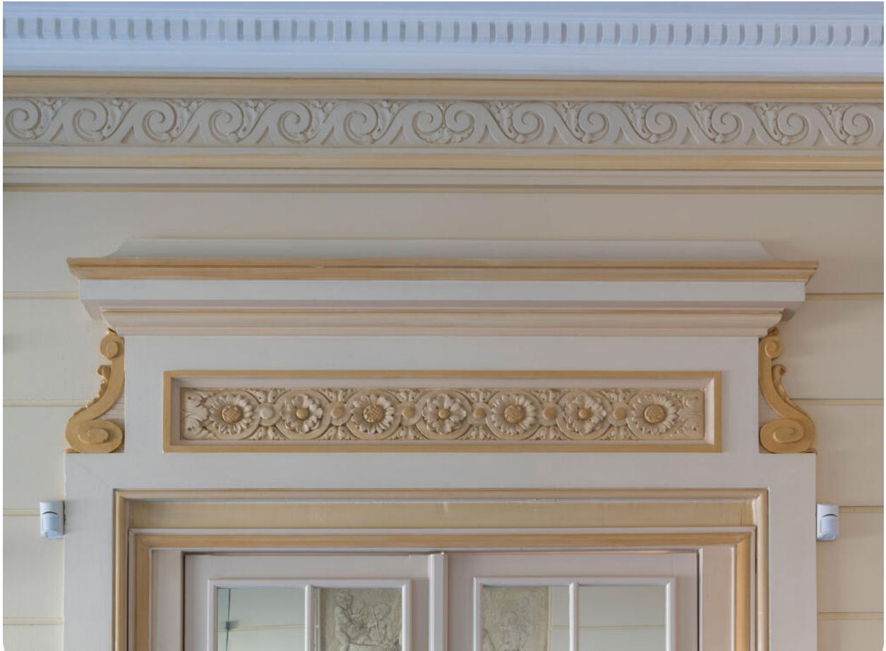
Dans le vestibule, détail d'un dessus-de-porte.
