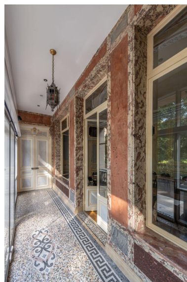
La galerie constituée de marbres polychromes et sol en mosaïque. IVR11_20239500642NUC4A
