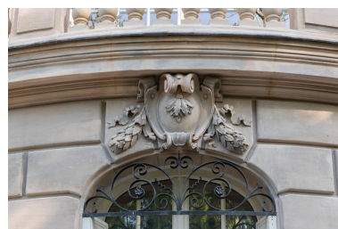
Détail du décor sculpté en agrafe de la porte-fenêtre centrale de la rotonde. Aux feuilles de chêne du comble répondent ici des guirlandes de laurier. On voit par ailleurs les bossages de la rotonde. IVR11_20239500620NUC4A
