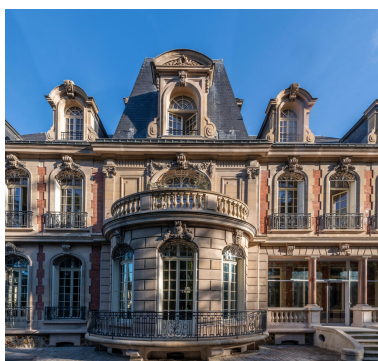
Vue rapprochée de la façade sud. De ce côté, elle semble posée sur le soubassement comme sur un socle. L'effet est accentué par le larmier en boudin. L'ornementation sculptée est ici très abondante et contraste avec la relative sobriété du côté rue. IVR11_20239500618NUC4A
