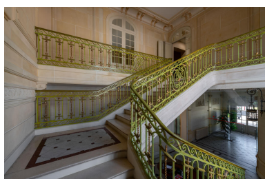
Jeux de rampes de l'escalier. IVR11_20239500630NUC4A
