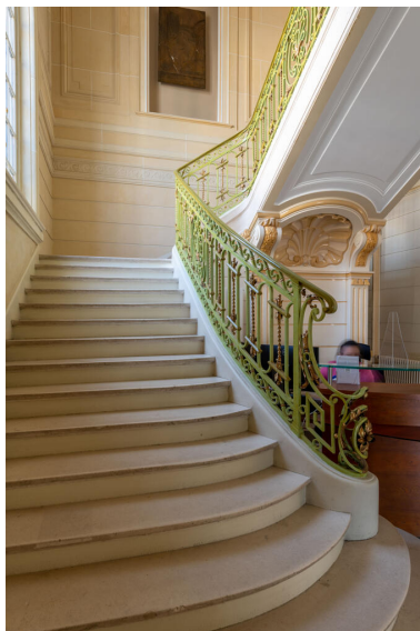
Départ de l'escalier. La rampe en serrurerie est amortie par une console dans le goût à la grecque. Elle comporte un motif continu d'arcades reliées par des étriers. Elle est encadrée de deux frises de postes, haute et basse. IVR11_20239500626NUC4A
