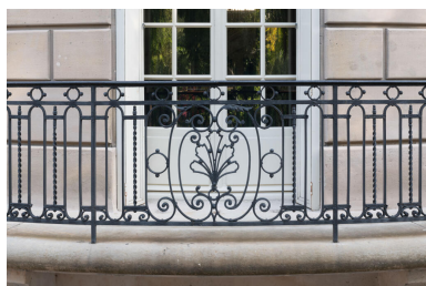
En façade sud, détail du garde-corps en fer forgé qui entoure la rotonde. IVR11_20239500619NUC4A
