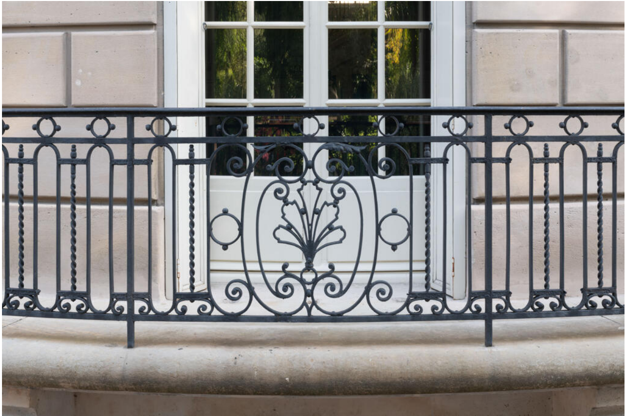
En façade sud, détail du garde-corps en fer forgé qui entoure la rotonde.
