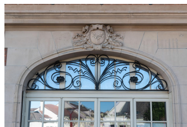
Façade ouest, détail de l'une des deux portes-fenêtres. En agrafe, un rameau de lierre orne le médaillon, encadré de laurier. On voit ici que l'appareil en pierre est feint. IVR11_20239500615NUC4A
