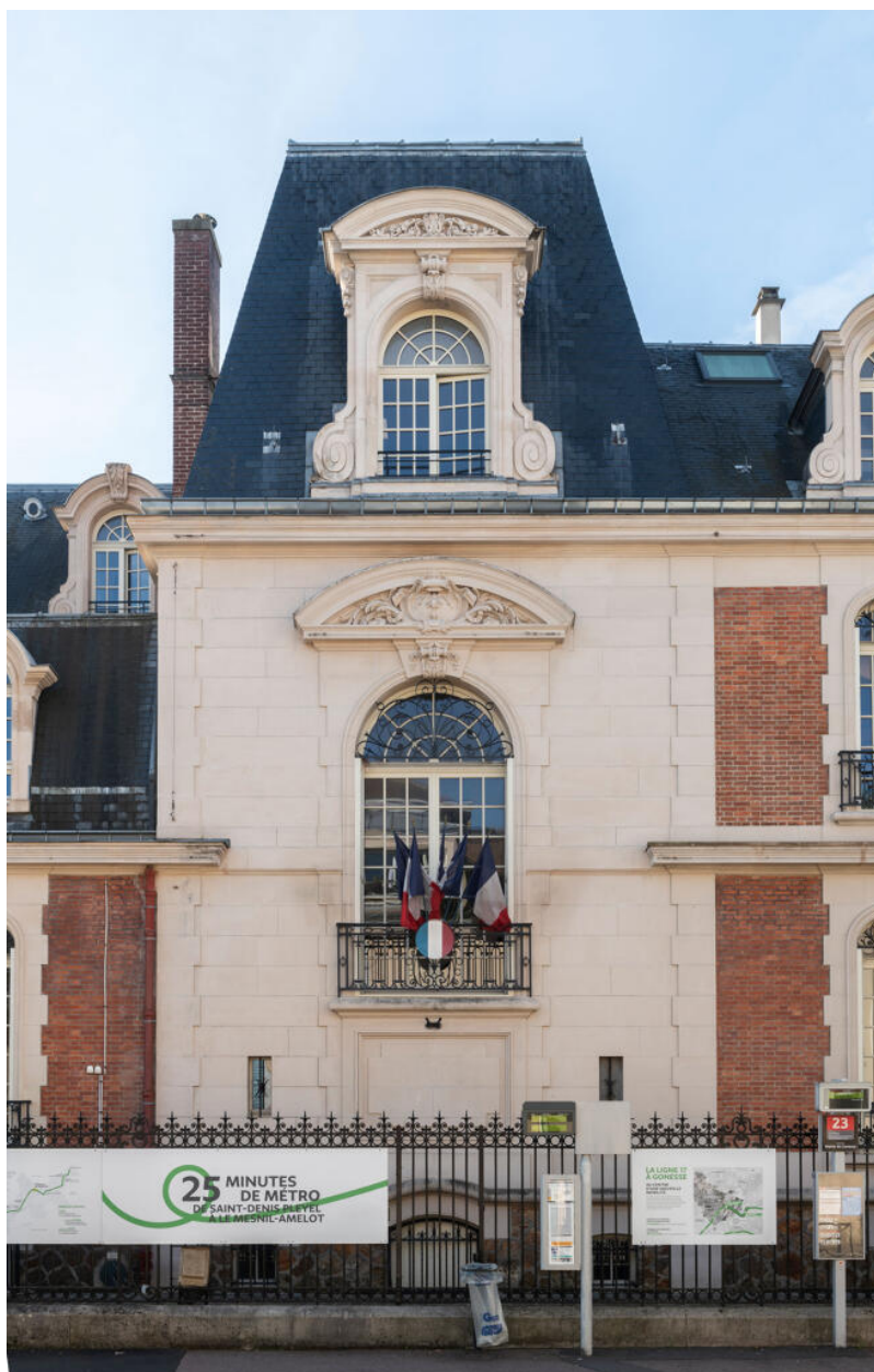
Façade nord, détail du corps central dont l'appareil en pierre de taille est feint. Cette grande baie correspond à l'emplacement de l'escalier d'honneur.
