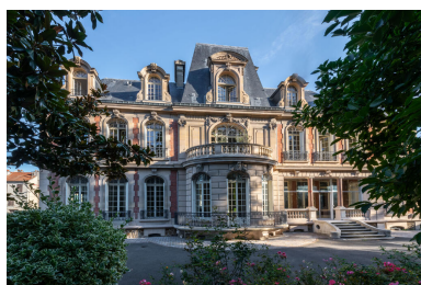
Vue générale de la façade sud. IVR11_20239500617NUC4A
