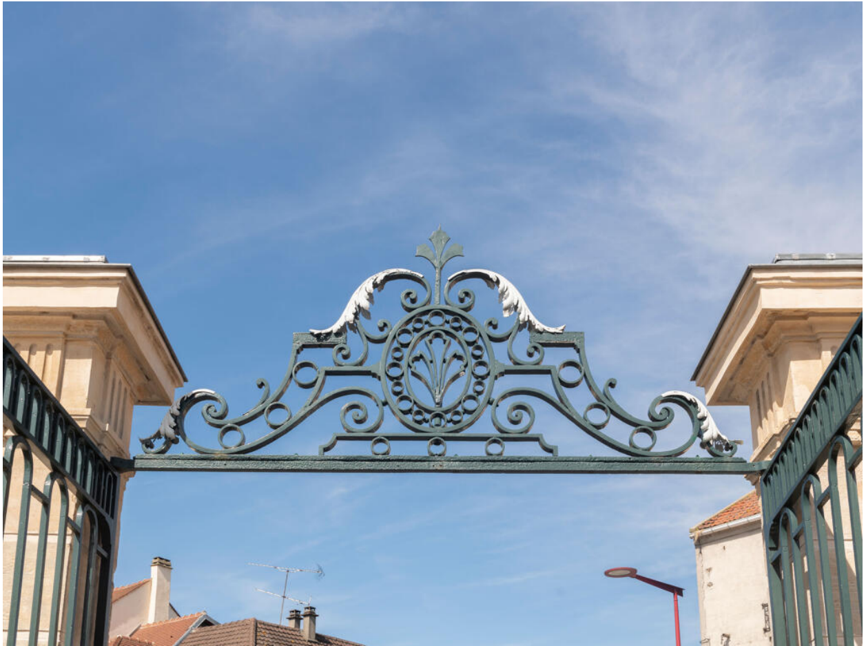
Détail du portail en fer forgé. Le fleuron central rappelle ceux de l'escalier, en plus simple.
