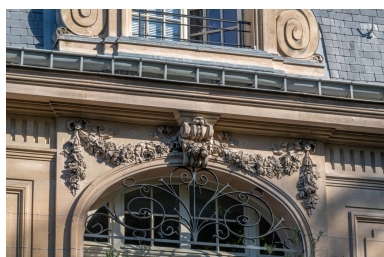
En façade sud, détail du décor sculpté de la baie centrale du premier étage. IVR11_20239500621NUC4A
