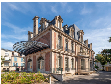
L'angle sud-ouest. Comme aujourd'hui, l'entrée principale se trouvait de ce côté. Une marquise a été ajoutée dans les années 2000 à l'emplacement de la structure en fer et verre dont on lit encore très bien l'emprise. IVR11_20239500614NUC4A
