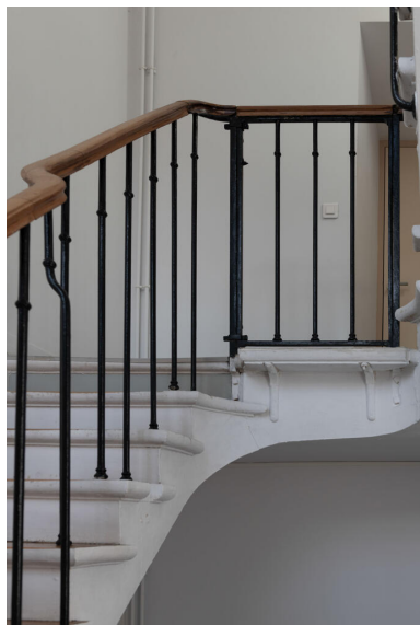
L'escalier de service ajouté en 1903 dans l'extension est. Il comporte des portillons à chaque palier et des décrochements dans sa rampe : sans doute un monte-charge ou un ascenseur étaient-ils prévus. IVR11_20239500644NUC4A
