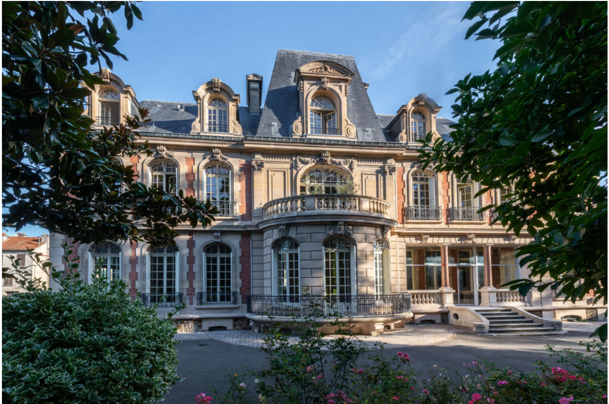
Vue générale de la façade sud.
