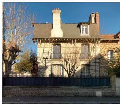
Façade latérale de la maison. On voit que sa façade arrière est mitoyenne. Phot. Laurent Kruszyk IVR11_20167800760NUC4A
