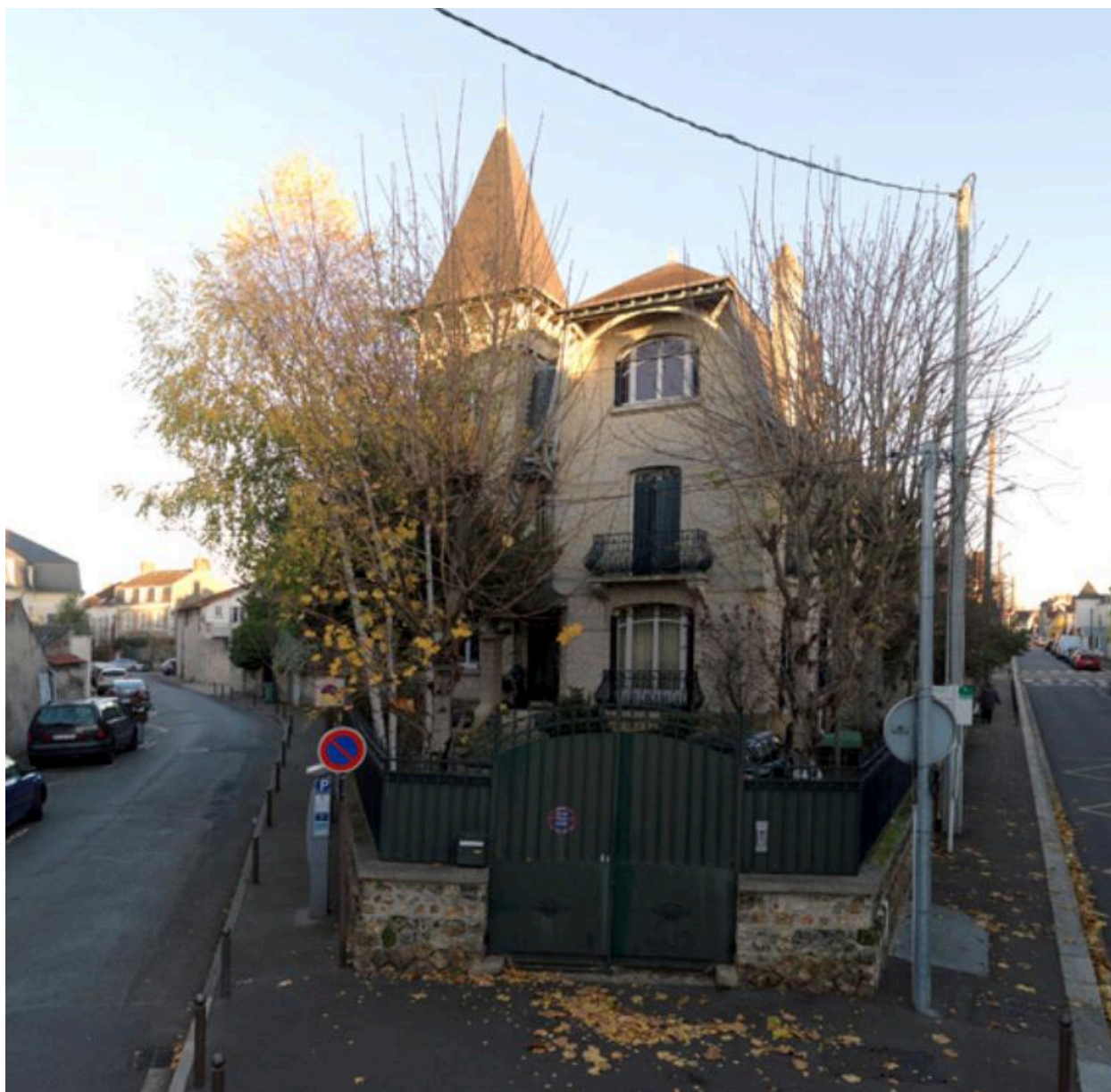
Façade principale, angle rue des Martraits et rue Alphonse Durand.
