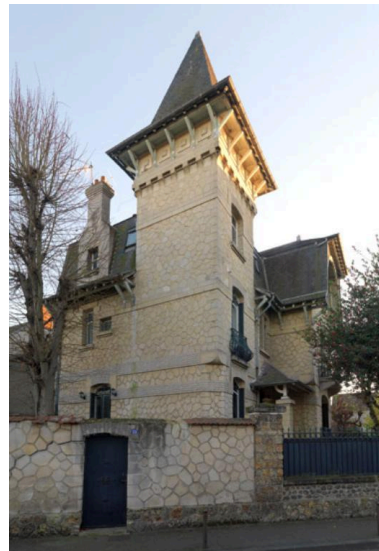
Façade rue des Martraits. Phot. Laurent Kruszyk IVR11_20167800793NUC4A
