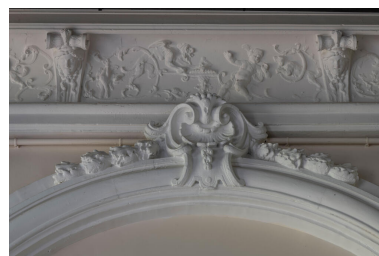
Décor de la corniche de la galerie : putti jouant avec des chiens Phot. Kruszyk Laurent IVR11_20249200079NUC4A
