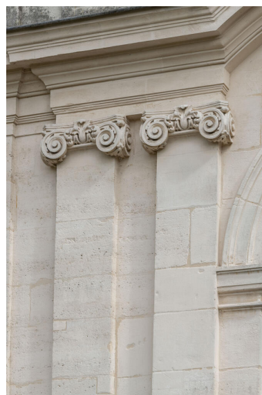
Pilastres ioniques encadrant une baie de la galerie Phot. Kruszyk Laurent IVR11_20249200052NUC4A
