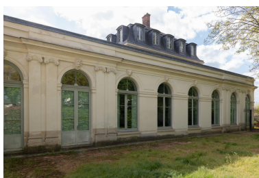
Vue extérieure de la galerie Phot. Kruszyk Laurent IVR11_20249200054NUC4A
