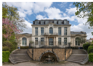
La façade sur jardin qui domine une fausse grotte en rocaille abritant un bassin Phot. Kruszyk Laurent IVR11_20249200049NUC4A
