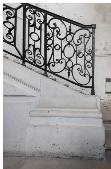
Panneau carré et pilastre en serrurerie du départ de l'escalier Phot. Kruszyk Laurent IVR11_20249200062NUC4A
