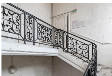
Vue d'ensemble de l'escalier d'honneur avec sa rampe de serrurerie d'une grande qualité Phot. Kruszyk Laurent IVR11_20249200060NUC4A
