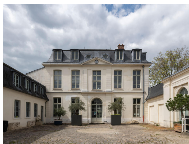
La façade sur cour Phot. Kruszyk Laurent IVR11_20249200047NUC4A
