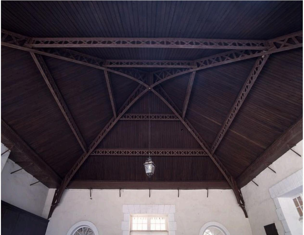
Ancien salon de jardin : détail de la charpente à ferme métallique couverte en dôme surbaissé. Le verre a été remplacé par un palissage de bois.
