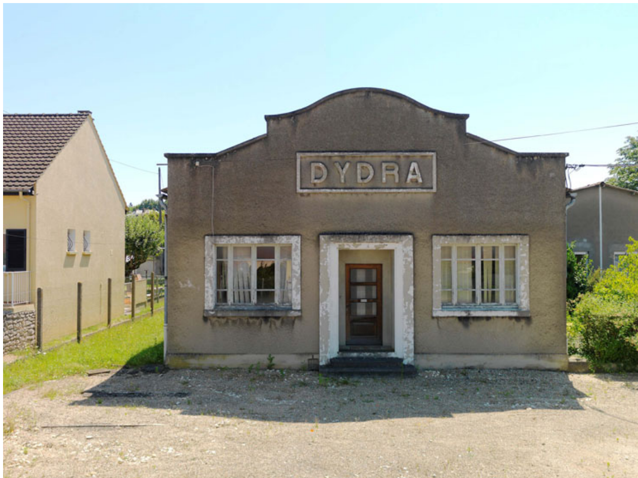
Vue extérieure avec enseigne "Dydra".
