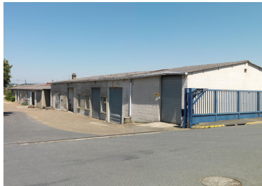
Vue extérieure de l'arrière des bâtiments. Phot. Philippe Ayrault IVR11_20127700611NUC4A
