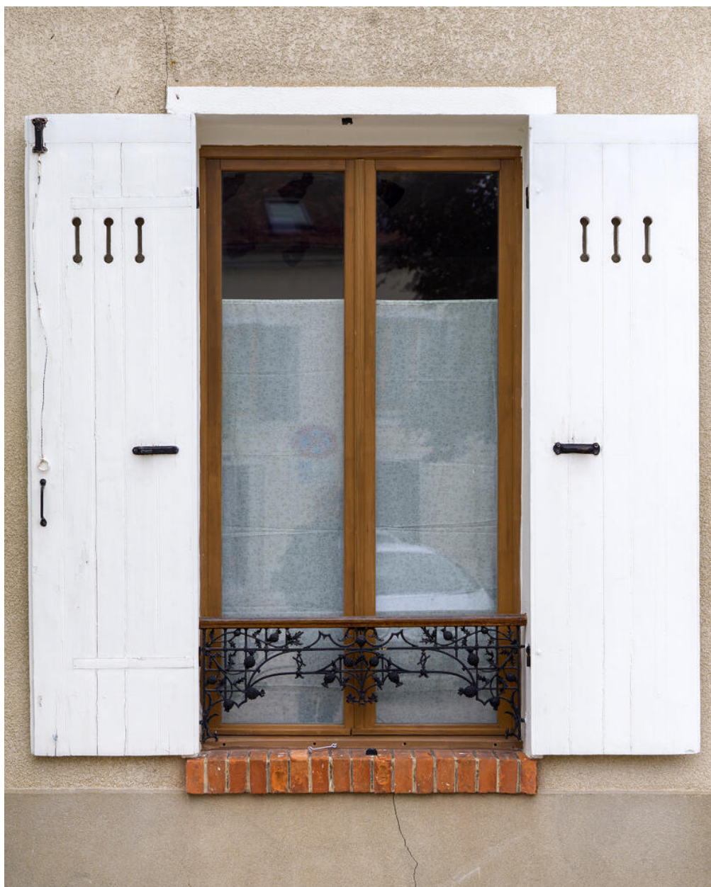
Baie du rez-de-chaussée.
