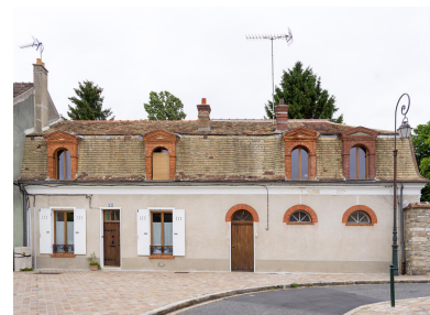
Vue générale depuis l'ouest. Phot. Asseline Stéphane IVR11_20259100252NUC4A
