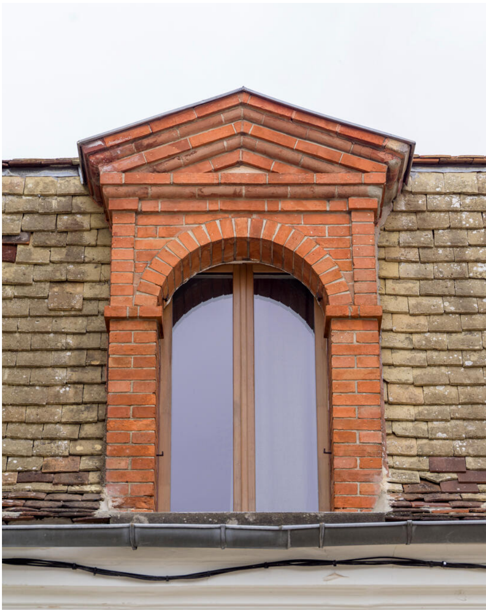
Vue de détail d'une des lucarnes.
