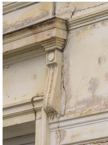
Vue de détail d'un entablement d'une baie de la partie sud de la façade. Phot. Asseline Stéphane IVR11_20259100564NUC4A
