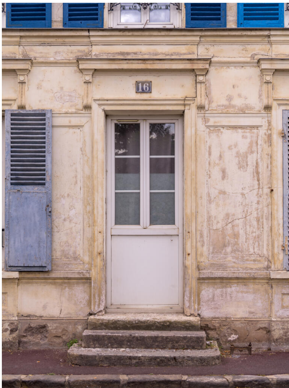
Porte d'entrée de la partie sud.
