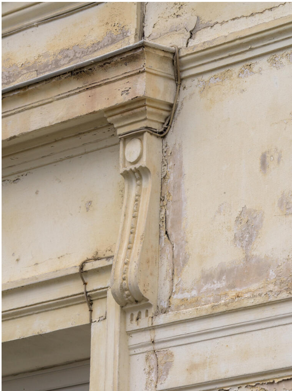
Vue de détail d'un entablement d'une baie de la partie sud de la façade.
