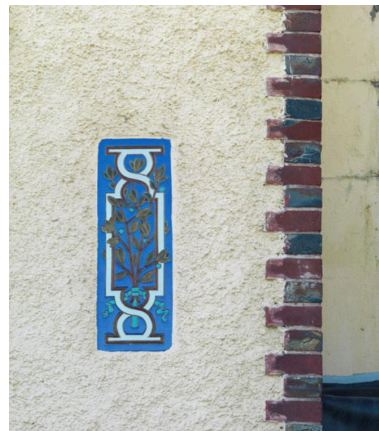
Décor de façade : Cartouche décoratif à feuillages et chaînage de briques vernissées. Phot. Laurent Kruszyk IVR11_20167800749NUC4A
