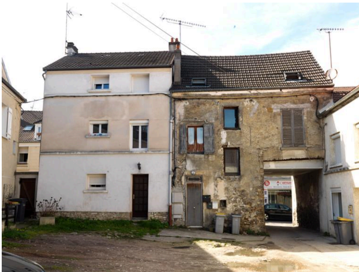
Façade postérieure, vue depuis la cour commune.
