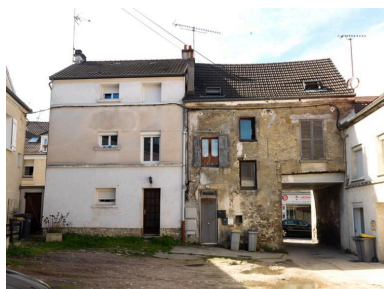
Façade postérieure, vue depuis la cour commune.
