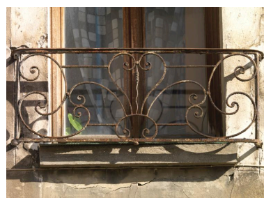
Détail du garde-corps en serrurerie du XVIIIe siècle, au-dessus du porche. Phot. Philippe Ayrault IVR11_20189500069NUC4A
