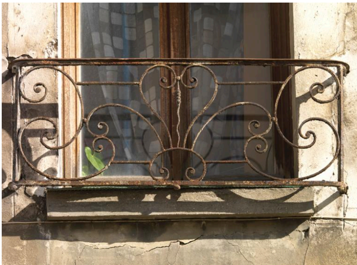
Détail du garde-corps en serrurerie du XVIIIe siècle, au-dessus du porche.
