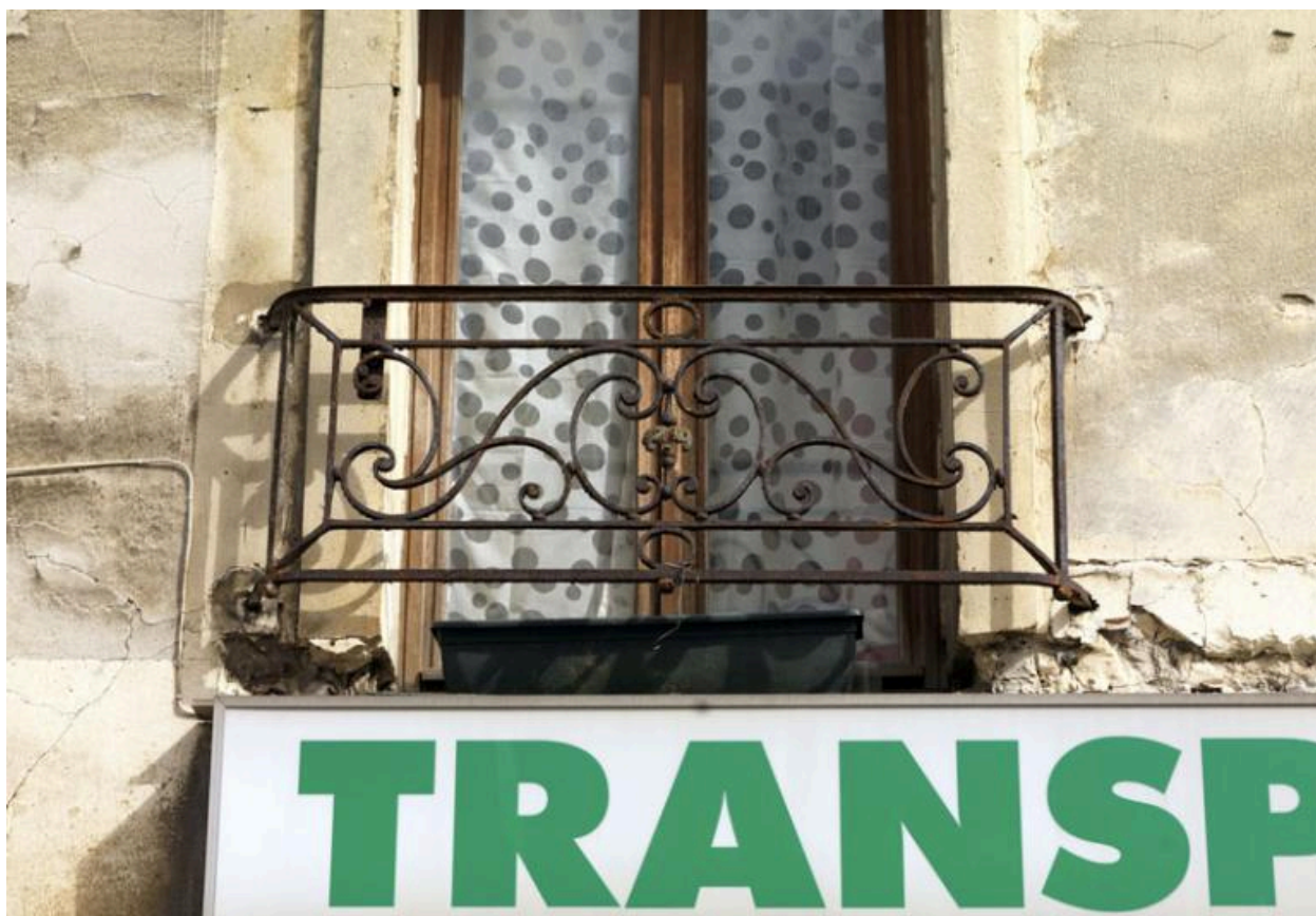
Détail d'un garde-corps.
