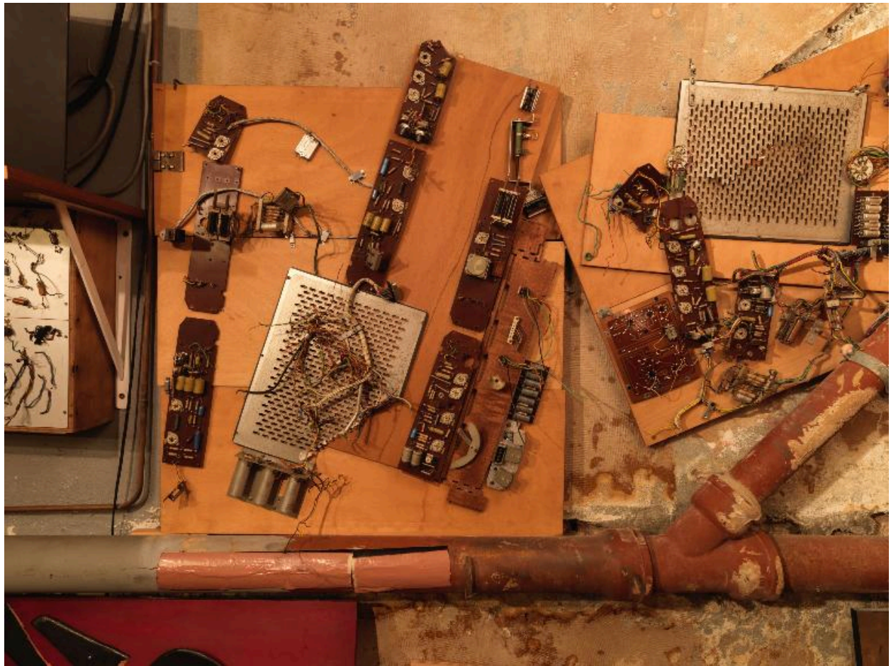
Détail d'assemblage d'objets (pièce en renforcement, sous-sol)
