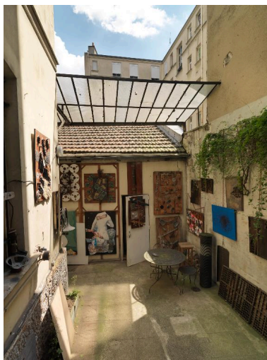
Cour intérieure de la maison Phot. Philippe Ayrault IVR11_20187500355NUC4
