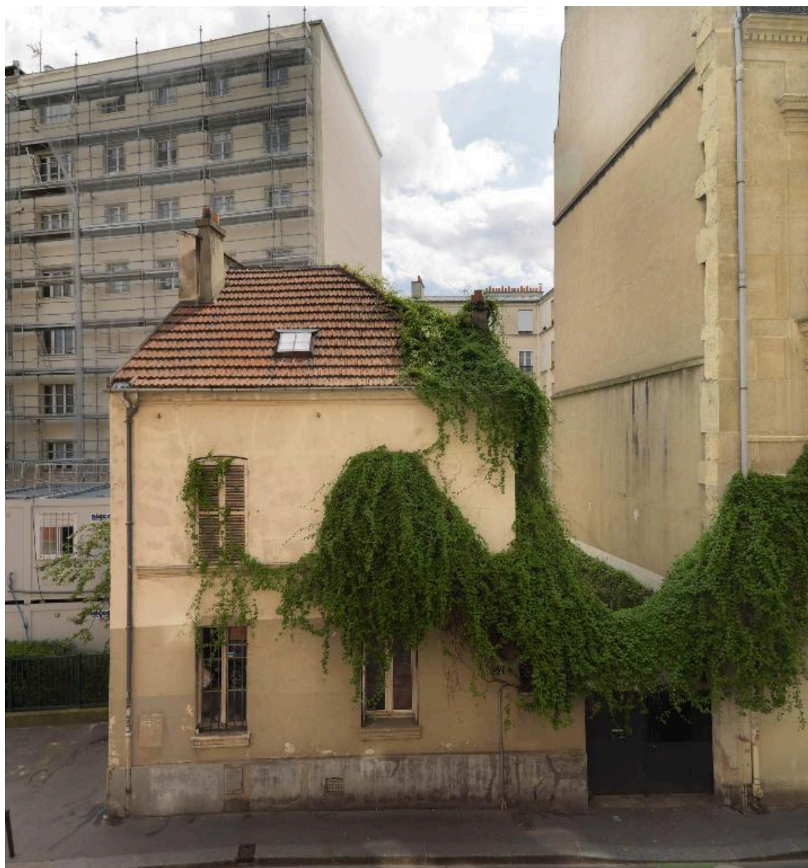
Entrée du 32 rue de Toul (2)
