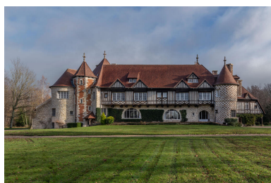
Vue générale de la façade antérieure, marquée par ses jeux de volumes et de couleur. Le corps de logis barlong est encadré, côté sud d'une tour ronde à damier, et au nord, de deux tours côte à côte, l'une à pans coupés l'autre ronde, un peu plus basse. IVR11_20237701004NUC4A
