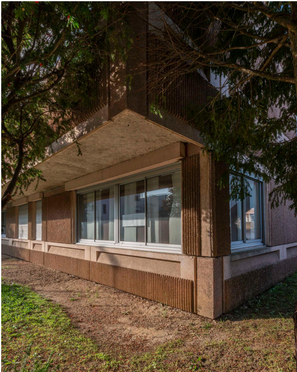
L'angle du bâtiment de l'administration.
