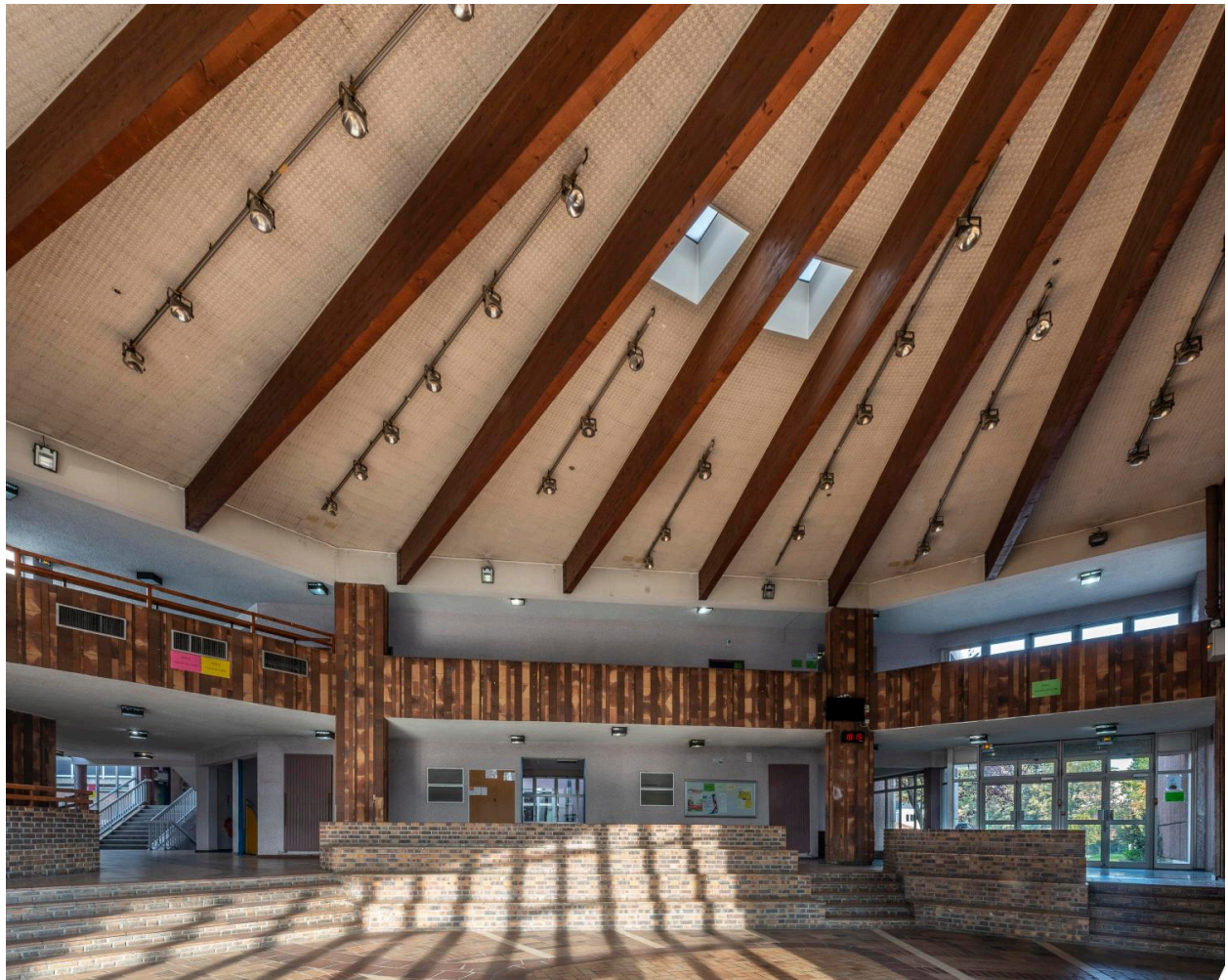
La charpente rayonnante du hall d'entrée.
