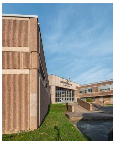
Au premier plan, l'habillage des façades est bien visible ; elles sont revêtues de panneaux de parement en béton rose cannelés à agrégats apparents.
