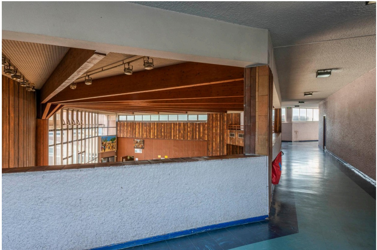
Le hall d'entrée vu depuis le premier étage, avec sa charpente apparente en bois lamellé-collé.
