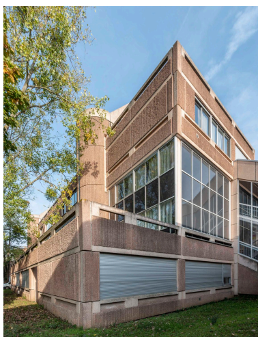
Les angles du bâtiment sont traités de manière saillante et aiguë. Phot. Philippe Ayrault IVR11_20209500196NUC4A
