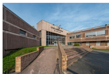
L'entrée du lycée. A gauche, sont visibles, sur le mur, les panneaux de parement en béton rose cannelés à agrégats apparents, qui habillent les façades de l'établissement. Phot. Philippe Ayrault IVR11_20209500185NUC4A
