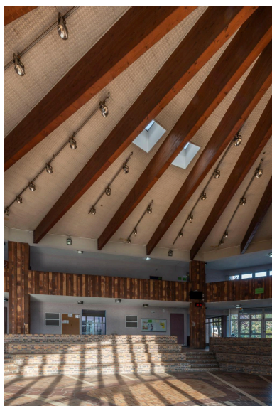
Détail de la charpente du hall. Phot. Philippe Ayrault IVR11_20209500180NUC4A
