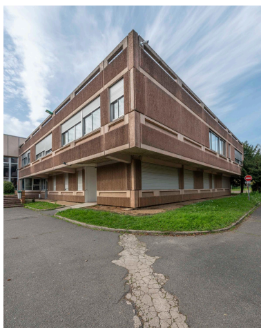
La mise en œuvre des panneaux sur les façades. Le statut dérogatoire des villes nouvelles a permis à l'architecte Létia de s'affranchir de la trame de 1,75 m au profit d'une trame constructive plus large de 14,40 m. Phot. Philippe Ayrault IVR11_20209500213NUC4A
