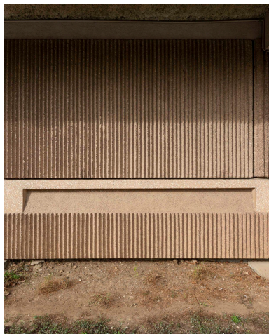
Détail d'un panneau de parement en béton rose cannelé.
