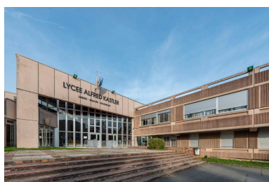
L'entrée du lycée, qui tourne le dos au quartier de la préfecture. Phot. Philippe Ayrault IVR11_20209500184NUC4A
