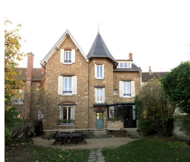
Façade sur jardin. Phot. Laurent Kruszyk IVR11_20167800755NUC4A
