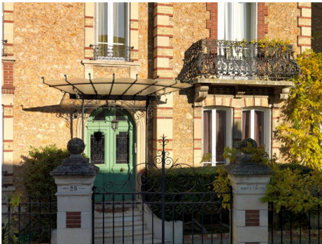
Détail de la marquise d'entrée et du balcon de l'étage.
