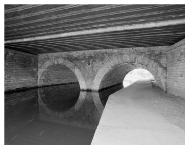
Vue de l'ancien pont, côté ville, élargi au milieu du 20 e siècle. Phot. Philippe Ayrault IVR11_20029101077X
