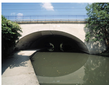
Vue d'ensemble, côté Seine. Ce pont à une seule arche a doublé en 1905 le viaduc à deux arches de 1841. Phot. Philippe Ayrault IVR11_20029101074XA
