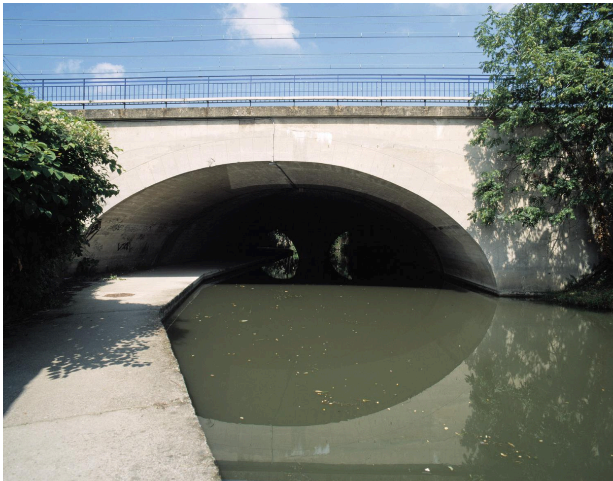
Vue d'ensemble, côté Seine. Ce pont à une seule arche a doublé en 1905 le viaduc à deux arches de 1841.
