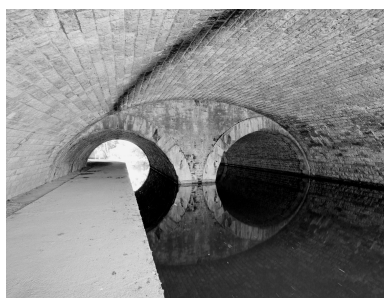
Les deux arches de l'ancien pont (1841), doublé par un pont à arche unique en 1905. Côté Seine. Phot. Philippe Ayrault IVR11_20029101076X
