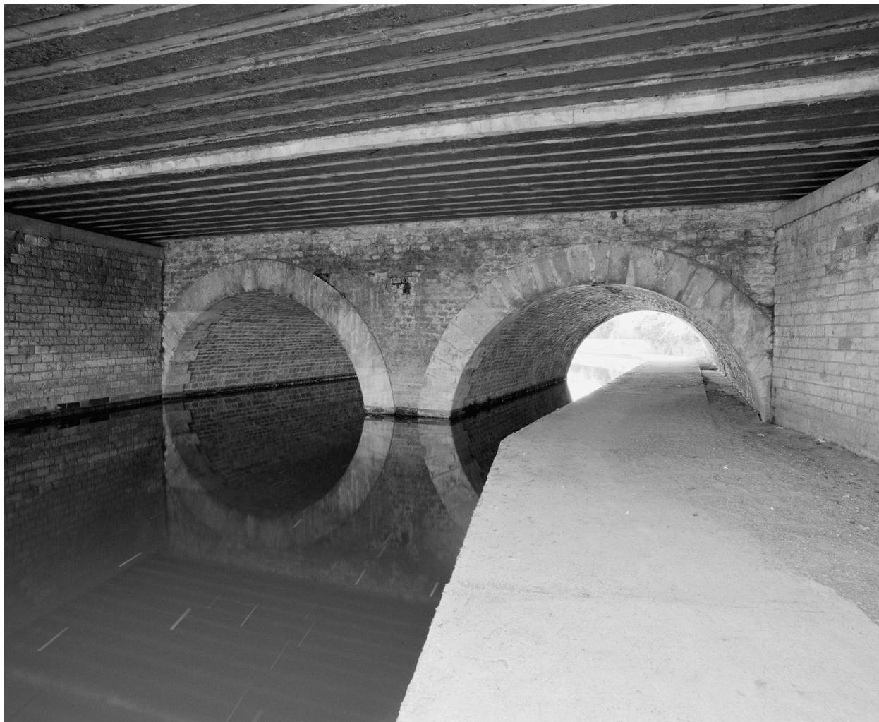
Vue de l'ancien pont, côté ville, élargi au milieu du 20e siècle.
