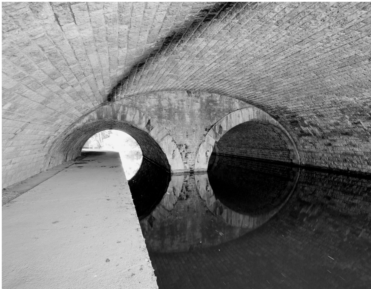
Les deux arches de l'ancien pont (1841), doublé par un pont à arche unique en 1905. Côté Seine.
