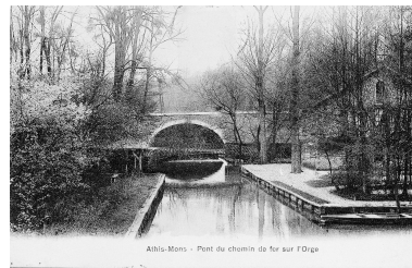
Vue du pont à arche unique construit en 1905 pour le doublement des voies du P.O., à l'avant du pont ancien à deux arches. IVR11_20029101176X
