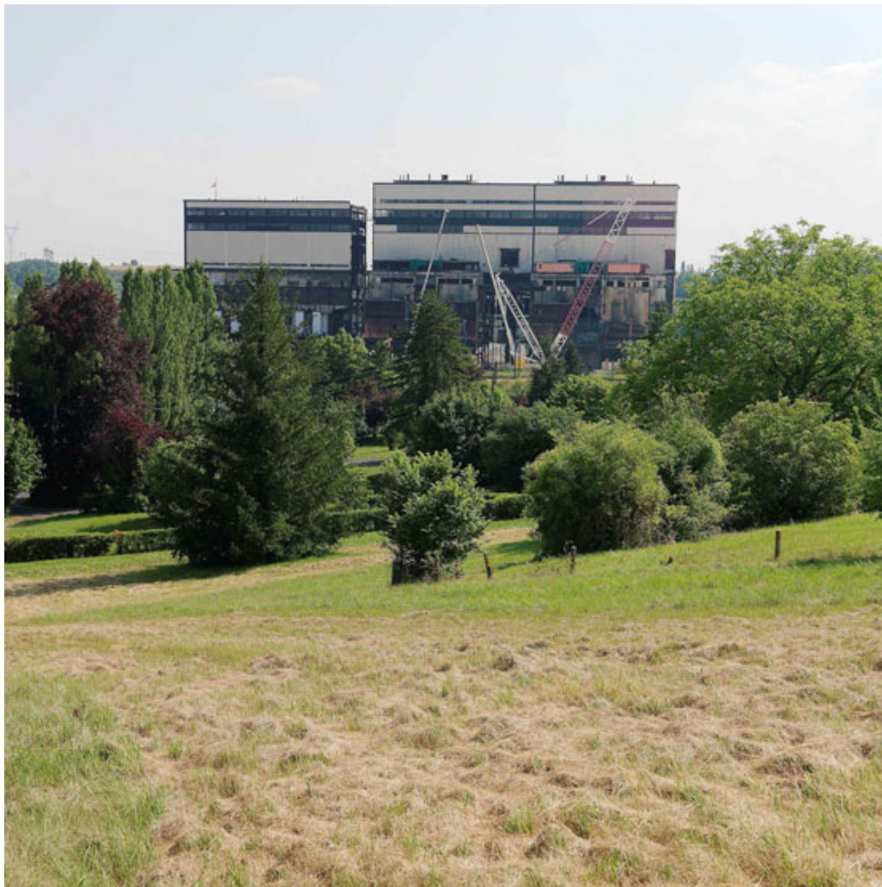
Chantier de démolition de la centrale.
