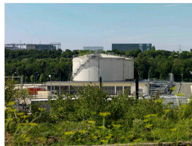
Les nouveaux TAC. Phot. Philippe Ayrault IVR11_20147700386NUC4A
