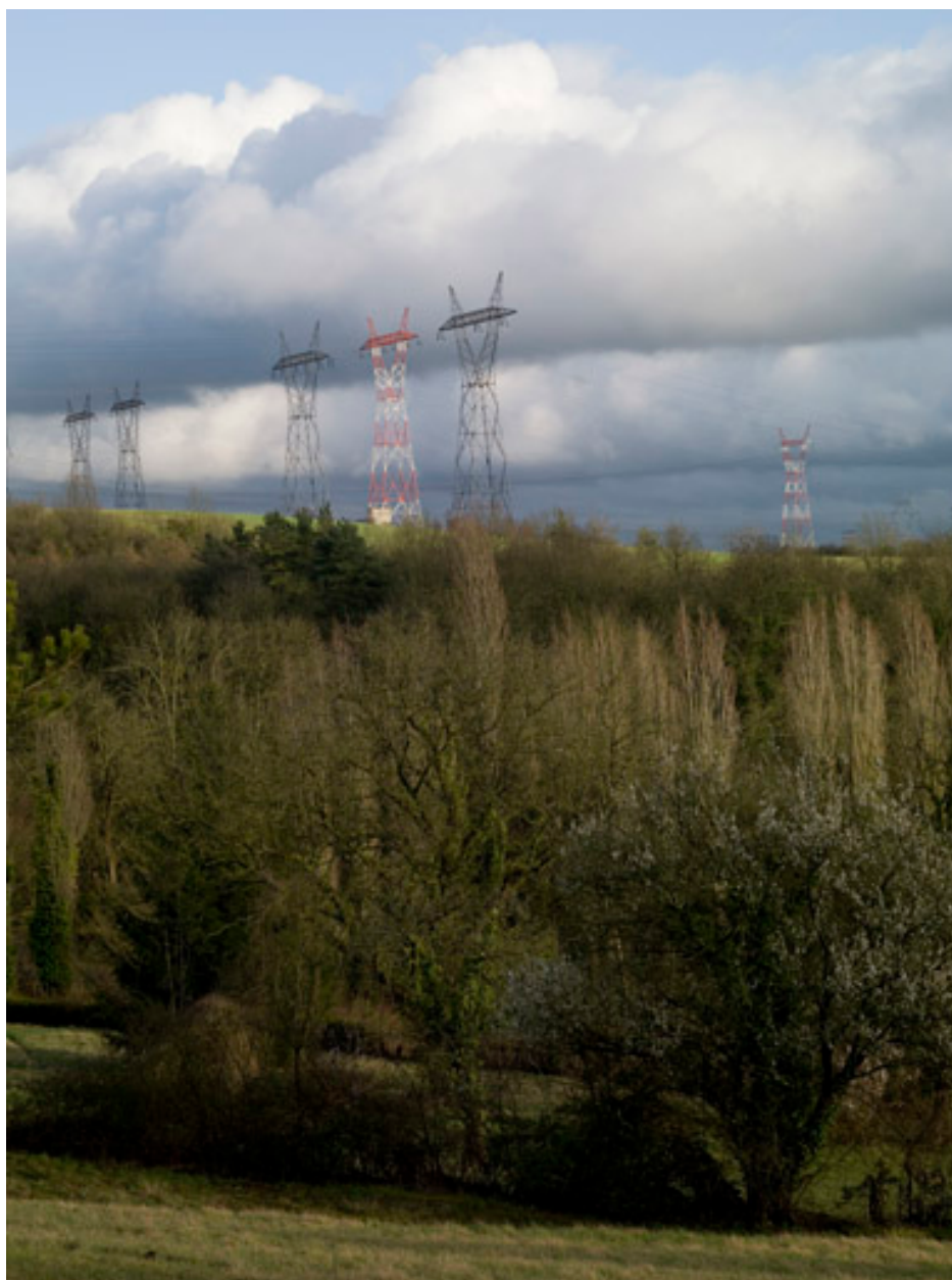
Pylones lignes haute tension.
