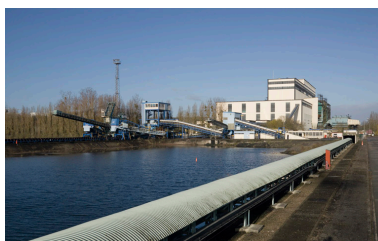
Parc à charbon. Bâtiment de manutention. Phot. Philippe Ayrault IVR11_20087700462NUC4A
