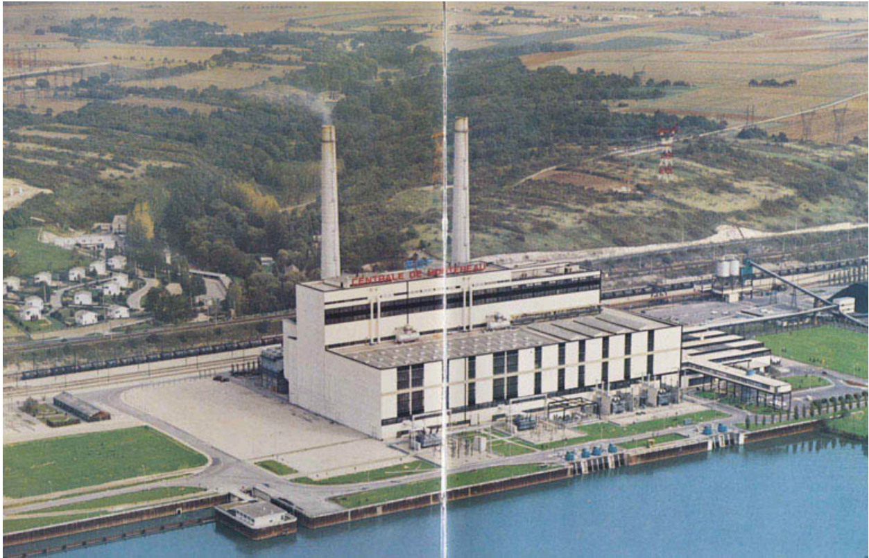
vue aerienne de la centrale
