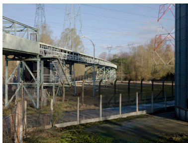
Parc à charbon. Phot. Philippe Ayrault IVR11_20087700459NUC4A
