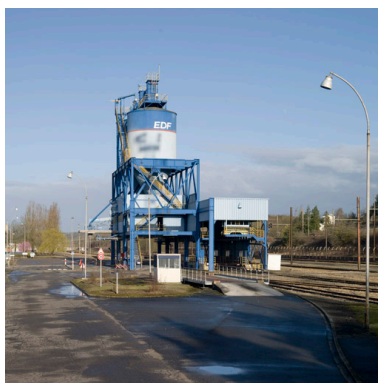
Réservoirs de fuel. Phot. Philippe Ayrault IVR11_20087700471NUC4A
