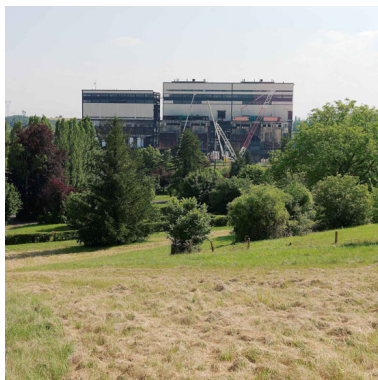
Chantier de démolition de la centrale. Phot. Philippe Ayrault IVR11_20127500584NUC4A
