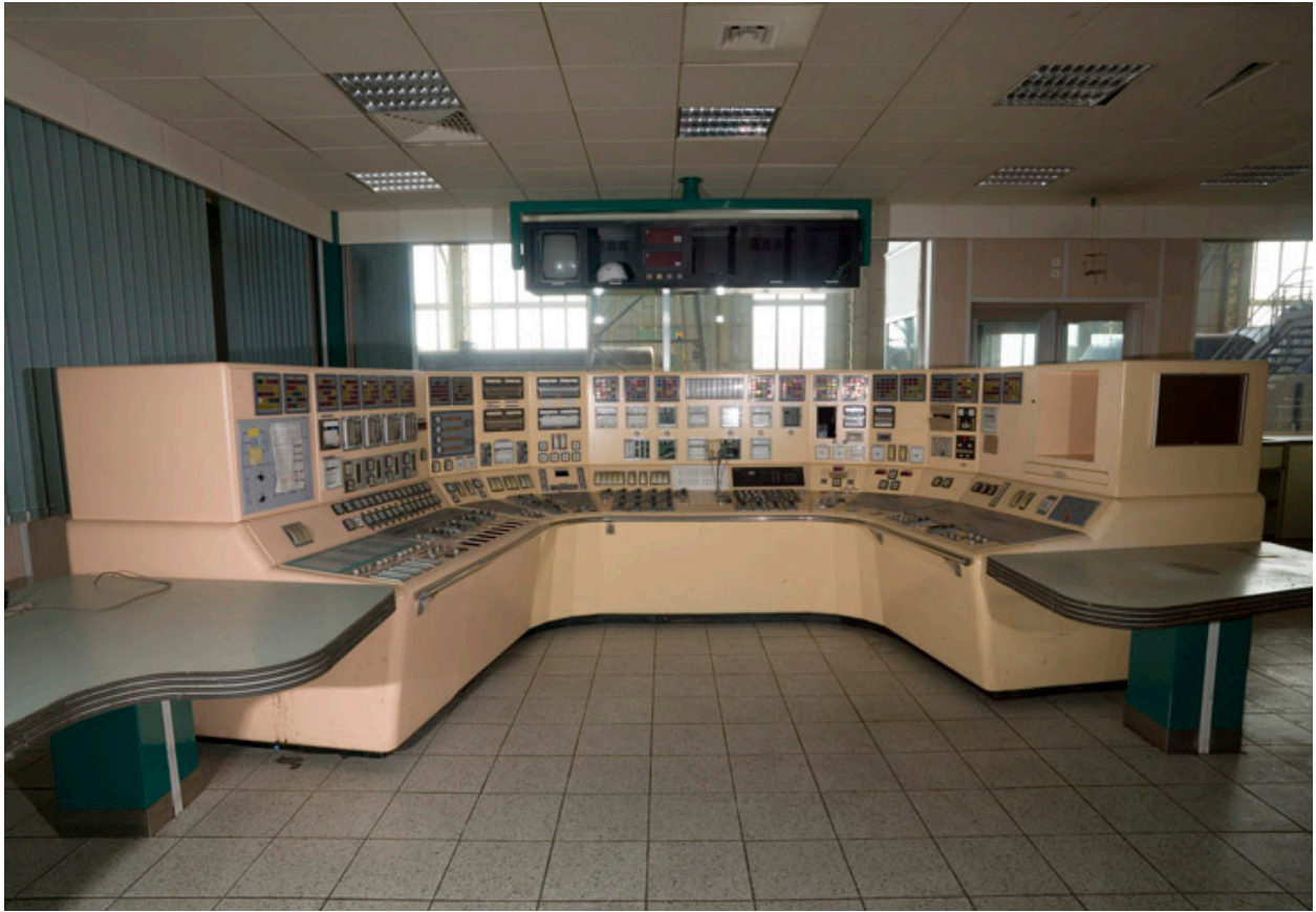
Salle de commandes. Pupitre de commande tranche 250 MW.
