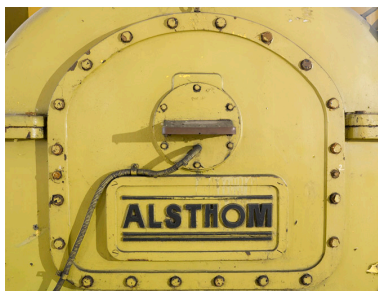
Poste d'eau tranche 125 MW. Turbine de construction Alsthom. Phot. Philippe Ayrault IVR11_20087700516NUC4A
