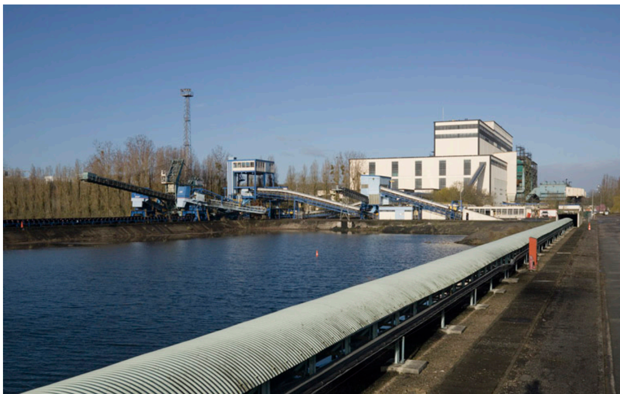
Parc a charbon. Bâtiment de manutention.
