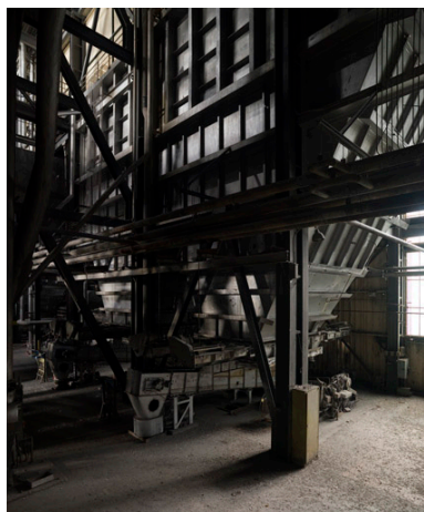
Générateur de vapeur groupe 125MW. Tremie a charbon. Phot. Philippe Ayrault IVR11_20087700485NUC4A
