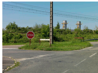
Les nouveaux TAC. Phot. Philippe Ayrault IVR11_20147700383NUC4A
