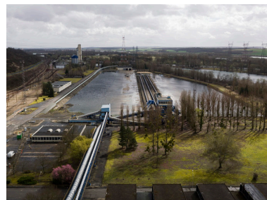
Parc à charbon. Phot. Philippe Ayrault IVR11_20087700457NUC4A
