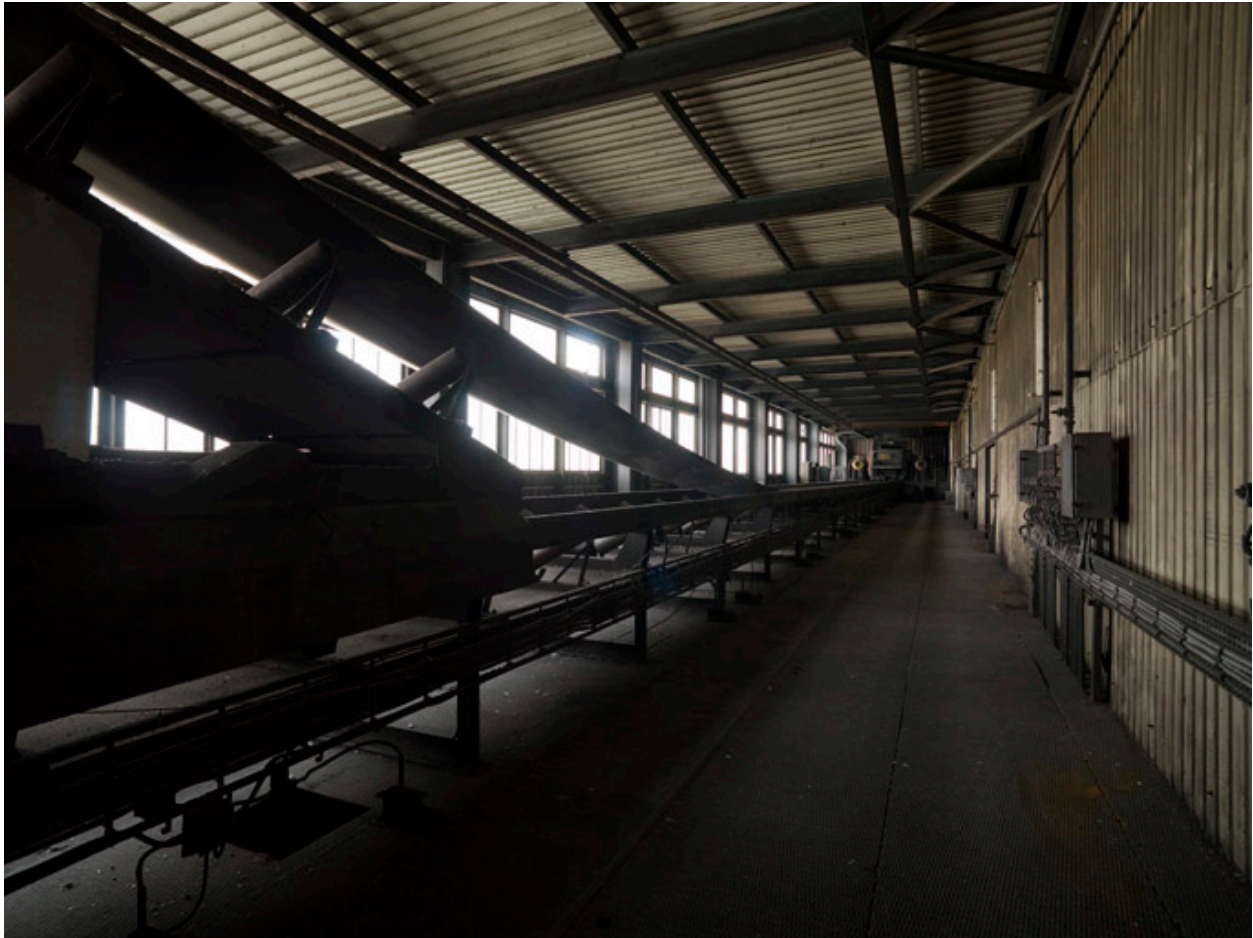
Générateur de vapeur groupe 125MW. Convoyeur de charbon.
