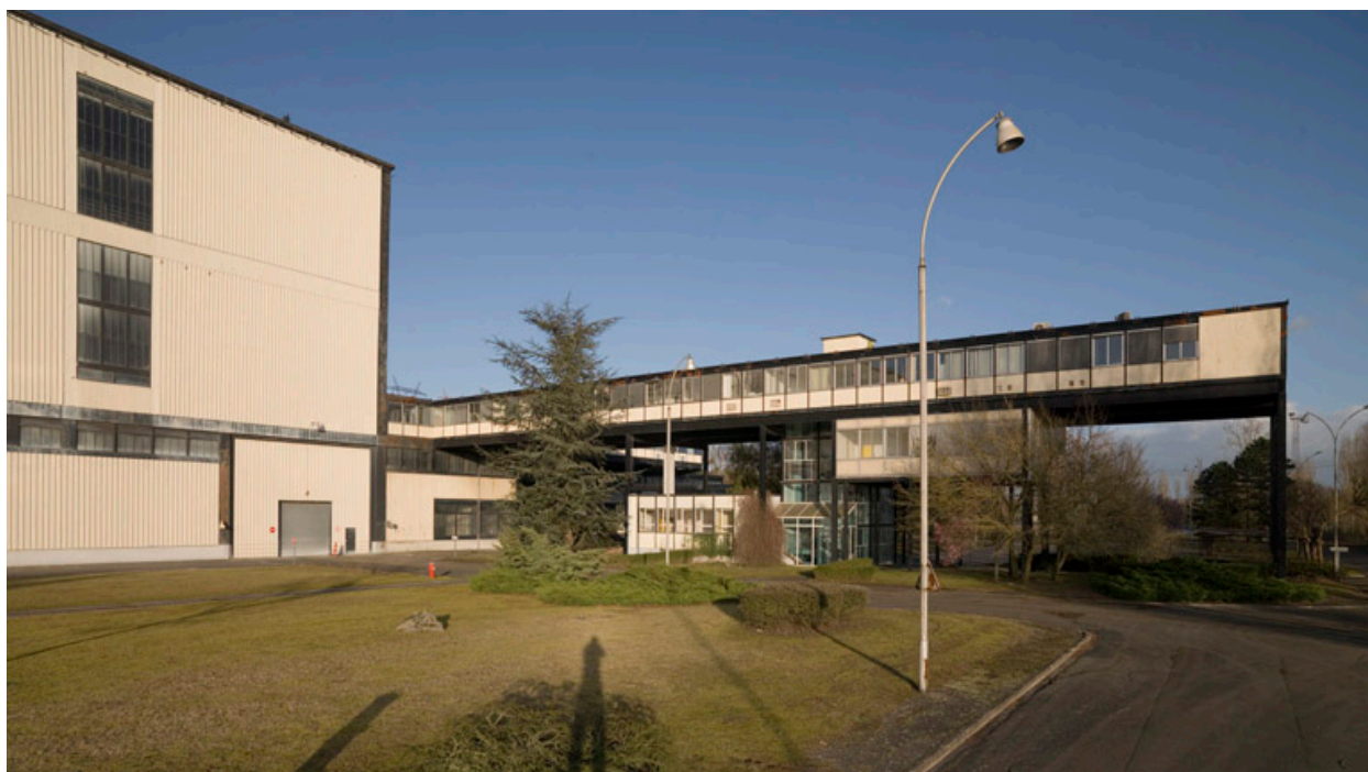
Vue extérieure. Bâtiment des bureaux
