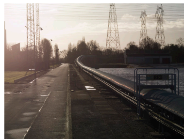
Parc à charbon. Phot. Philippe Ayrault IVR11_20087700460NUC4A
