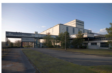
Vue extérieure. Laboratoire et bureaux Phot. Philippe Ayrault IVR11_20087700450NUC4A
