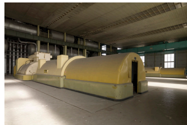
Poste d'eau tranche 125 MW. Turbine de construction Alsthom. Phot. Philippe Ayrault IVR11_20087700515NUC4A
