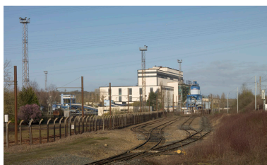
Vue extérieure. au premier plan, voie ferrée. Phot. Philippe Ayrault IVR11_20087700447NUC4A
