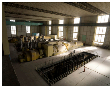
Poste d'eau tranche 125 MW. Turbine de construction Alsthom. Phot. Philippe Ayrault IVR11_20087700512NUC4A
