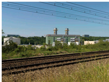
Les nouveaux TAC. Phot. Philippe Ayrault IVR11_20147700385NUC4A
