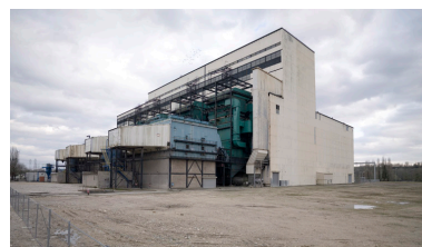
Vue extérieure arrière du bâtiment. Phot. Philippe Ayrault IVR11_20087700448NUC4A
