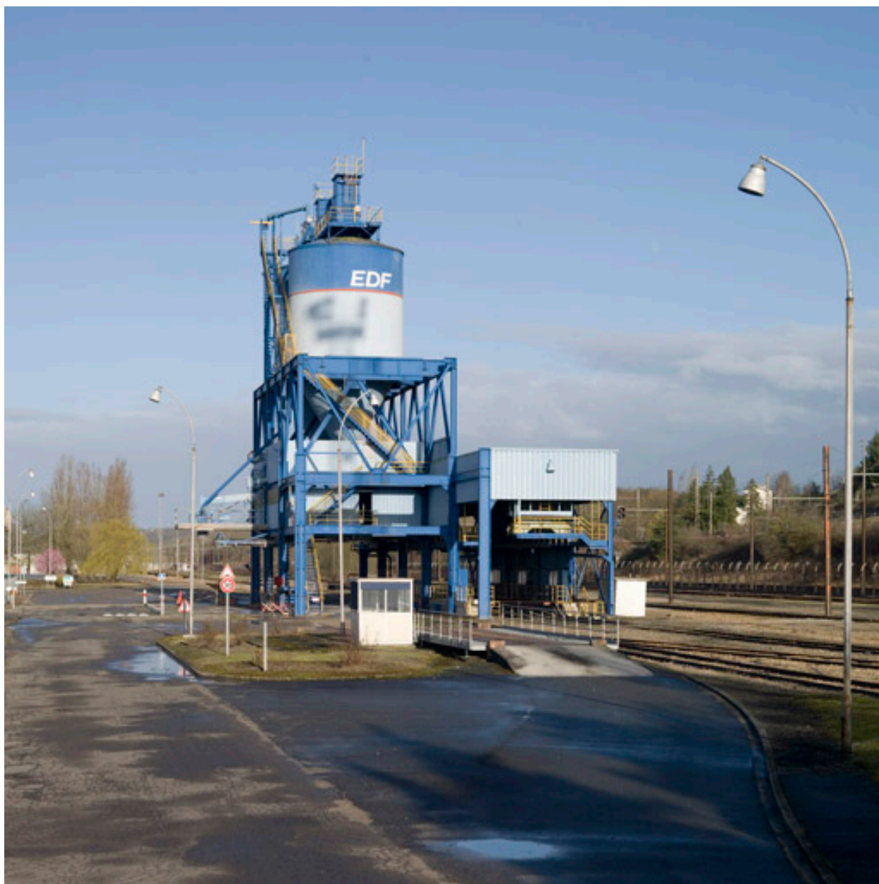
Réservoirs de fuel.
