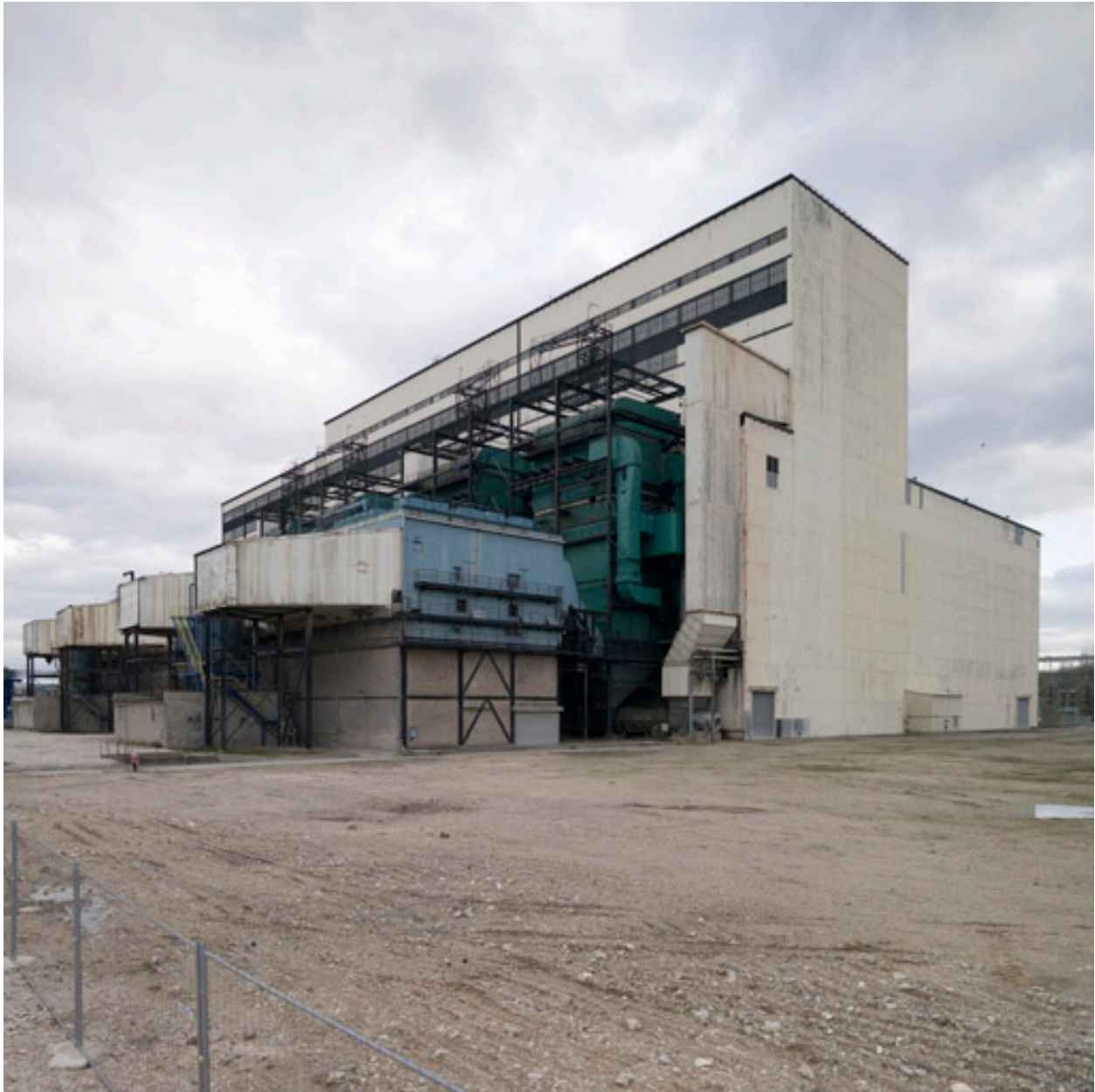
Vue extérieure. arriere du bâtiment.
