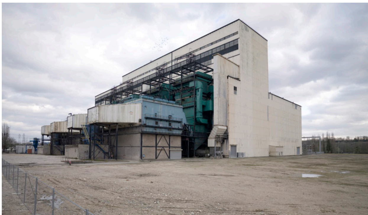
Vue extérieure arrière du bâtiment.
