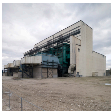
Vue extérieure. arrière du bâtiment. Phot. Philippe Ayrault IVR11_20087700449NUC4A
