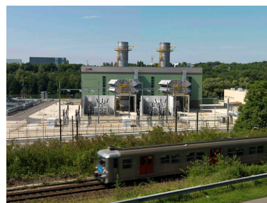
Les nouveaux TAC. Phot. Philippe Ayrault IVR11_20147700388NUC4A
