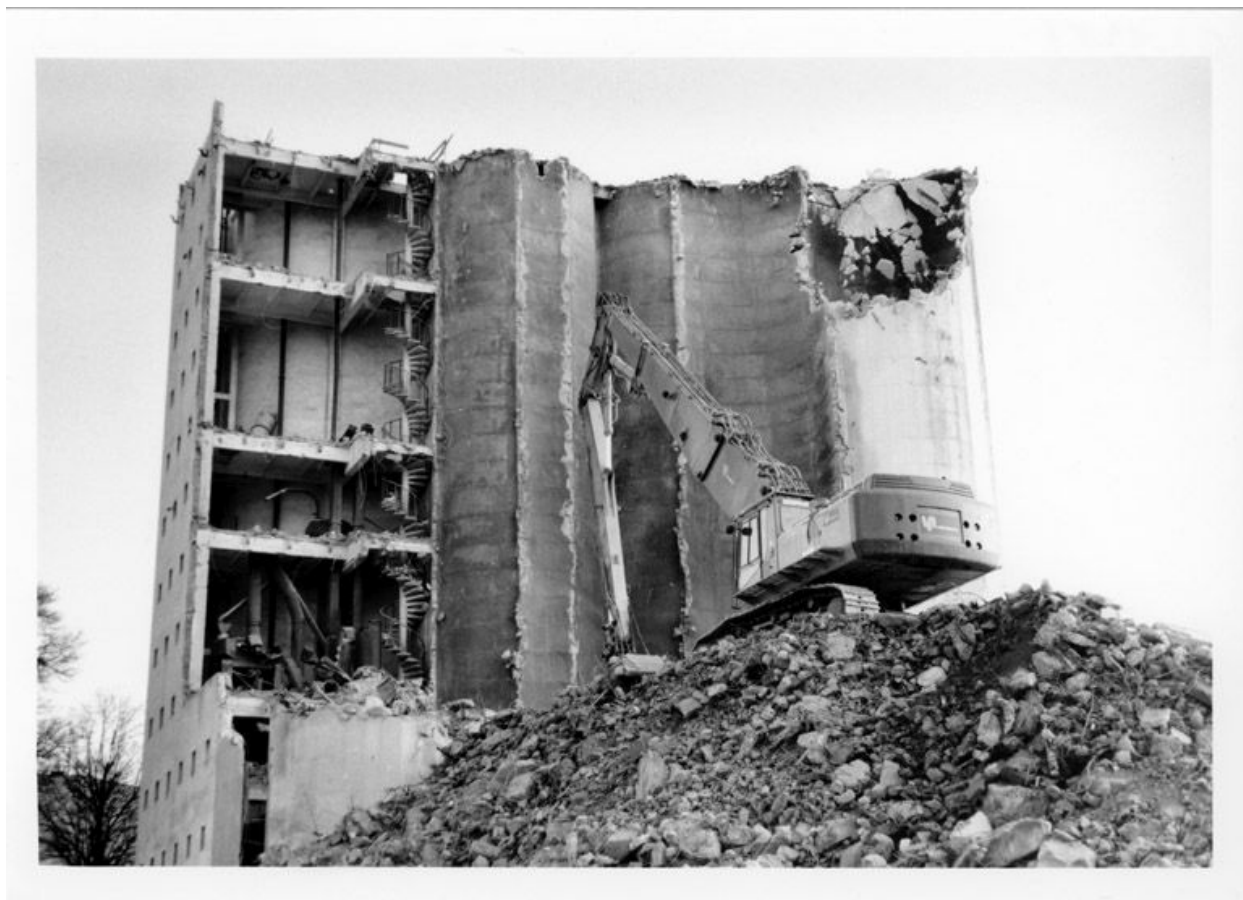
Les silos en cours de démolition. 5 janvier 1999. (Collection particulière)
