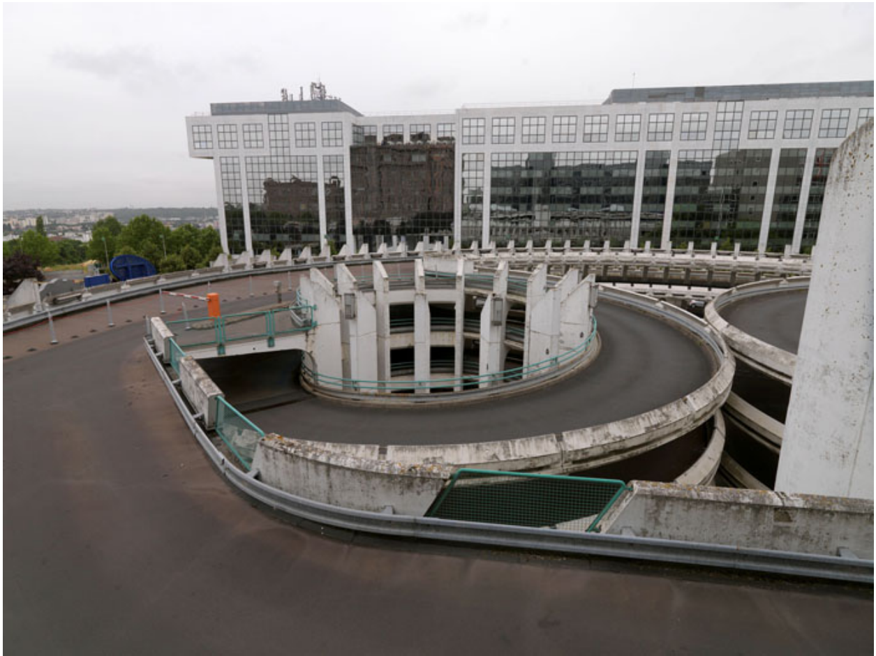
Parking régional du Mont d'Est, 1975-1977. Rampes d'accès.
