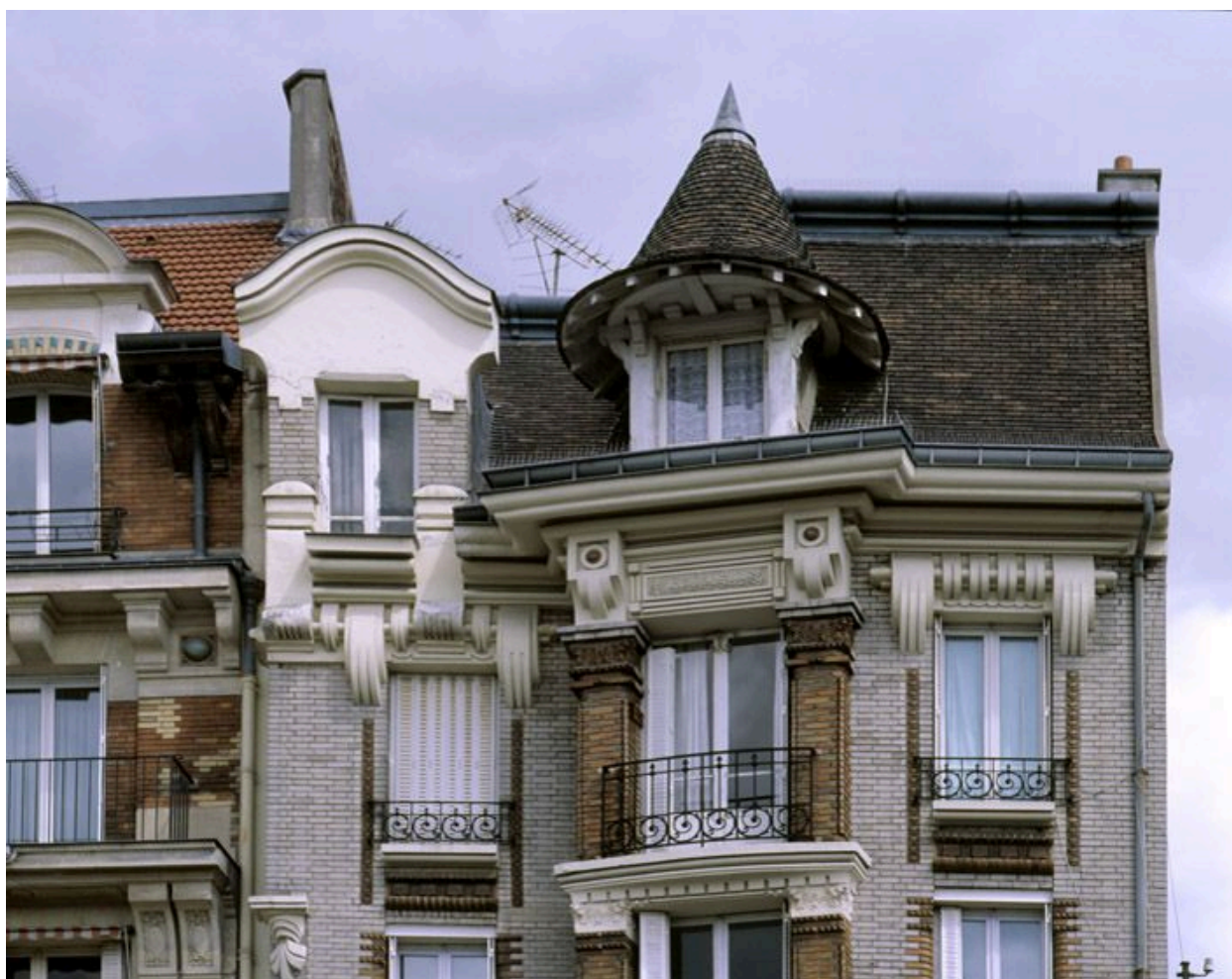
Vue extérieure du dernier étage et de la lucarne lanternon ornant la toiture.
