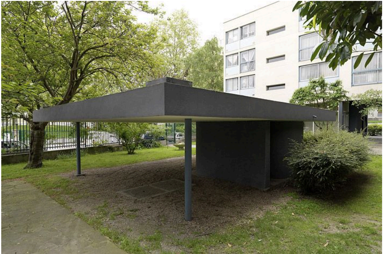
Vitry-sur-Seine, cité, 25-29 rue Camille-Blanc. Local poubelle.
