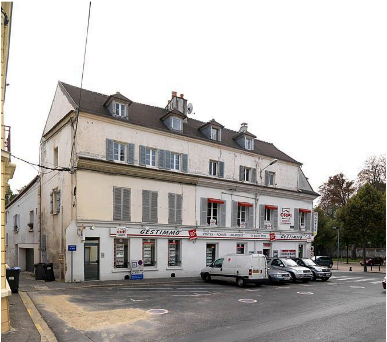
Immeuble à étage d'attique et corniche moulurée au 2, rue Saint-Faron.
