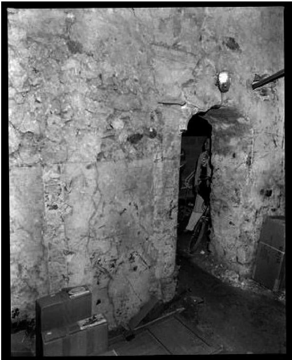
Maison, Marché au blé (place du) 7. Vue de la cave.
