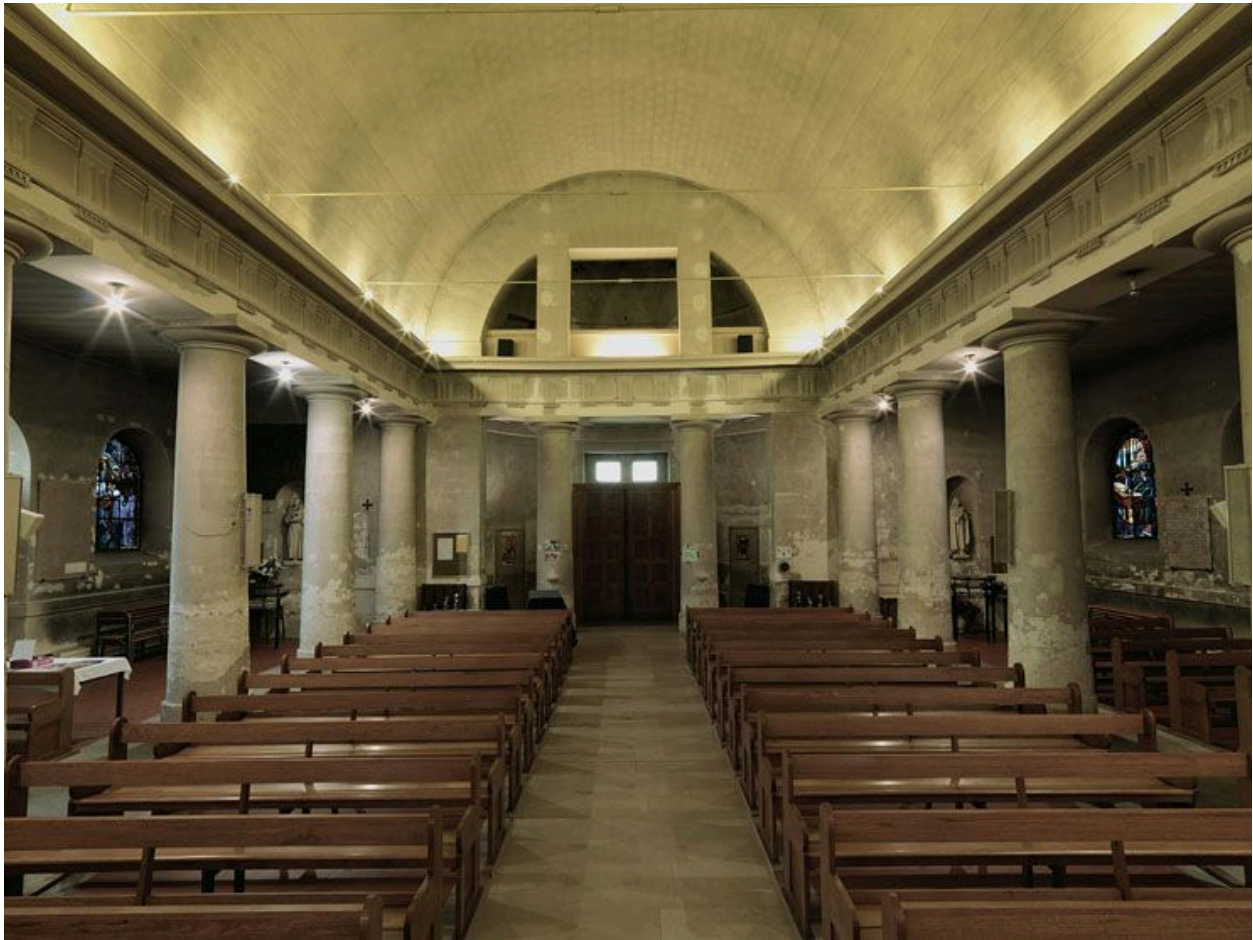
Vue de la nef et du chœur.
