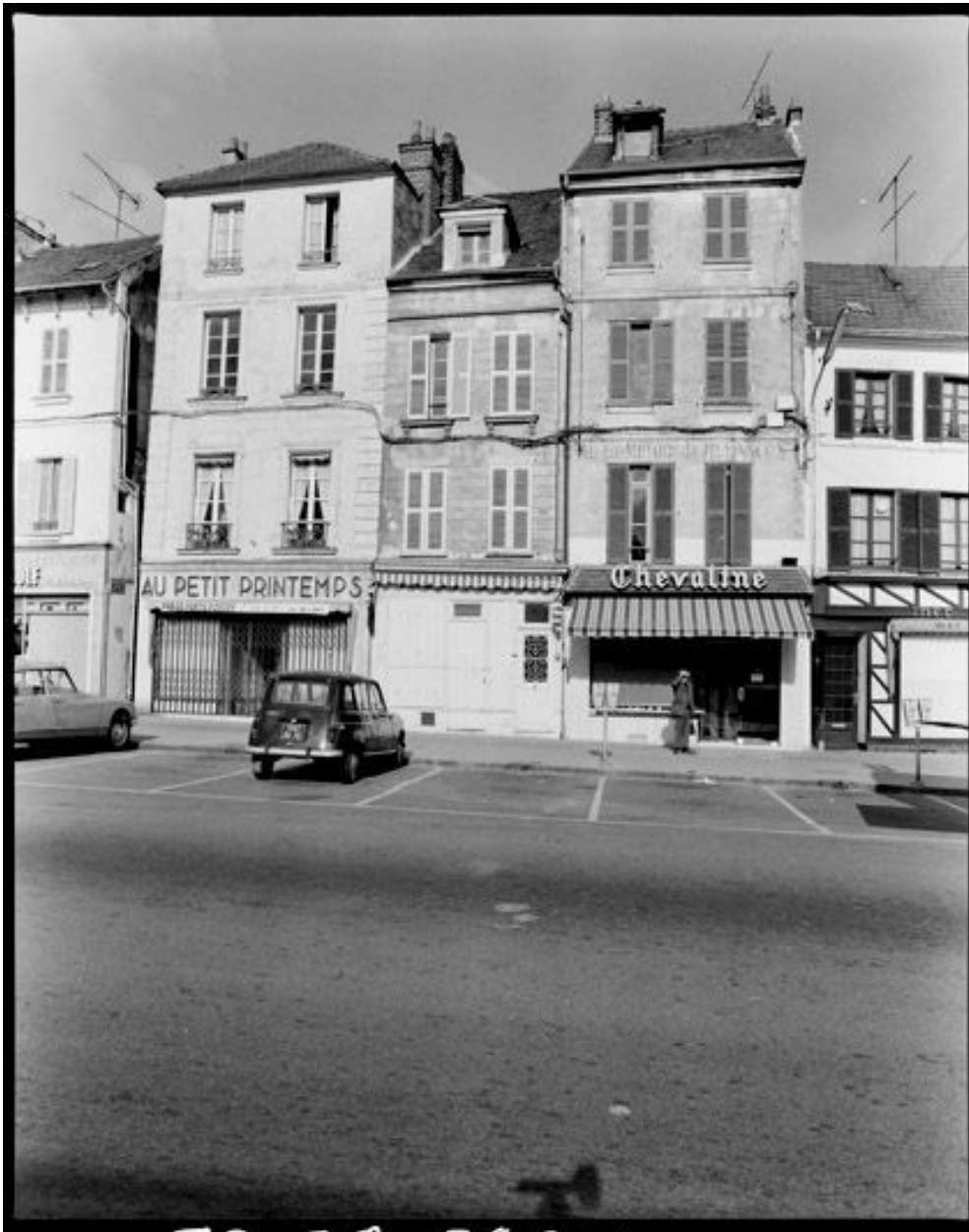
Maison, Thiers (rue) 34. Vue de la façade sur rue.
